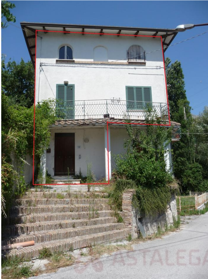
Ingresso da via Buia (civico 29)
