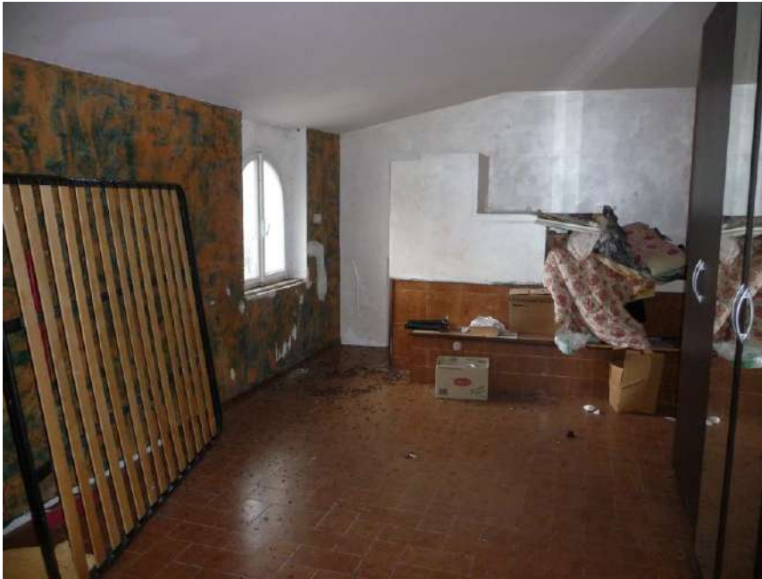
Foto n. 11 Locale su torretta P2
