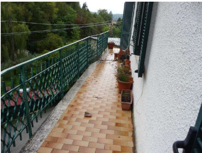
Foto n. 13 Balcone fianco edificio P1
