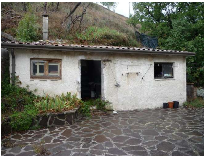
Foto n. 17 Magazzino su corte esterna
