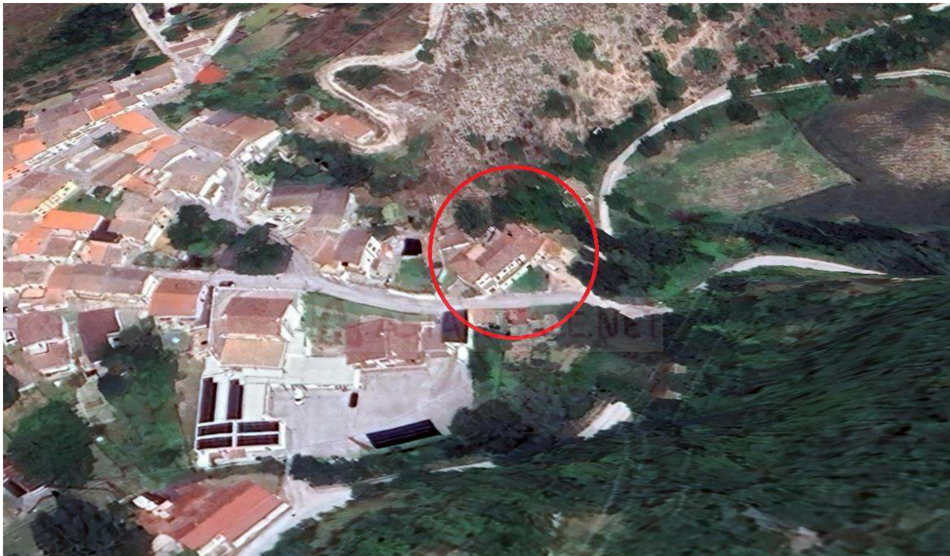
Foto n. 1 Vista aerea (da google earth)
