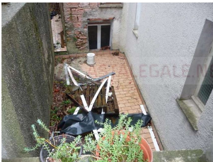
Foto n. 15 Terrazza retro edificio
