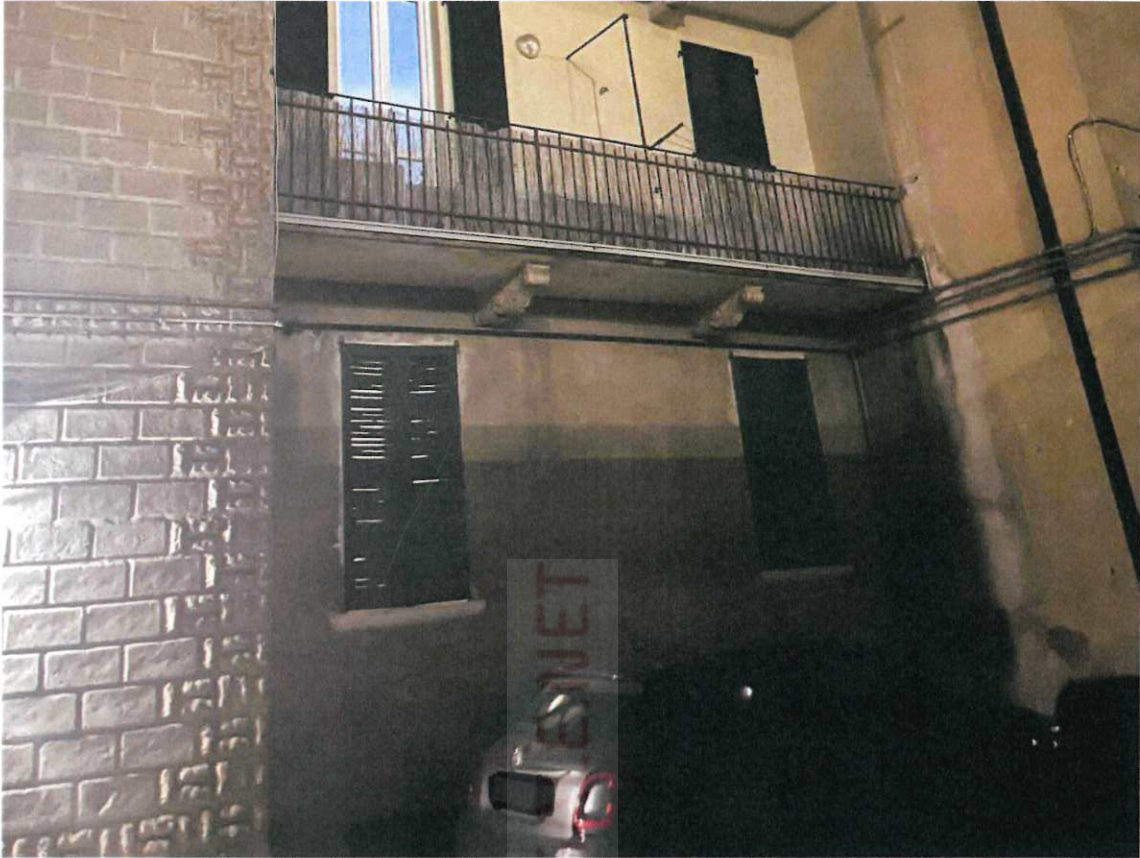
Vista dal cortile
