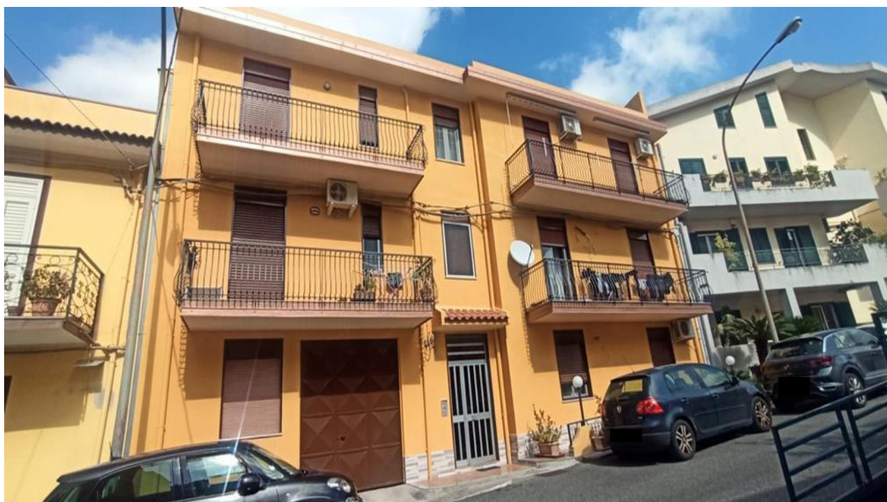
Foto 1 Prospetto principale via Roma Lato Nord
