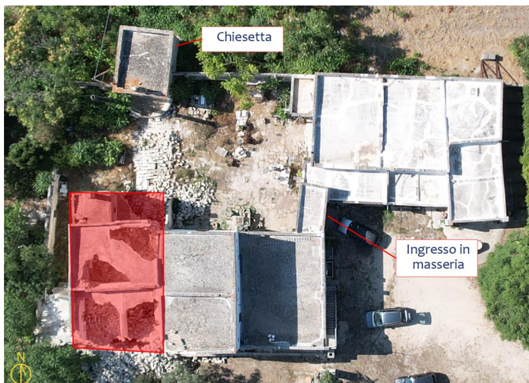
Figura 4: Individuazione fabbricato crollato
