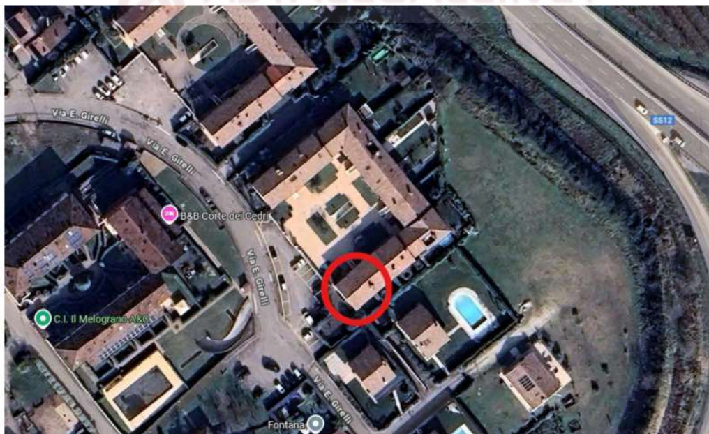
vista d'insieme del Condominio con indicata la posizione dell'appartamento
