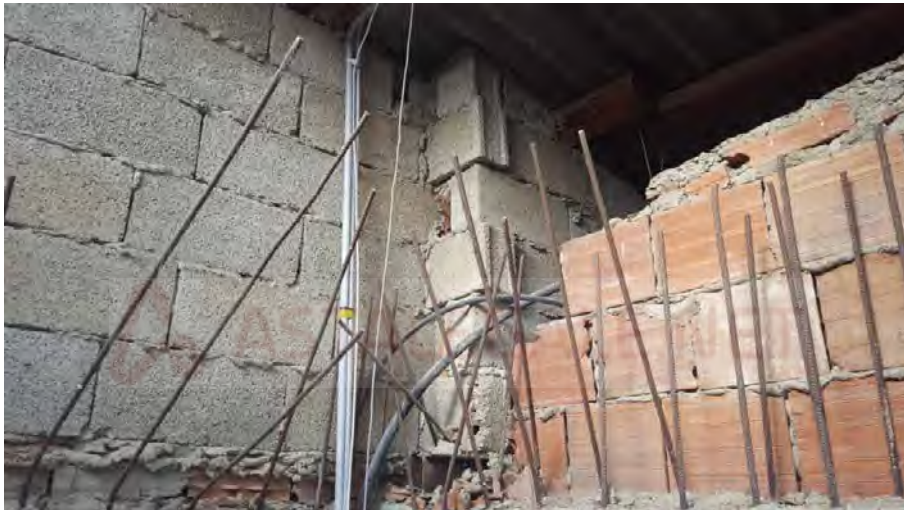
Foto N. 30: Sottotetto. Lotto L3
