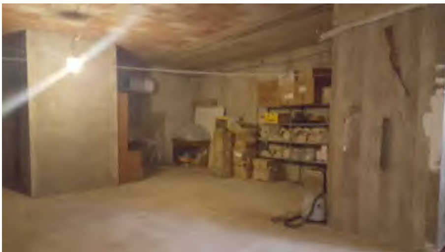
Foto N. 25: Vano n. 2. Piano Primo Lotto L3
