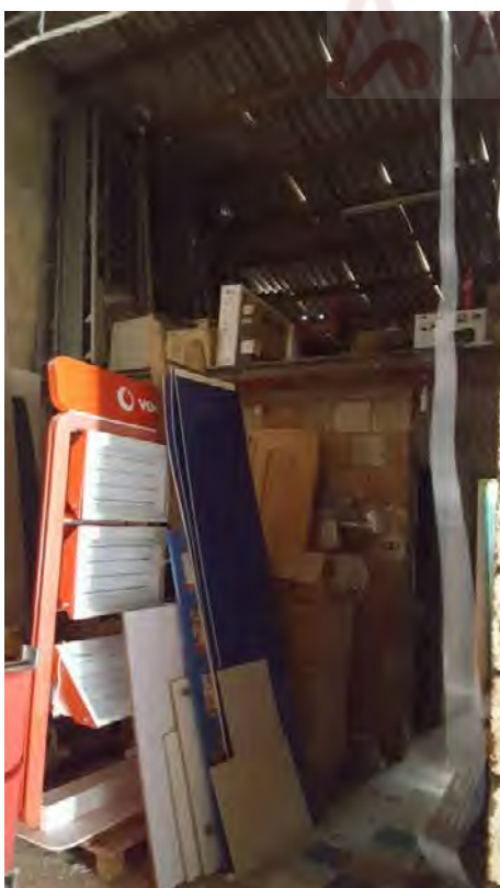
Foto N. 26: Interno del magazzino e controsoffitto Lotto L4
