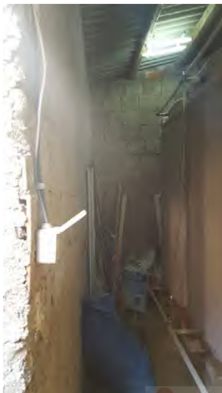
Foto N. 16: Locale idrico da demolire Lotto L4
