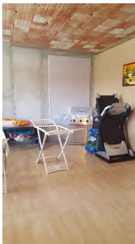
Foto N. 17: Vano n. 1. Piano Primo Lotto L3
