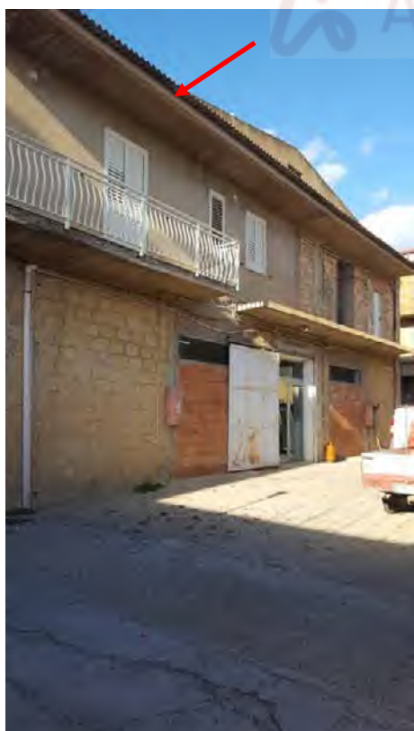
Foto N. 8: Vista Posteriore Dalla Corte comune Lotto L2
