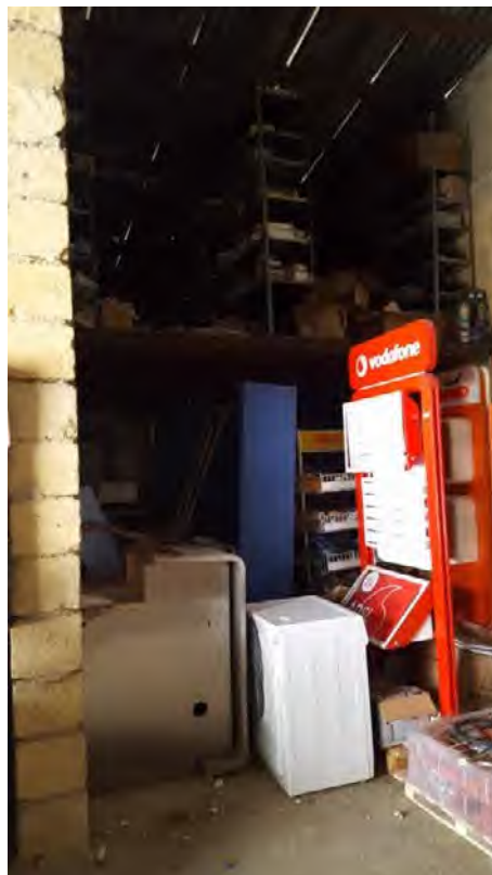
Foto N. 21: Interno del magazzino e controsoffitto Lotto L4
