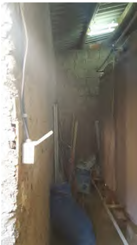
Foto N. 7: Locale idrico da demolire Lotto L4
