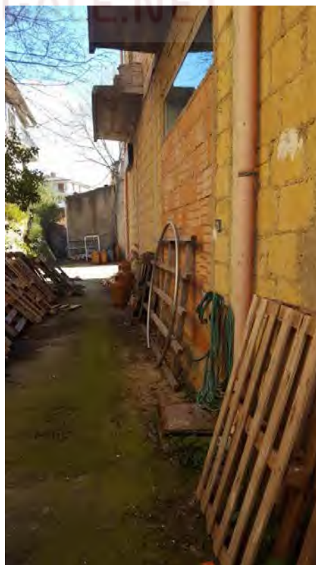
Foto N. 13: Vista laterale sinistra piano terra Lotto L1
