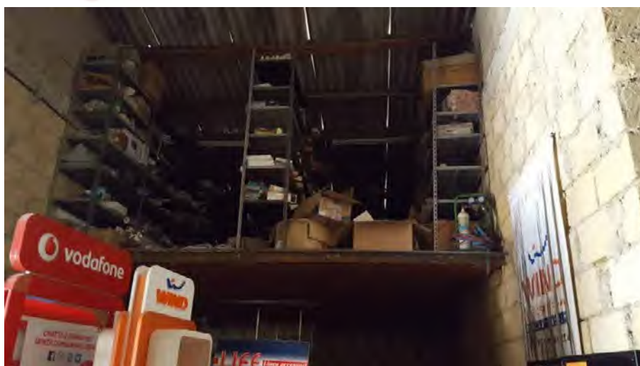
Foto N. 34: Interno del magazzino e controsoffitto Lotto L4
