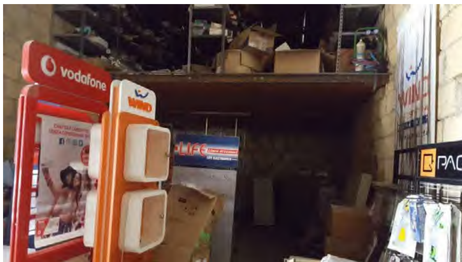
Foto N. 35: Interno del magazzino e controsoffitto Lotto L4
