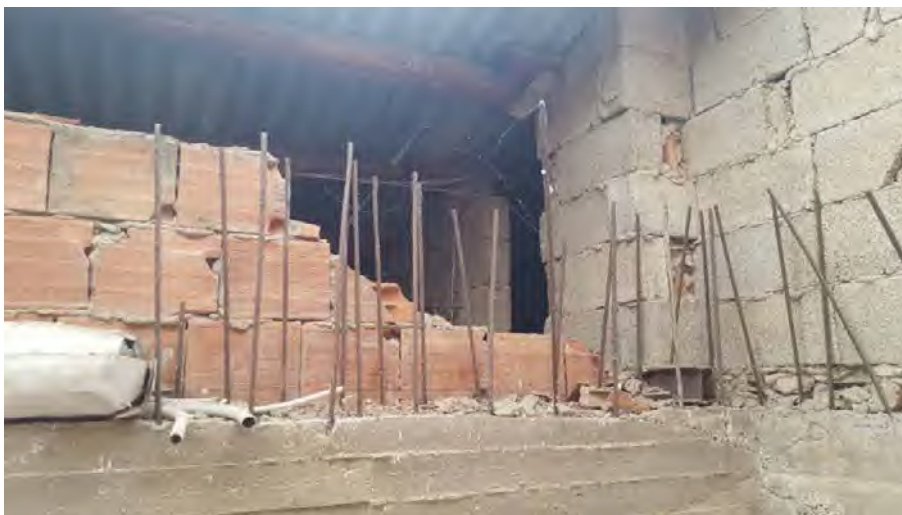
Foto N. 32: Sottotetto. Lotto L3
