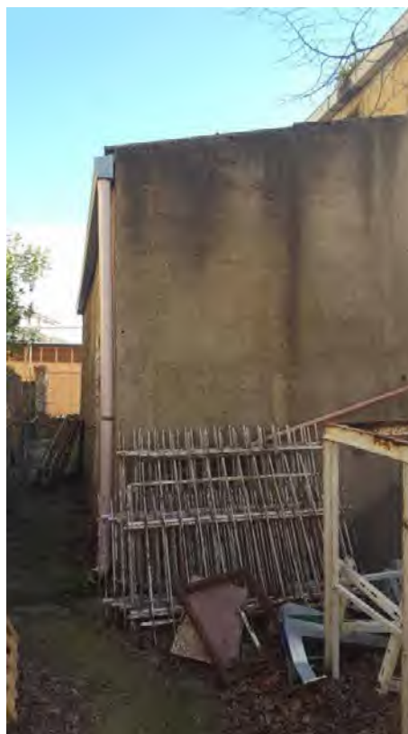
Foto N. 2: Locale Idrico da demolire Lotto L4
