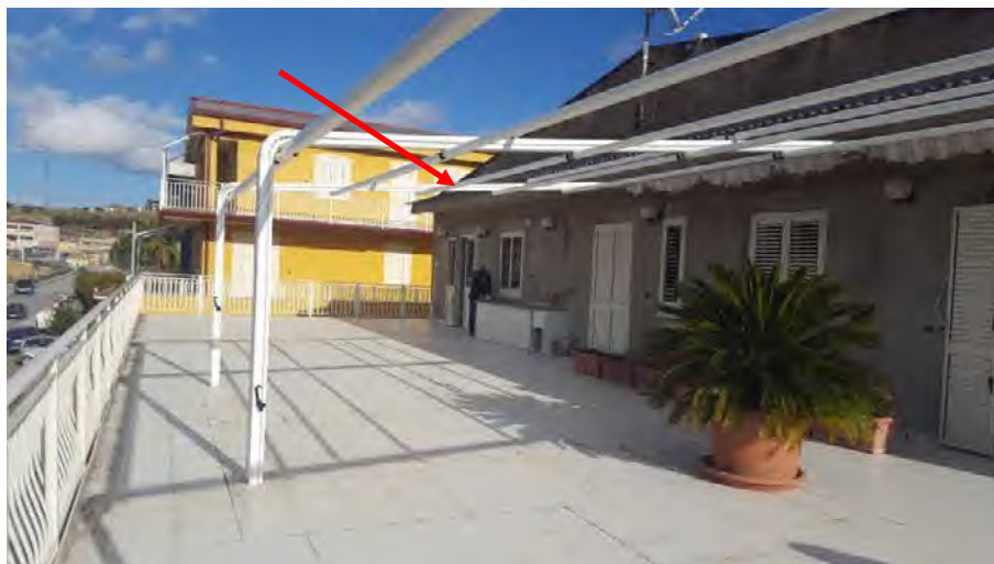
Foto N. 7: Vista Del Terrazzo- Lotto L2-L3
