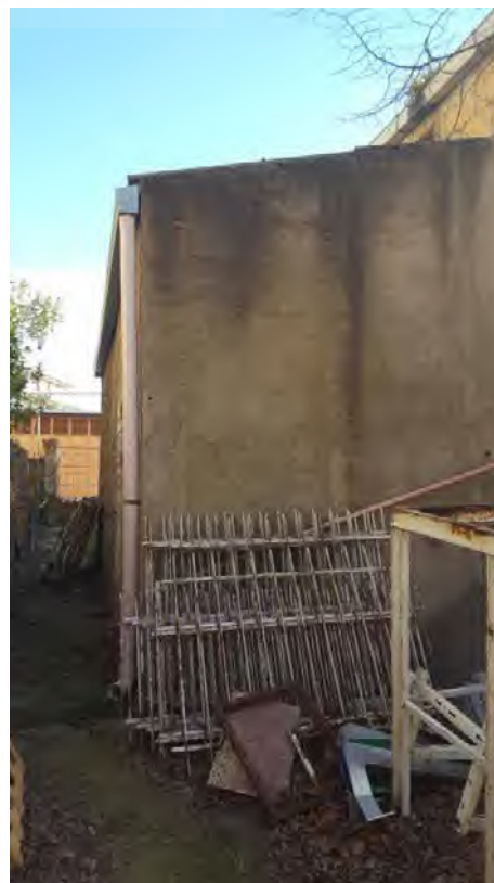
Foto N. 12: Locale Idrico da demolire Lotto L4
