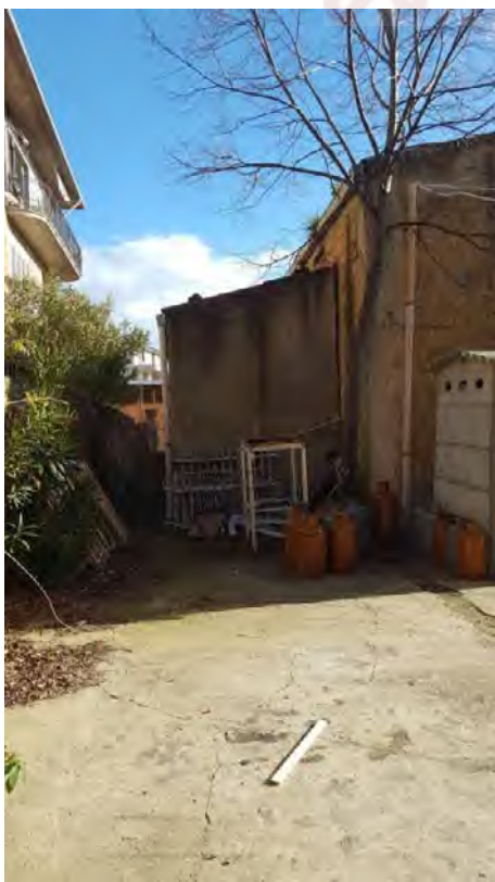
Foto N. 3: Locale Idrico da demolire Lotto L4
