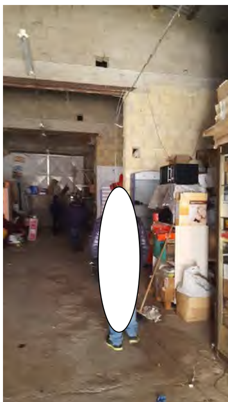
Foto N. 18: Interno del magazzino Lotto L4
