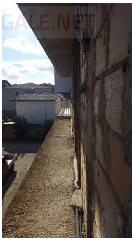
Foto N. 9: Vista Del Balcone Posteriore- Lotto L3
