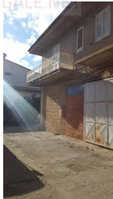
Foto N. 9: Vista Posteriore Dalla Corte Lotto L1-L2-L3
