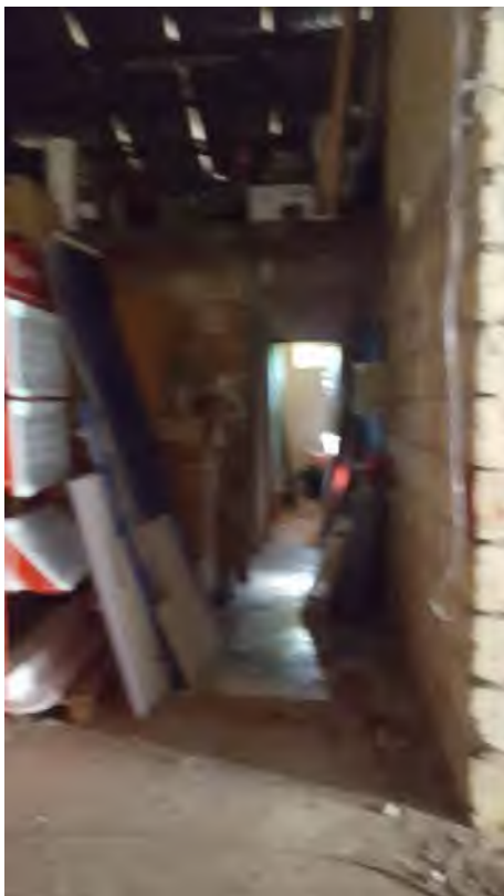
Foto N. 24: Interno del magazzino Lotto L4
