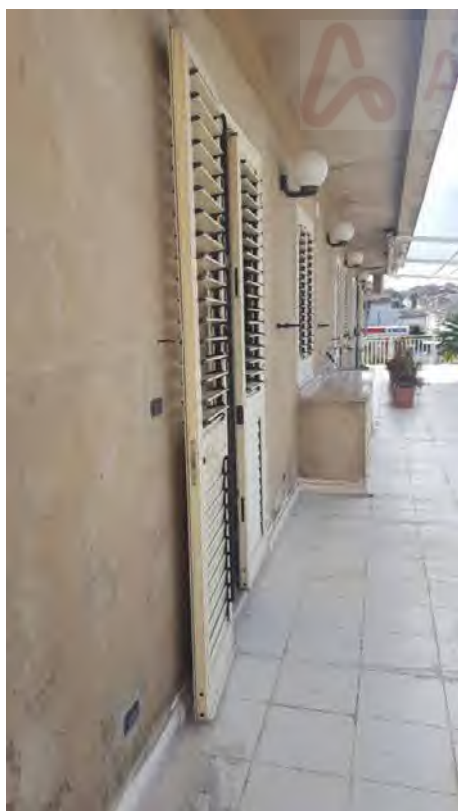
Foto N. 8: Vista Del Prospetto dal Terrazzo- Lotto L3
