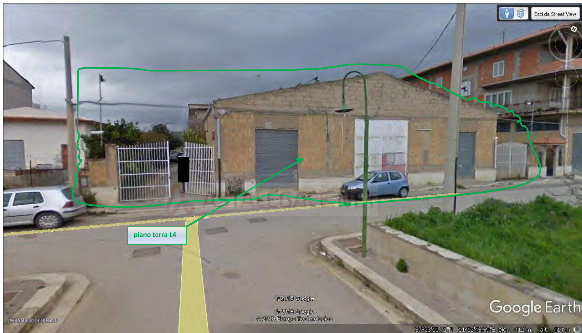
FO- SA- L4- N.6/6 FABBRICATO IN VIA DELLE ROSE -L4 - VISTA DALLA STRADA- PUNTO DI RIPRESA 3
