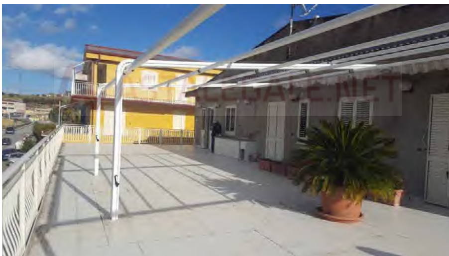
Foto N. 11: Vista Del Terrazzo- Lotto L2
