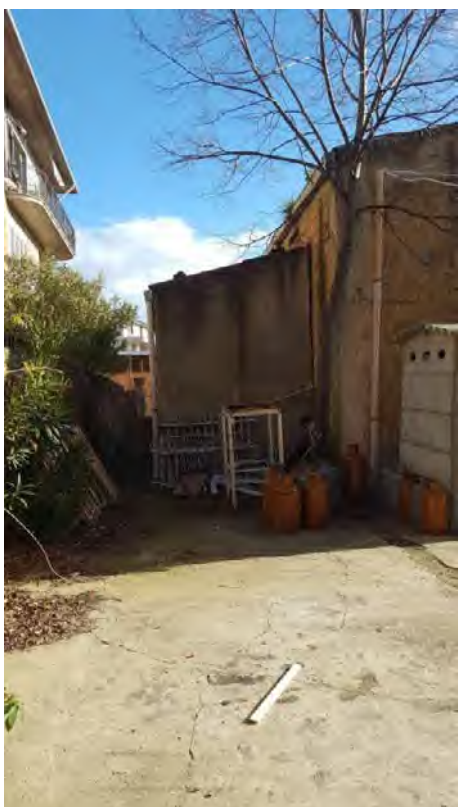
Foto N. 13: Locale Idrico da demolire Lotto L4
