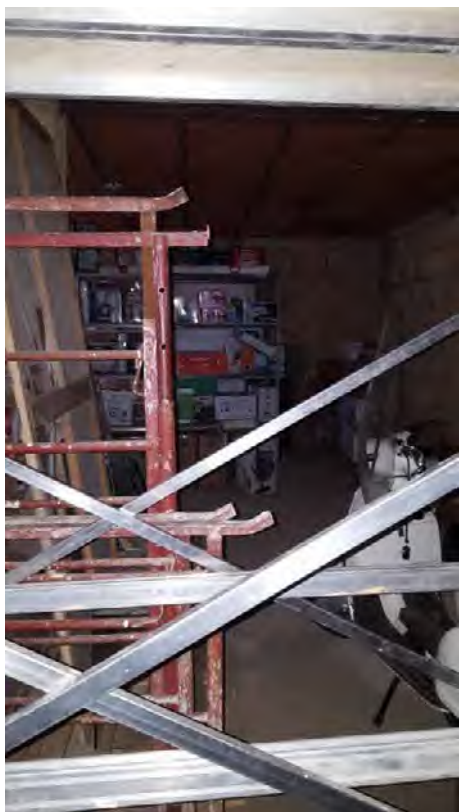
Foto N. 32: Interno del magazzino e controsoffitto Lotto L4
