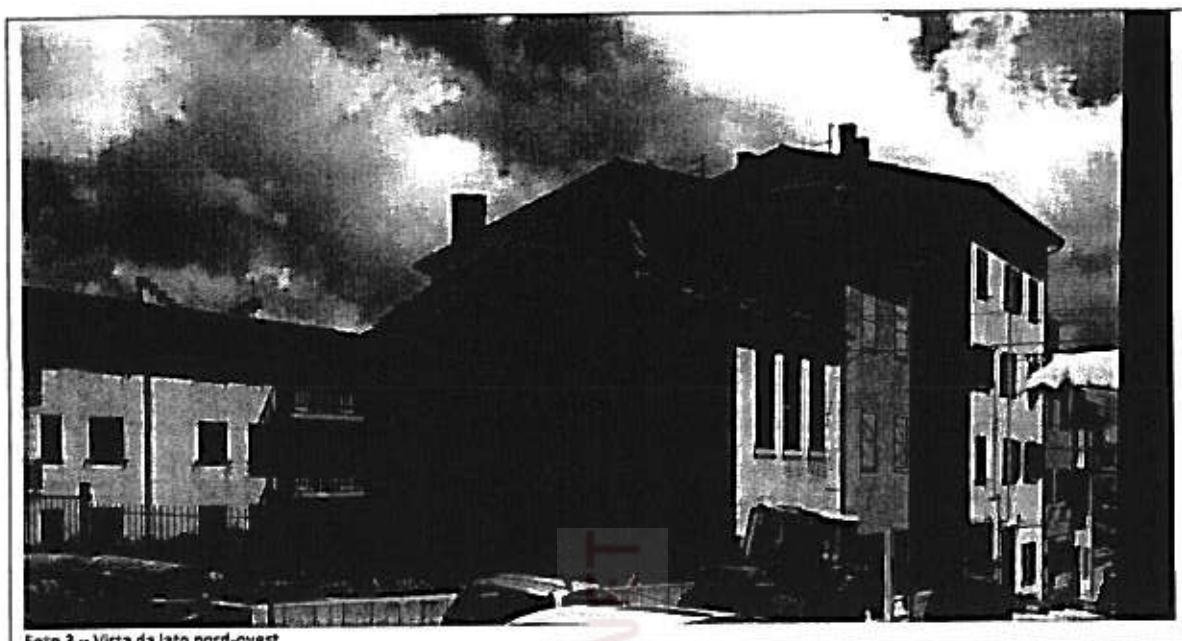
Foto 3 – Vista da lato nord-ovest
