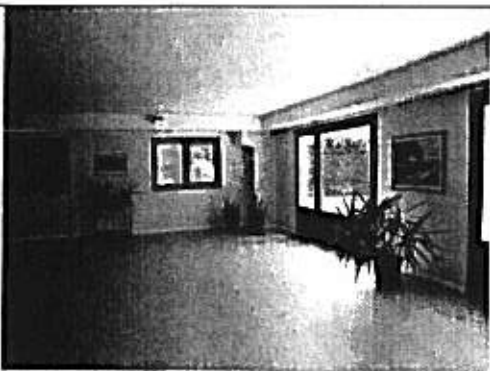
Foto 9 - Vano (interno officina)
