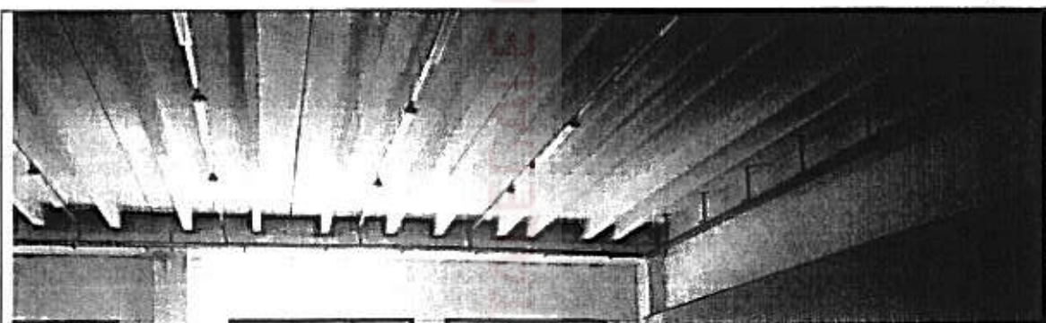
Foto 4 – Vano (opificio industriale)
