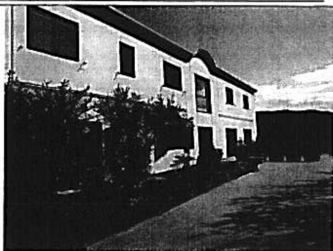
Foto 8 - facciata esterna lato sud uffici e officina
