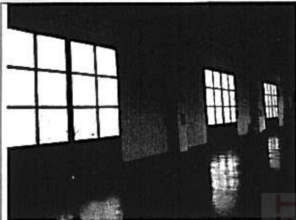
Foto 3 – Vano (opificio industriale)
