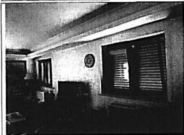
Foto 3 - Vano interno (soggiorno)
