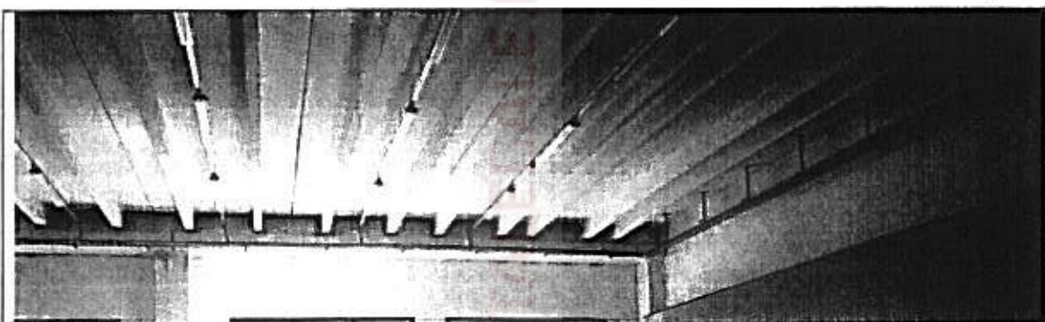
Foto 4 - Vano (ufficio Industriale)
