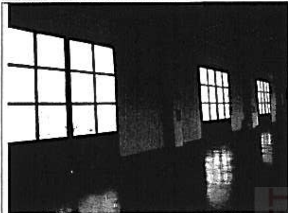
Foto 3 - Vano (ufficio Industriale)
