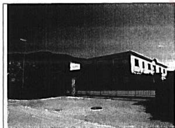
Foto 1 – Vista da nord-ovest
