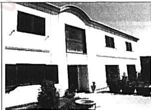
Foto 2 - Vista da sud-ovest
