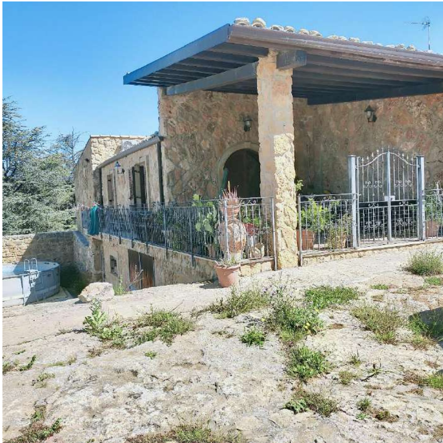
FOTO N.15: EDIFICIO 7 PROSPETTO LATERALE (ABITAZIONE)
