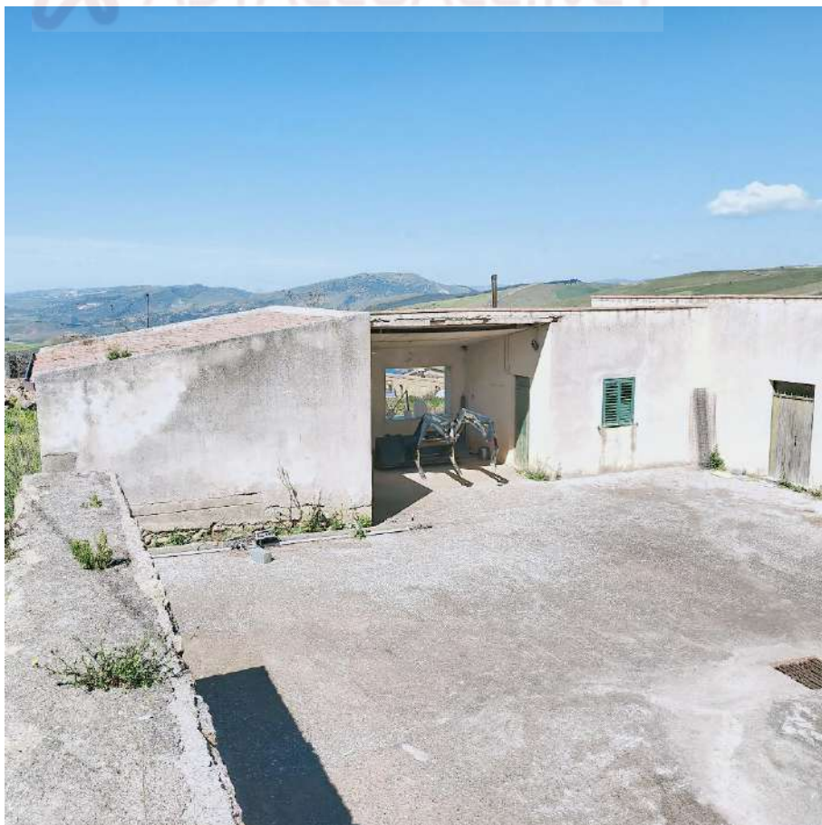
FOTO N.16: EDIFICIO 7 PROSPETTO LATERALE (MAGAZZINI SUB 1)
