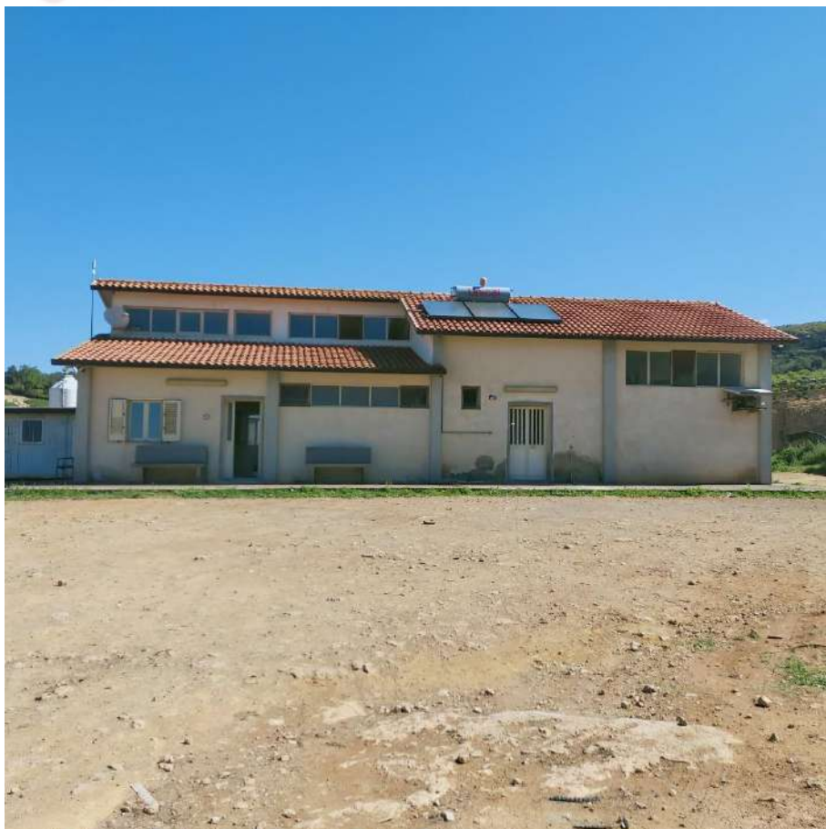
FOTO N.20: EDIFICIO 10 VISTA FRONTALE (CASEIFICIO)
