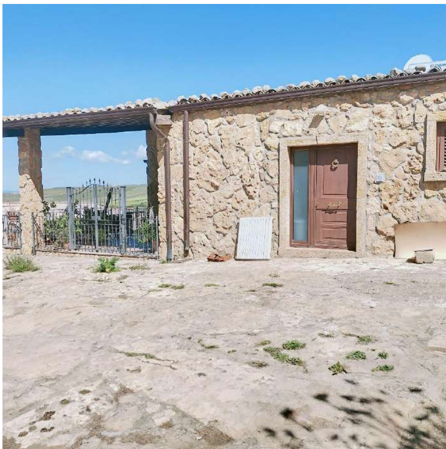
FOTO N.14: EDIFICIO 7 PROSPETTO FRONTALE (ABITAZIONE)
