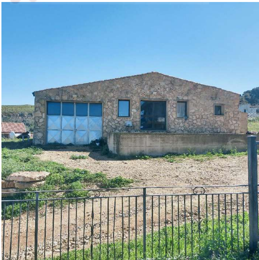
FOTO N.11: EDIFICIO 6 VISTA FRONTALE (EDIFICIO RISTORAZIONE)
