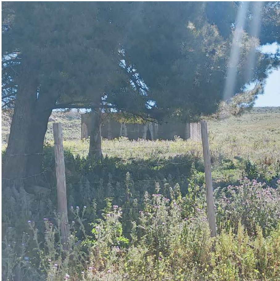
FOTO N.19: EDIFICIO 8 VISTA FRONTALE (VASCA ACQUA)
