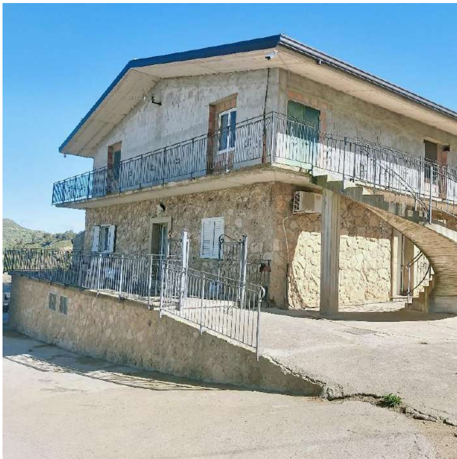
FOTO N.6: EDIFICIO 4 VISTA LATERALE (ABITAZIONE SUB.2)
