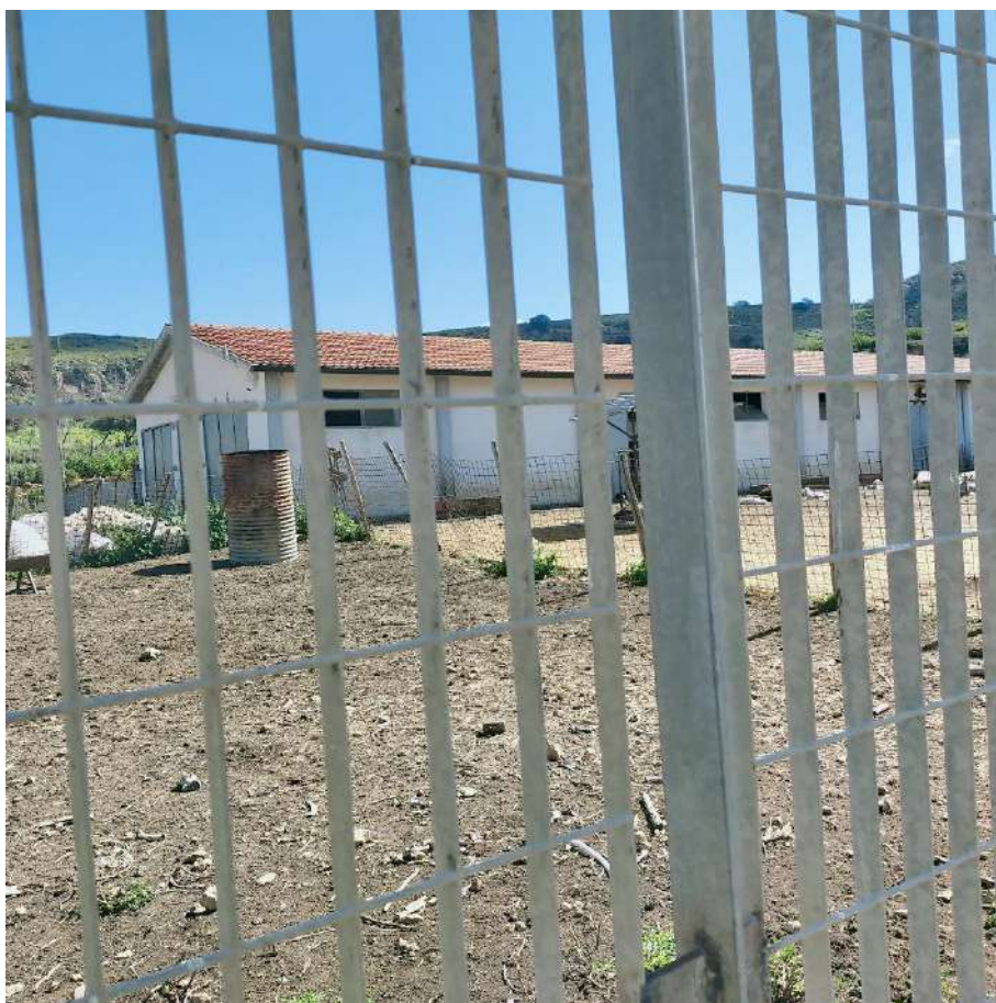
FOTO N.26: EDIFICIO 12 VISTA LATERALE (STALLONE)
