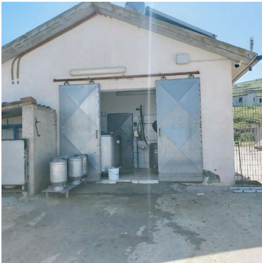
FOTO N.25: EDIFICIO 11 VISTA FRONTALE (SALA MUNGITURA)
