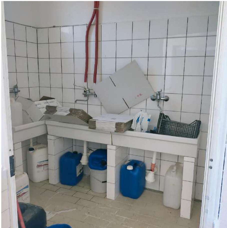
FOTO N.23: EDIFICIO 10 INTERNO (CASEIFICIO)
