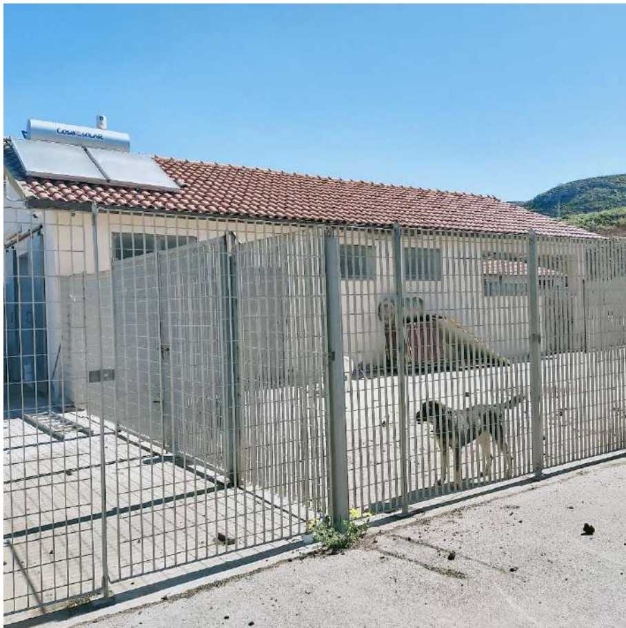
FOTO N.24: EDIFICIO 11 VISTA LATERALE (SALA MUNGITURA)
