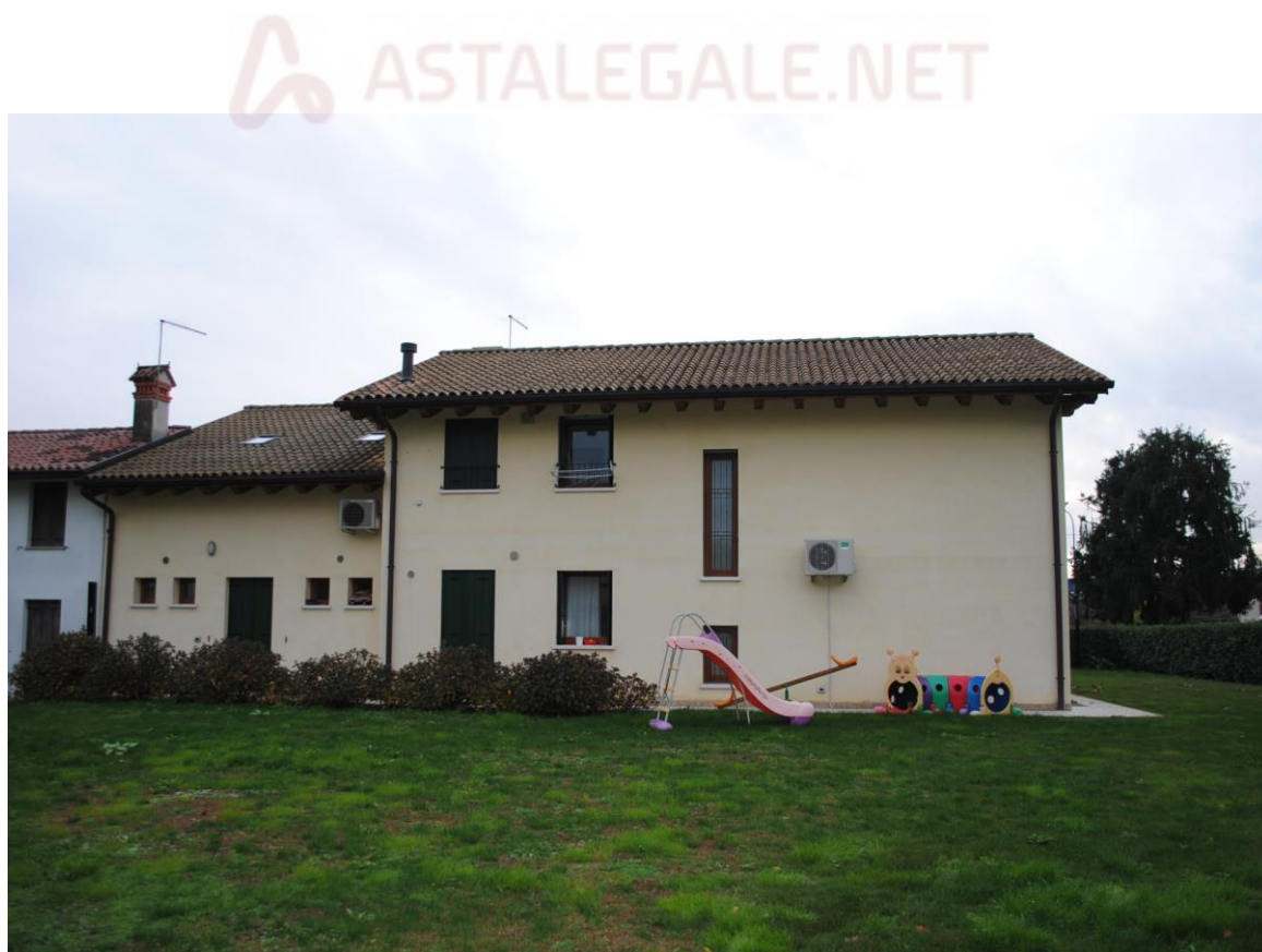
Foto n. 6 – vista da nord
