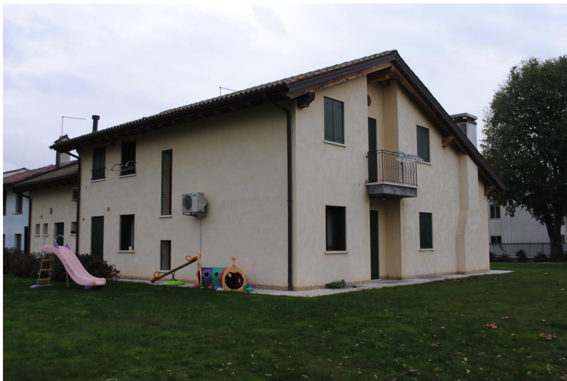
Foto n. 5 – vista da nord-ovest
