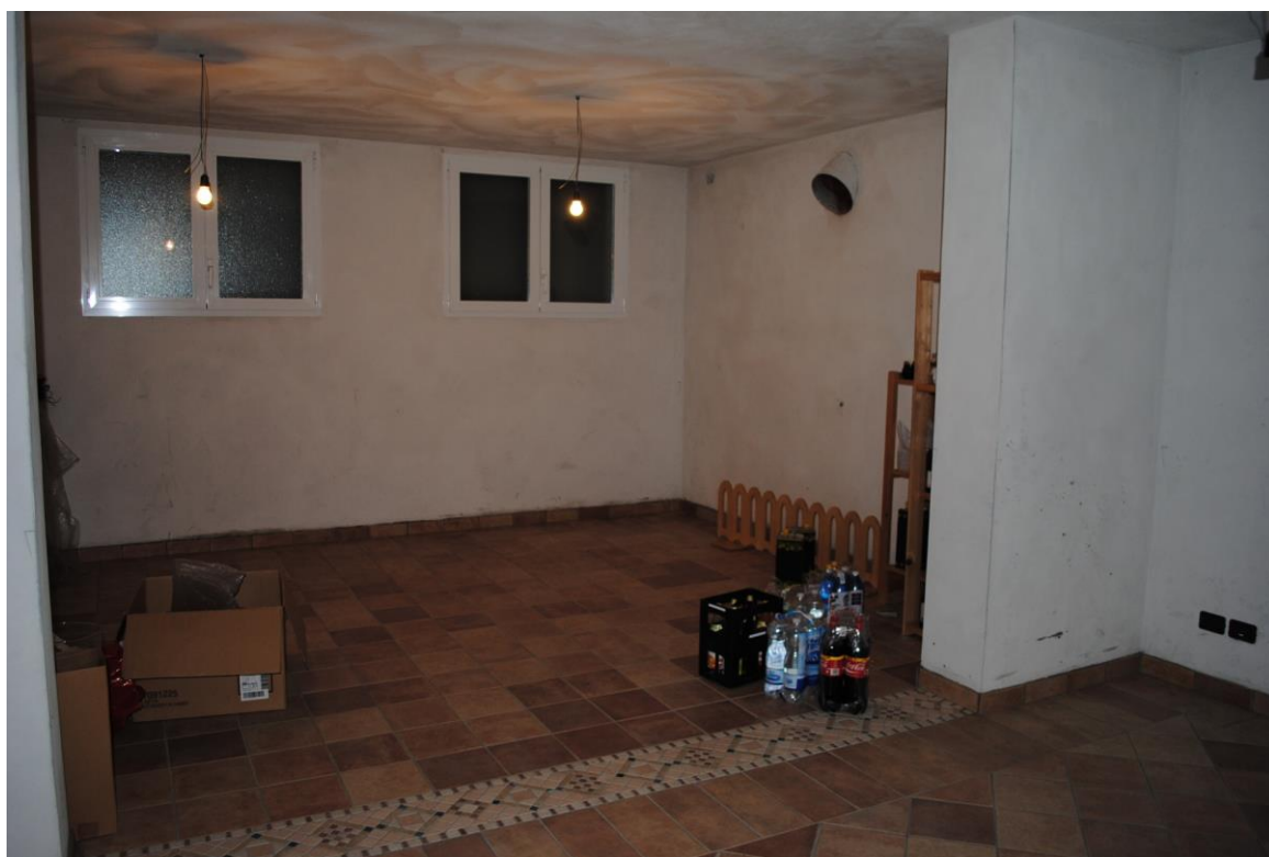
Foto n. 19 – vista interna piano interrato
