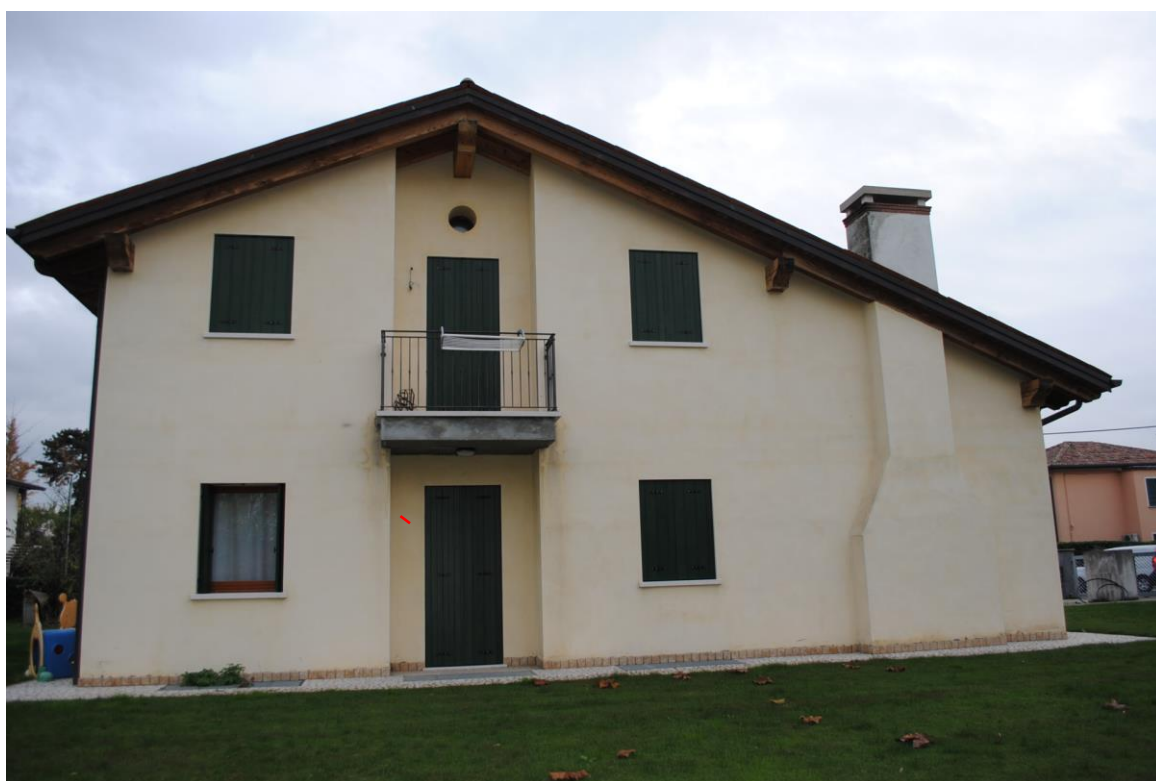
Foto n. 4 – vista da ovest
