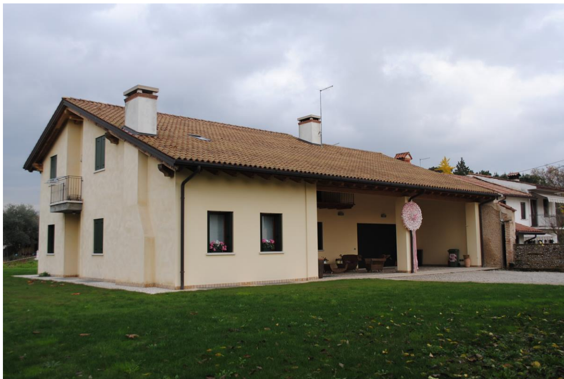
Foto n. 3 – vista da sud-ovest
