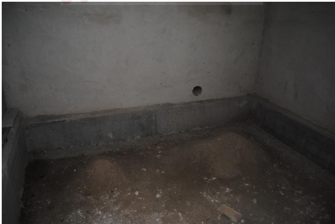
Foto n. 24 – vista interna piano interrato - cantina
