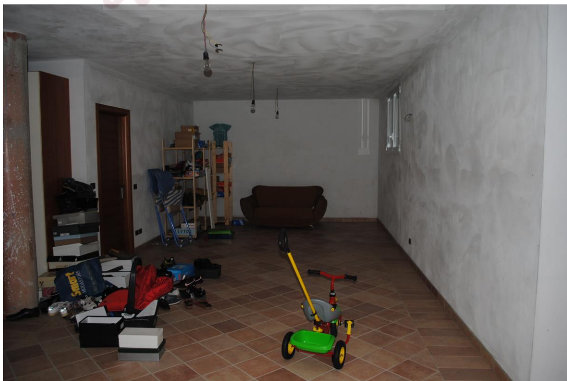
Foto n. 20 – vista interna piano interrato
