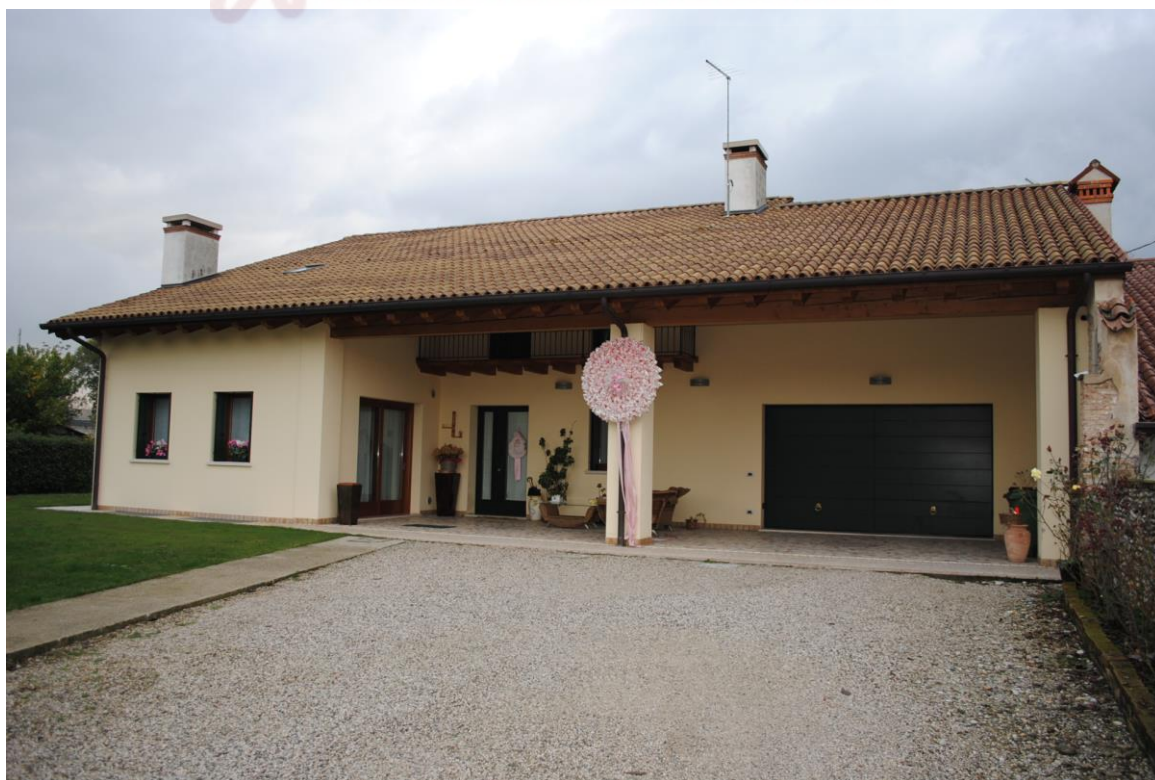
Foto n. 2 - vista da sud
