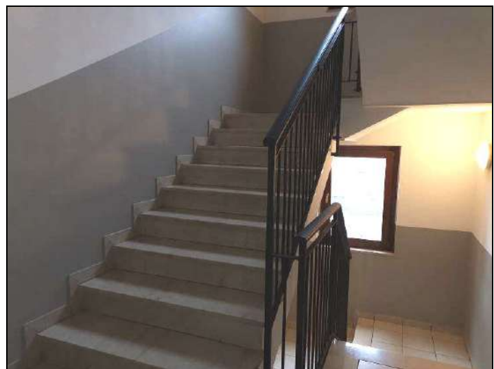
8 - rampa scala comune
