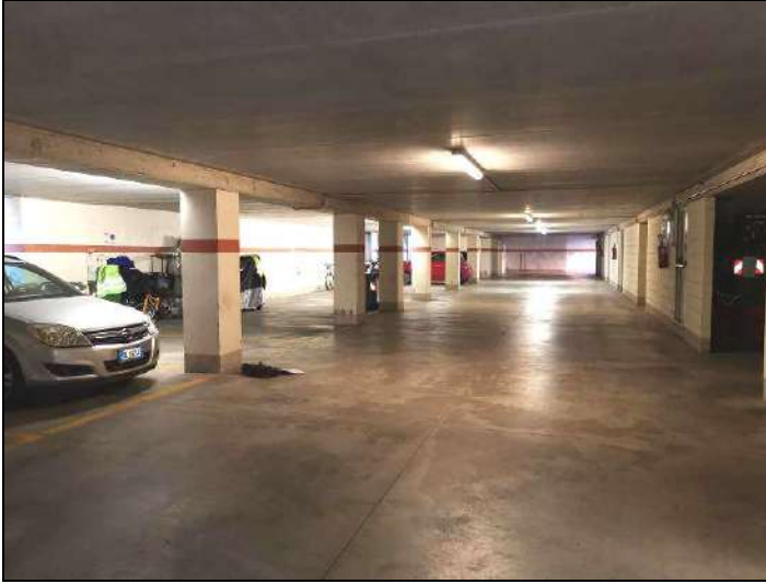
27 - corsello comune di manovra
