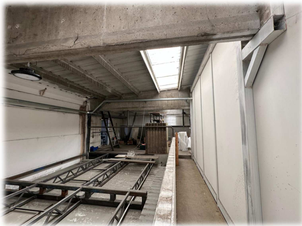
BENE 1 – INTERNO PORZIONE DI FABBRICATO INDUSTRIALE – P.T.
