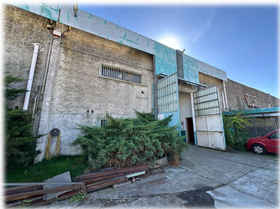
BENE 1 - PORZIONE DI FABBRICATO PRODUTTIVO/ARTIGIANALE
