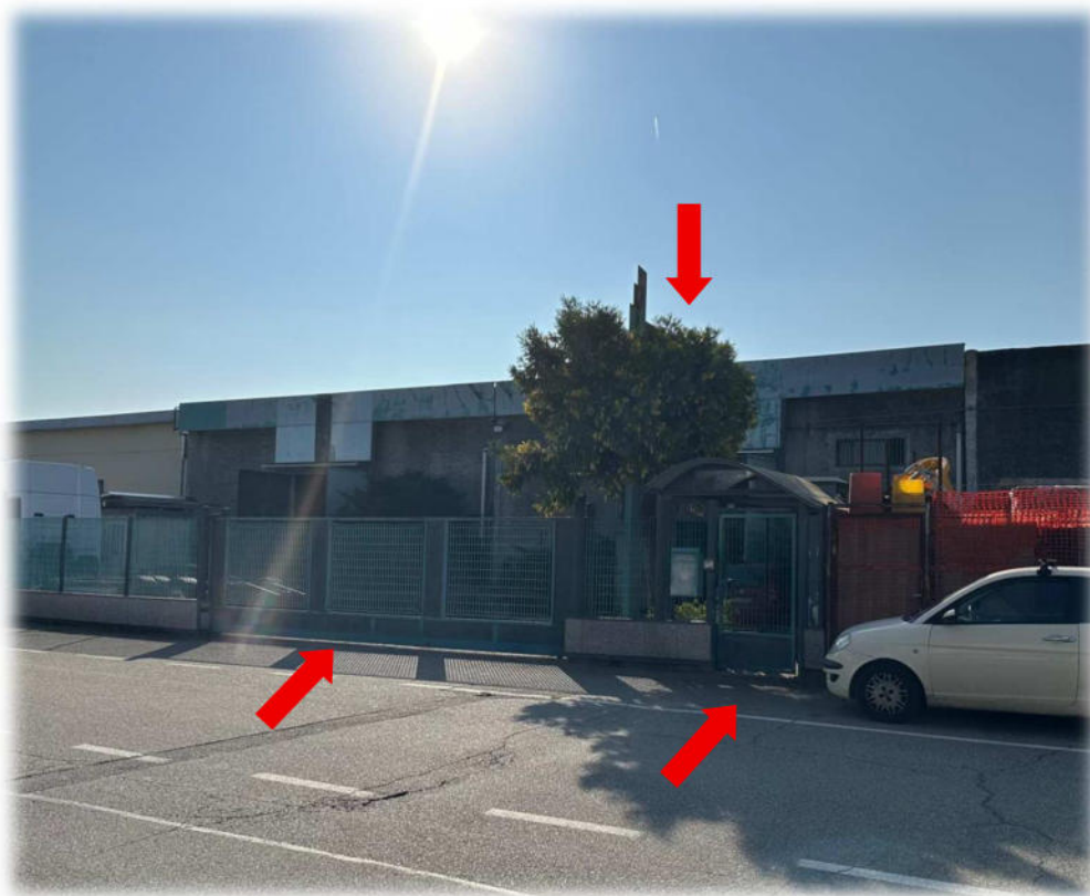
BENE 1 - PORZIONE DI FABBRICATO PRODUTTIVO/ARTIGIANALE
