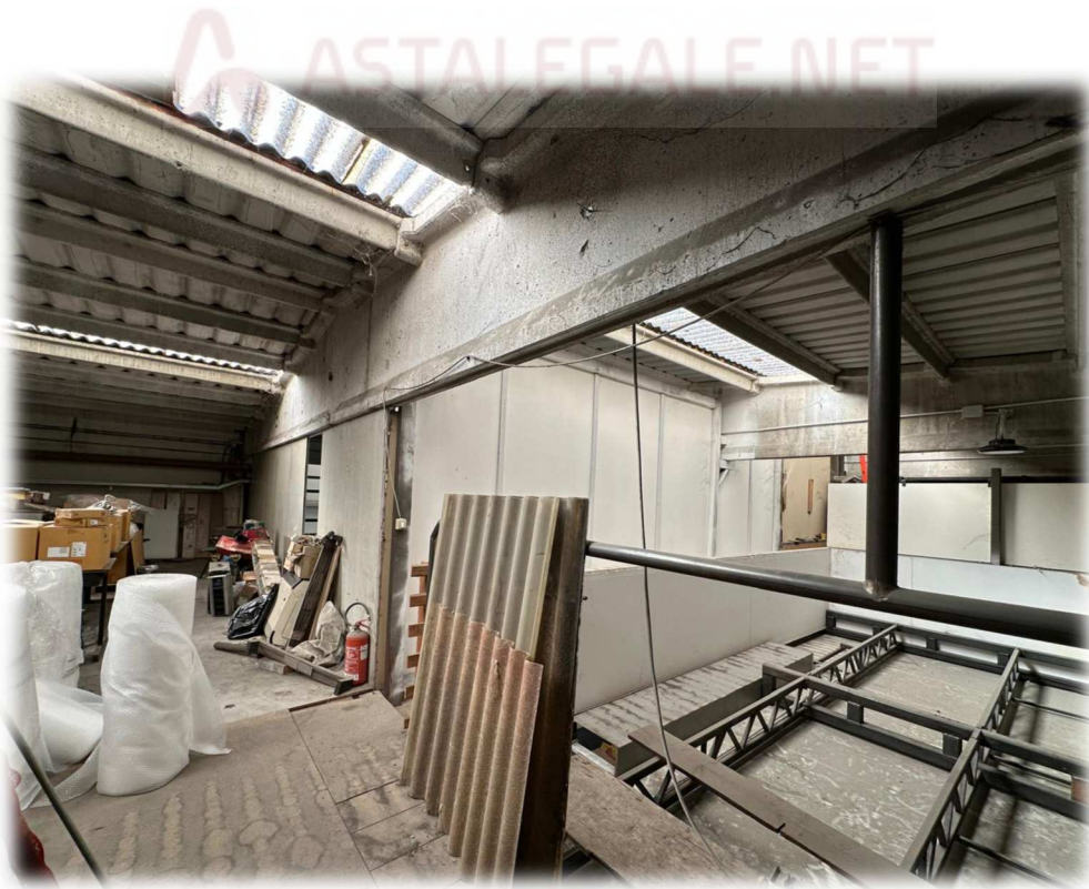
BENE 1 – INTERNO PORZIONE DI FABBRICATO PRODUTTIVO/ARTIGIANALE – P.1.
