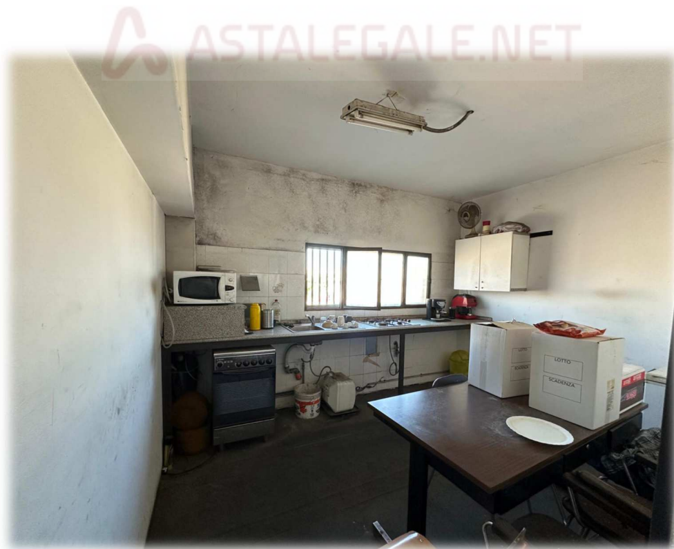
BENE 1 – INTERNO PORZIONE DI FABBRICATO INDUSTRIALE – P.1
