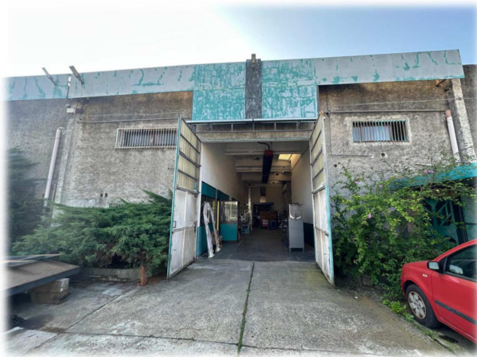
BENE 1 - PORZIONE DI FABBRICATO PRODUTTIVO/ARTIGIANALE
