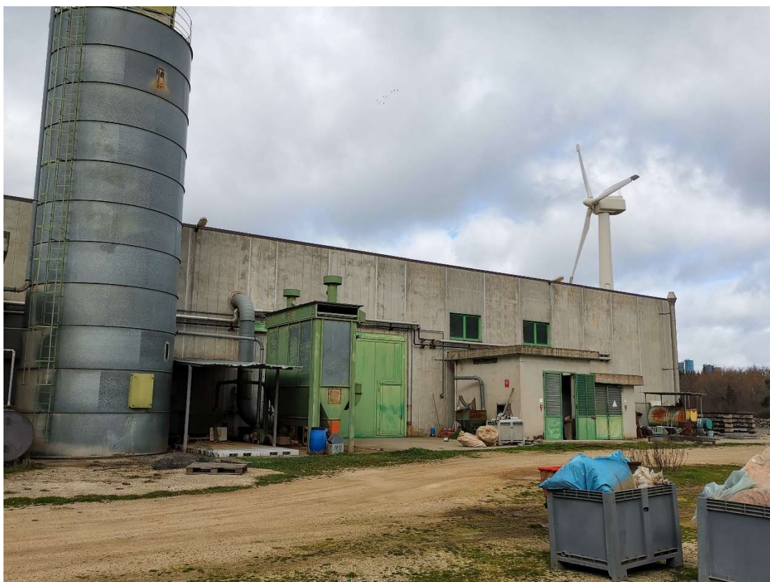
FOTO 004 – DETTAGLIO AREA CIRCOSTANTE AL CAPANNONE
