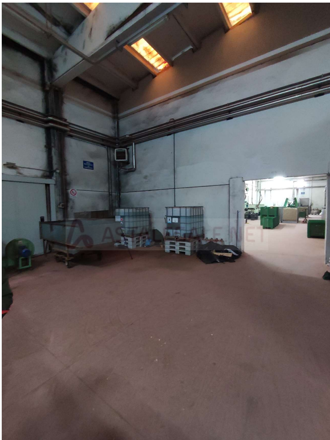
FOTO 024 – PIANO TERRA, LAVAGGIO TURACCIOLI
