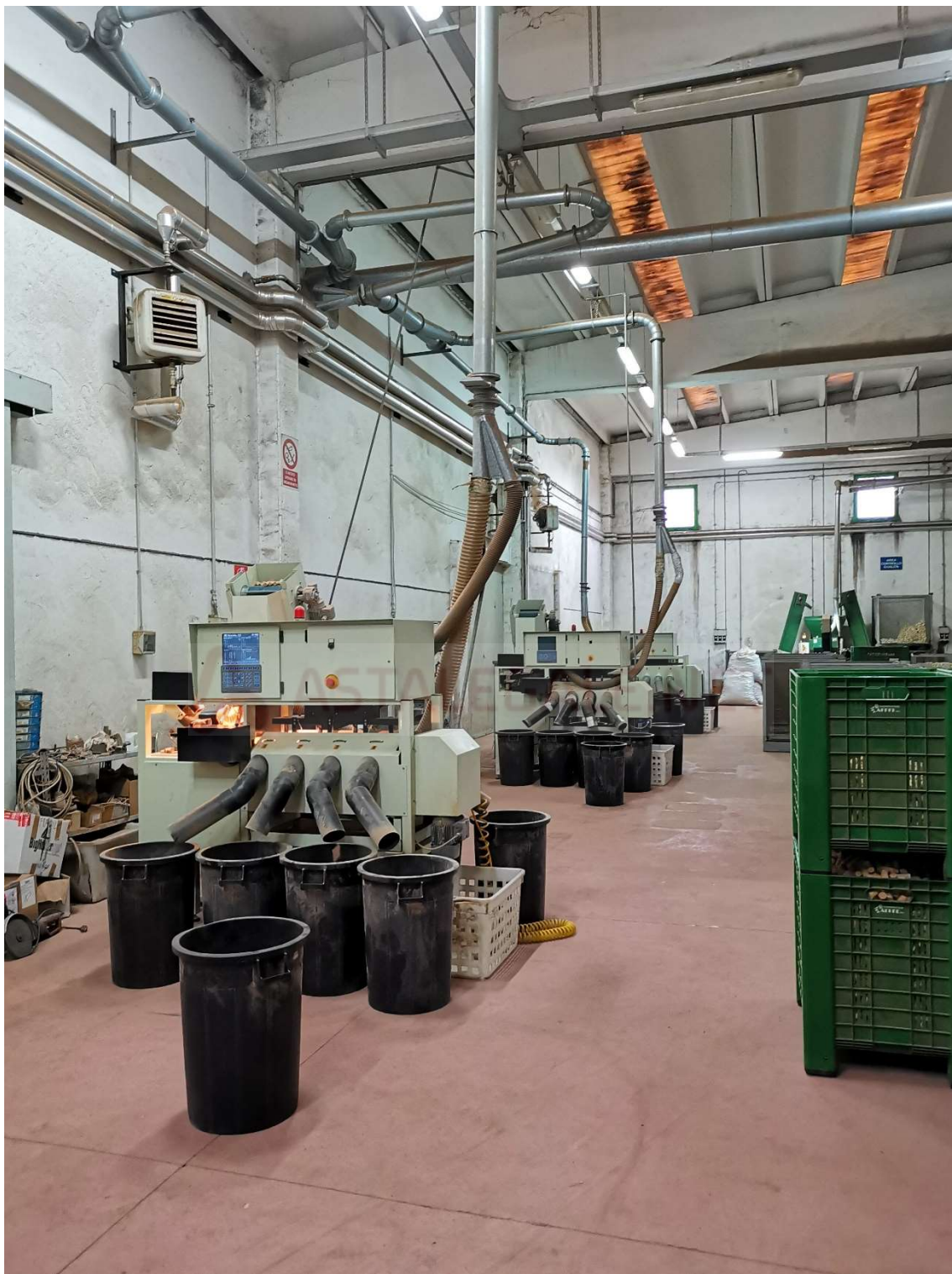
FOTO 019 – PIANO TERRA, SALA LAVORAZIONE 1
