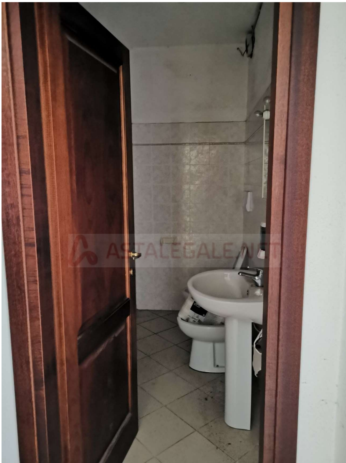
FOTO 011 – PIANO TERRA, BAGNO
