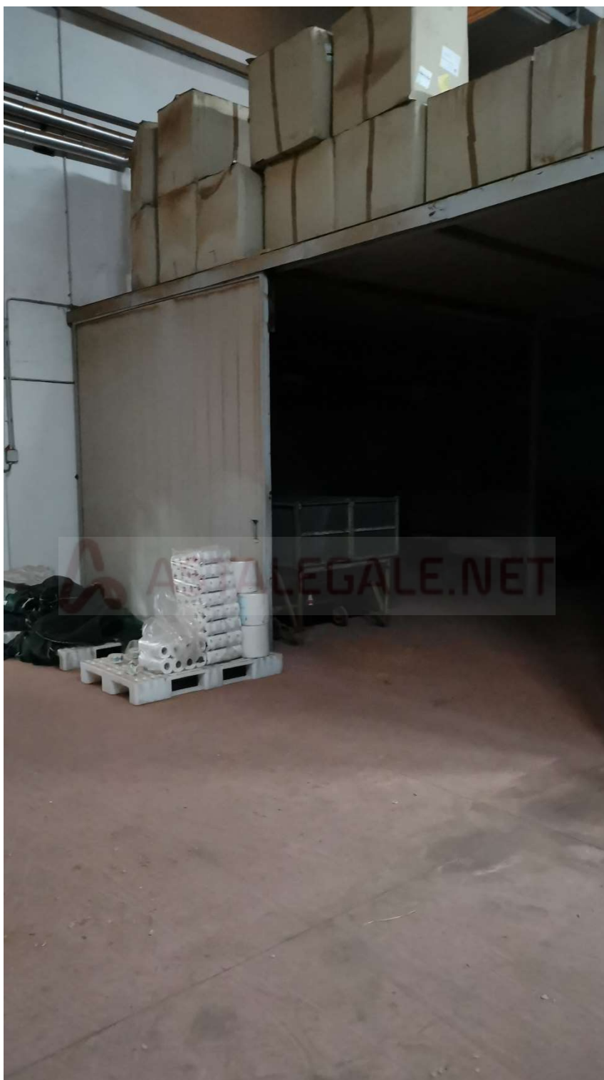
FOTO 027 – PIANO TERRA, ESSICCATOIO
