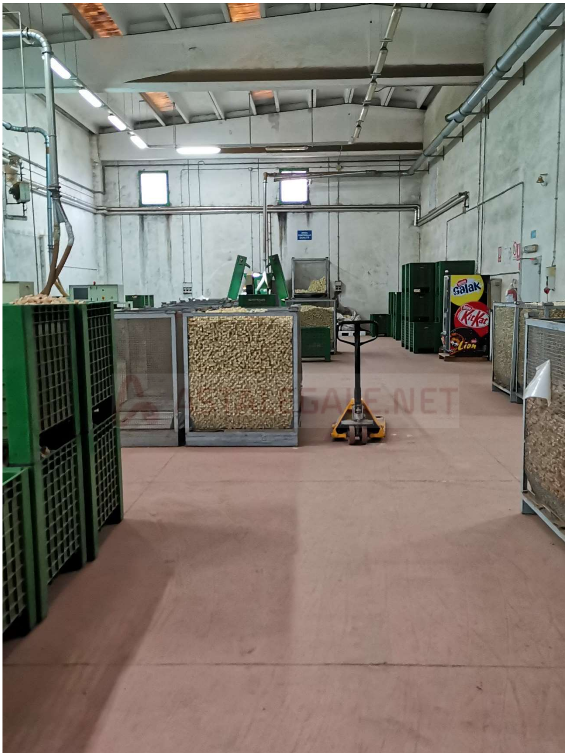
FOTO 020 – PIANO TERRA, SALA LAVORAZIONE 1
