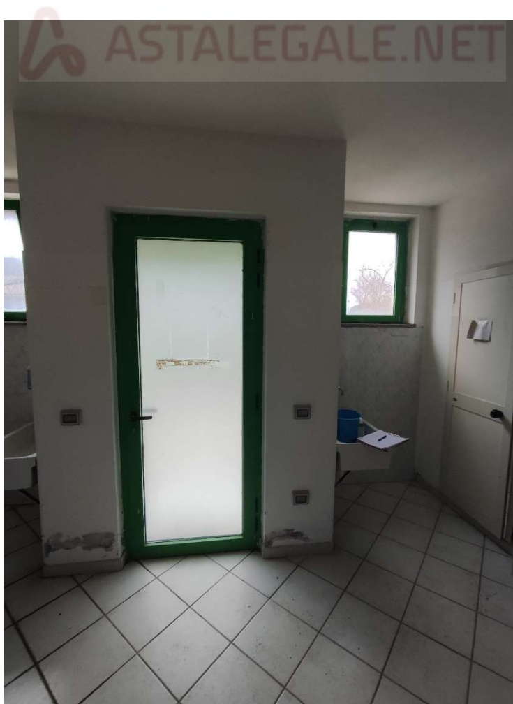
FOTO 017 – PIANO TERRA, SPOGLIATOIO UOMINI
