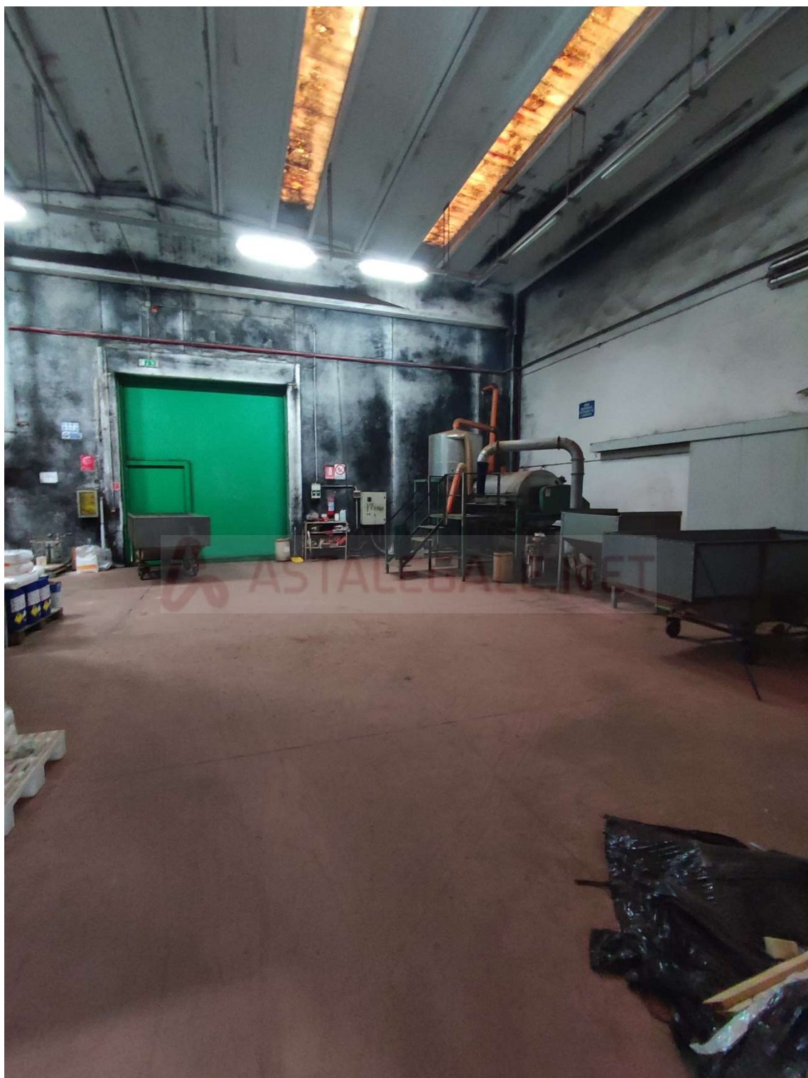
FOTO 023 – PIANO TERRA, LAVAGGIO TURACCIOLI
