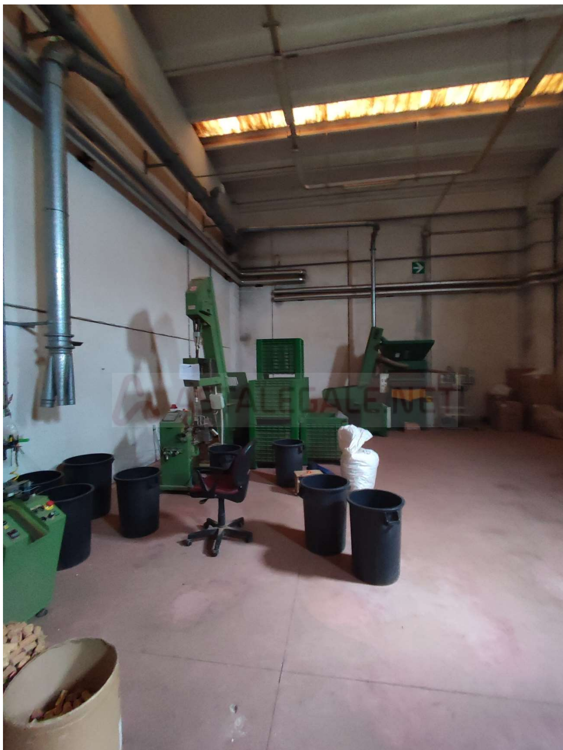
FOTO 032 – PIANO TERRA, SALA LAVORAZIONE 2
