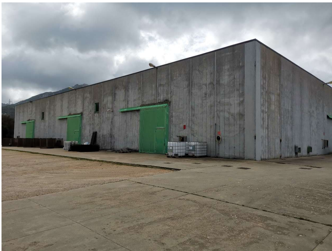
FOTO 003 – DETTAGLIO AREA CIRCOSTANTE AL CAPANNONE
