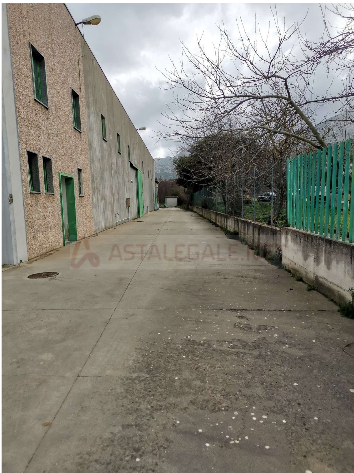
FOTO 007 – DETTAGLIO AREA CIRCOSTANTE AL CAPANNONE
