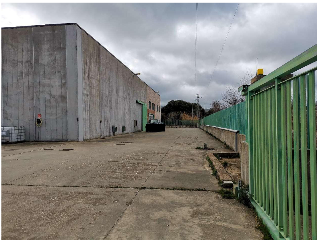
FOTO 002 – DETTAGLIO AREA CIRCOSTANTE AL CAPANNONE
