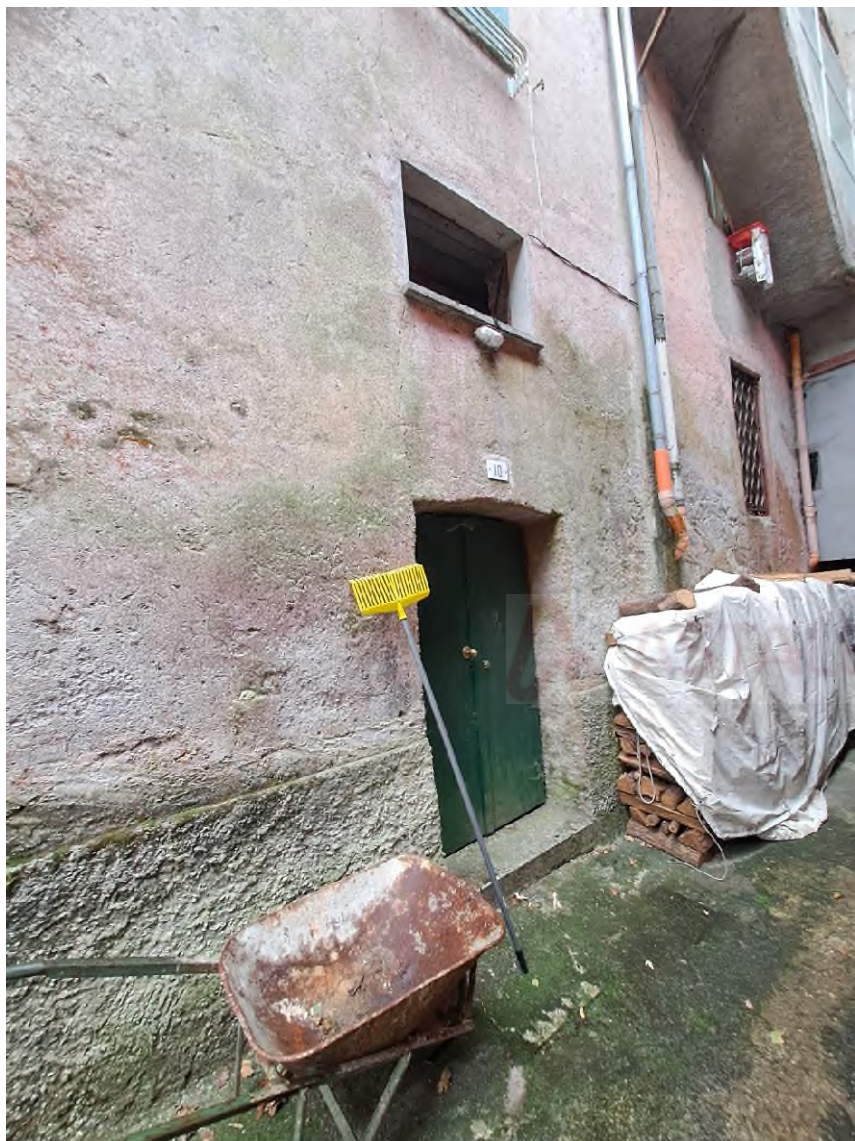
Ingress cantina da via Al Mulino
