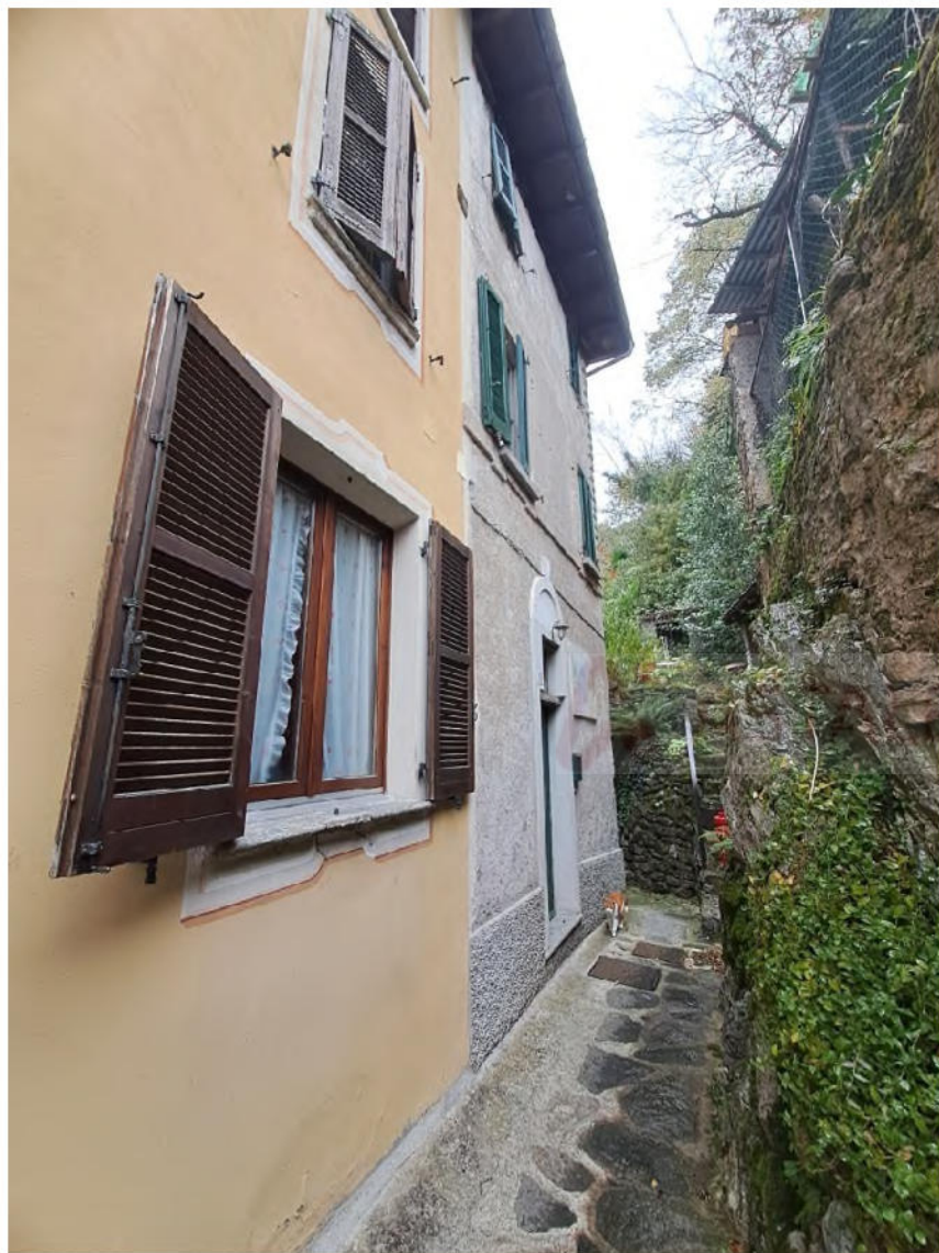
Vista da via Trebisonda
