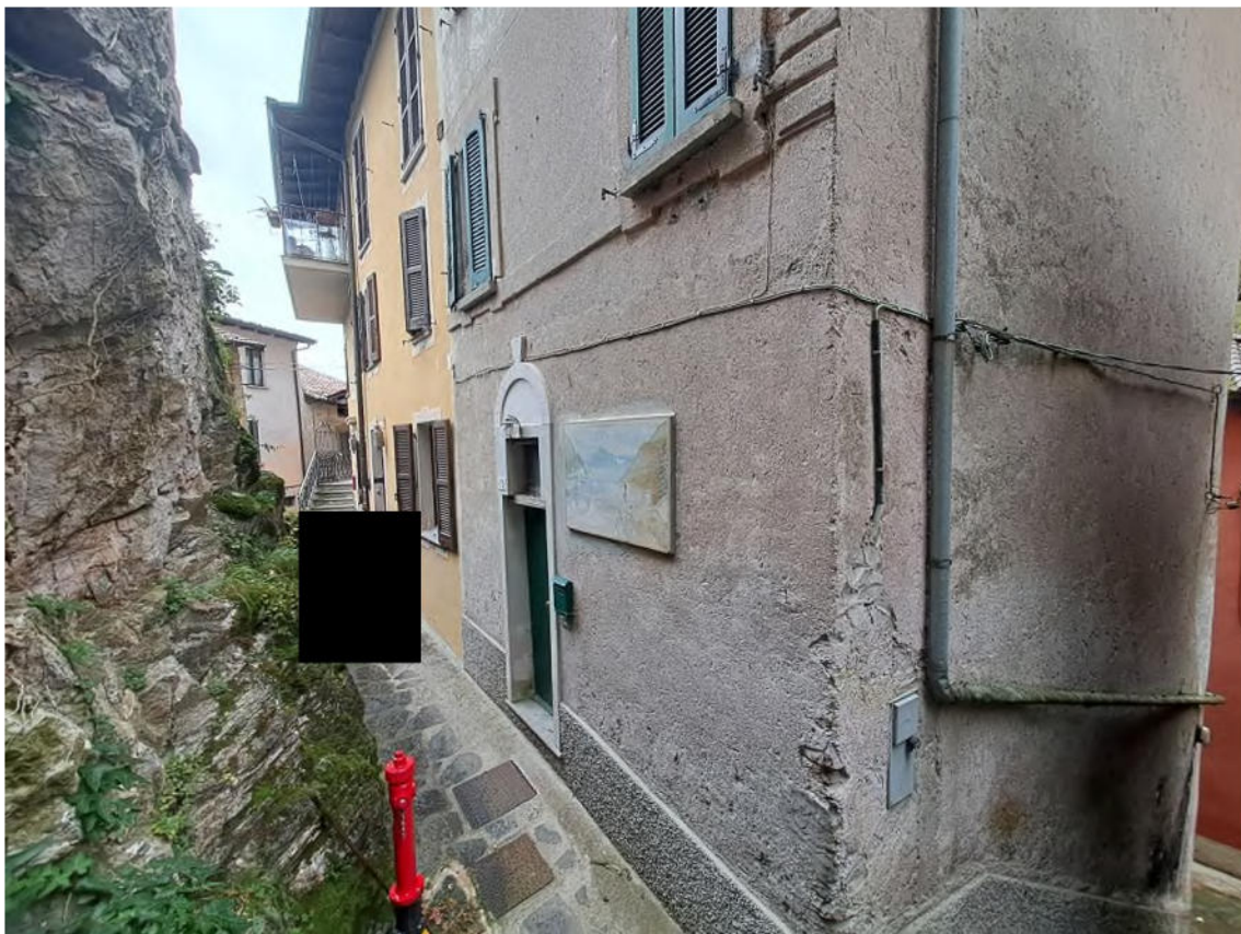
Vista da Via Trebisonda
