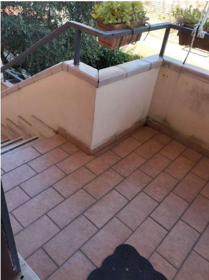
VISTA ESTERNA – INGRESSO PIANO PRIMO
