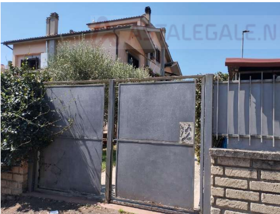
VISTA ESTERNA LATERALE
