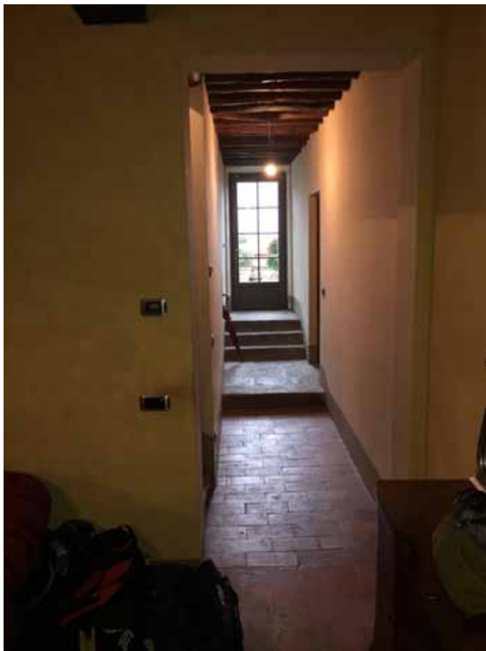
Foto 65 (zona abusiva da ripristinare)
