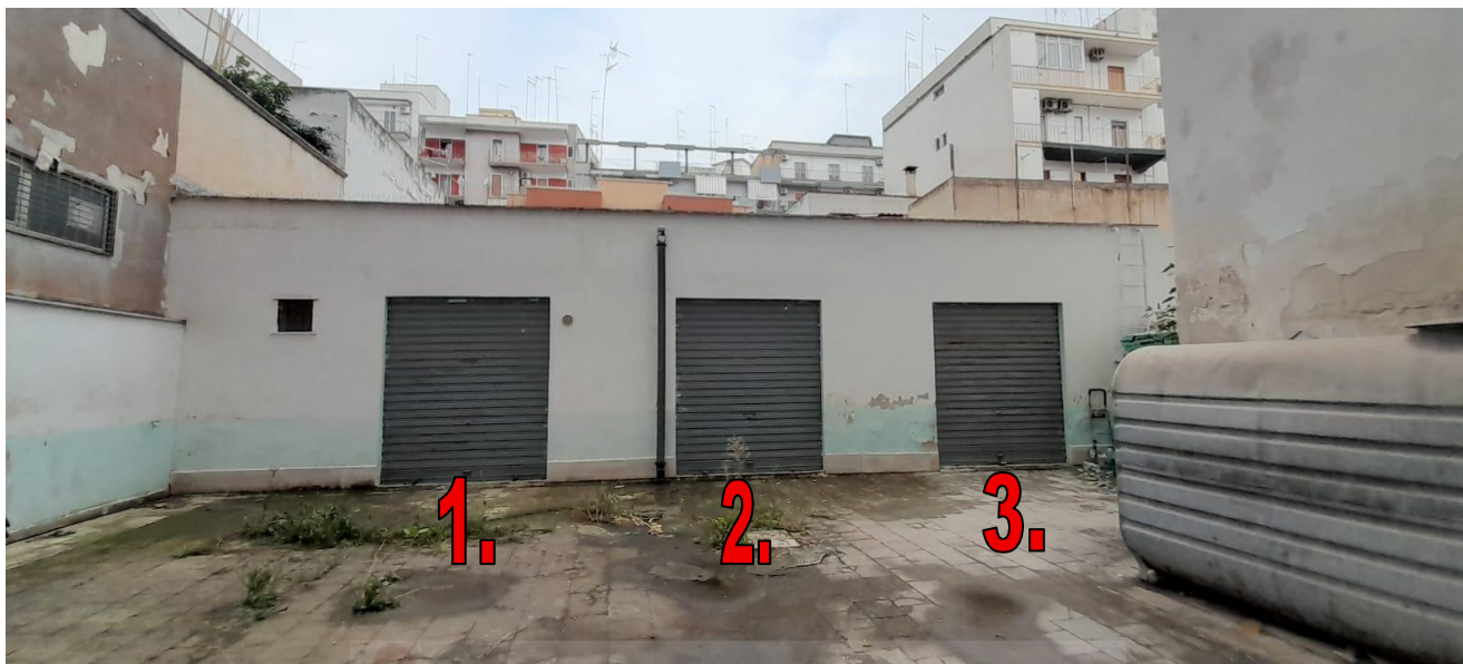
FOTO N. 3 Vista dalla corte verso le autorimesse
