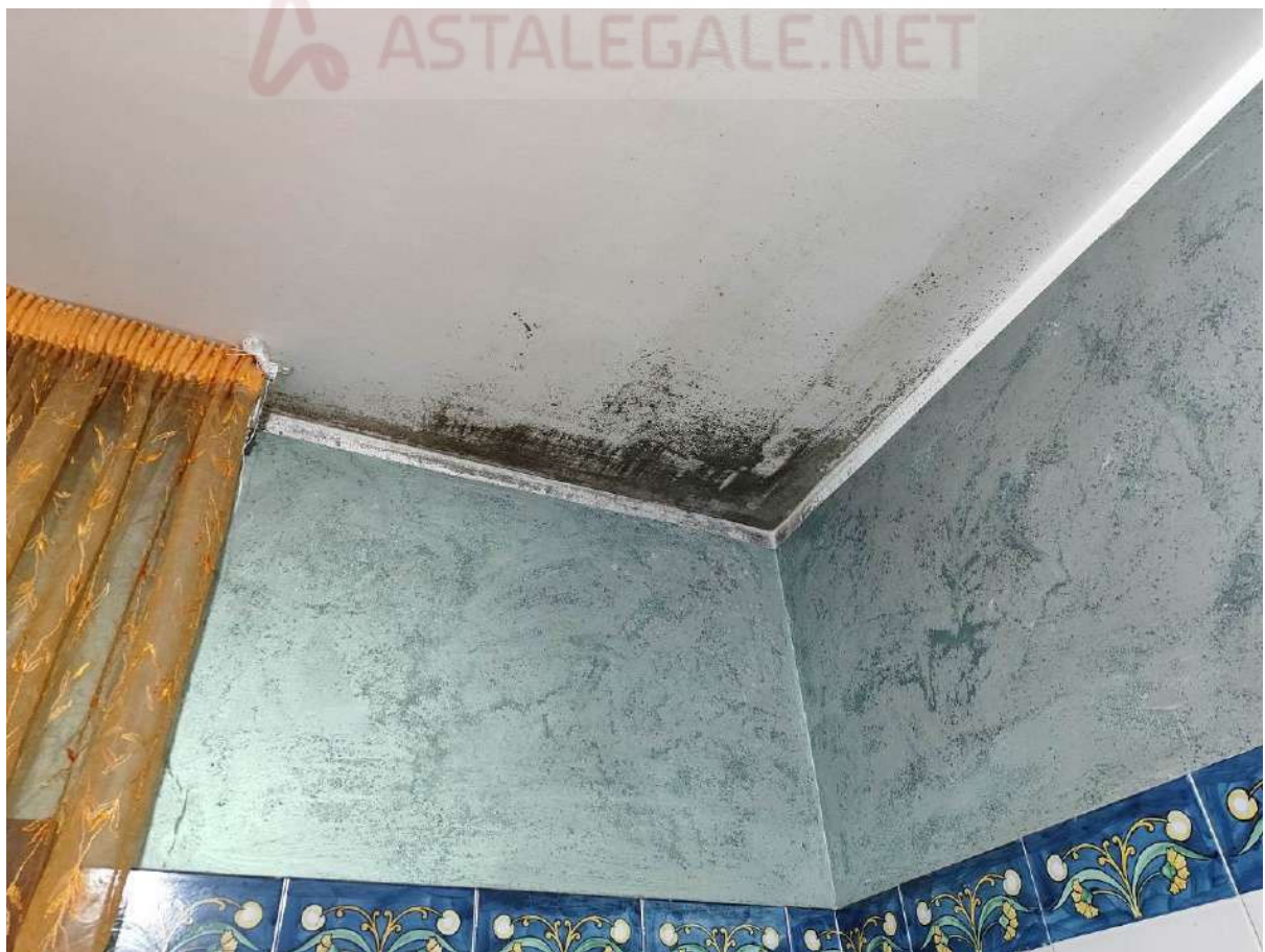
Foto 50 - Interni piano primo, wc
