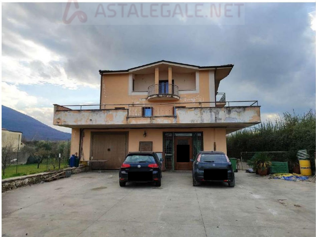
Foto 4 - Veduta facciata principale del fabbricato
