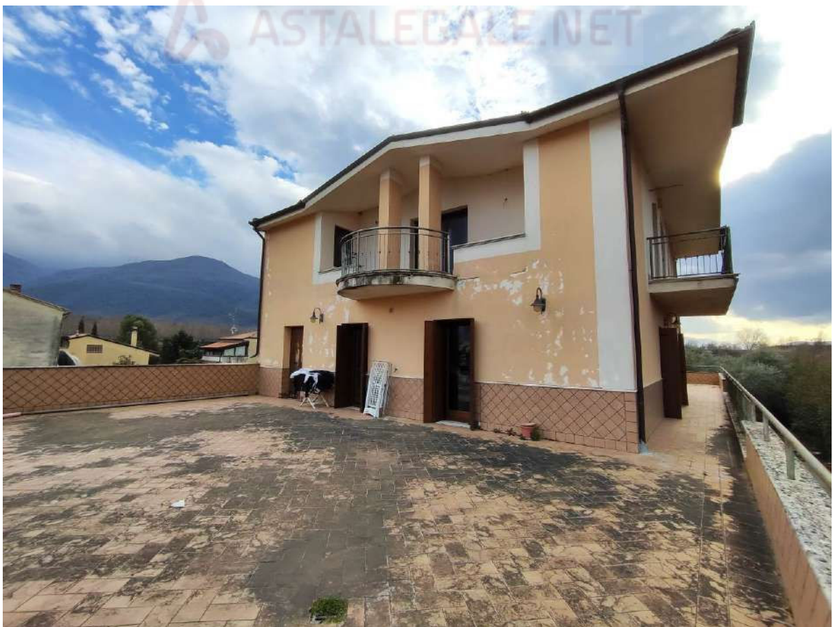
Foto 54 - Esterni piano primo
