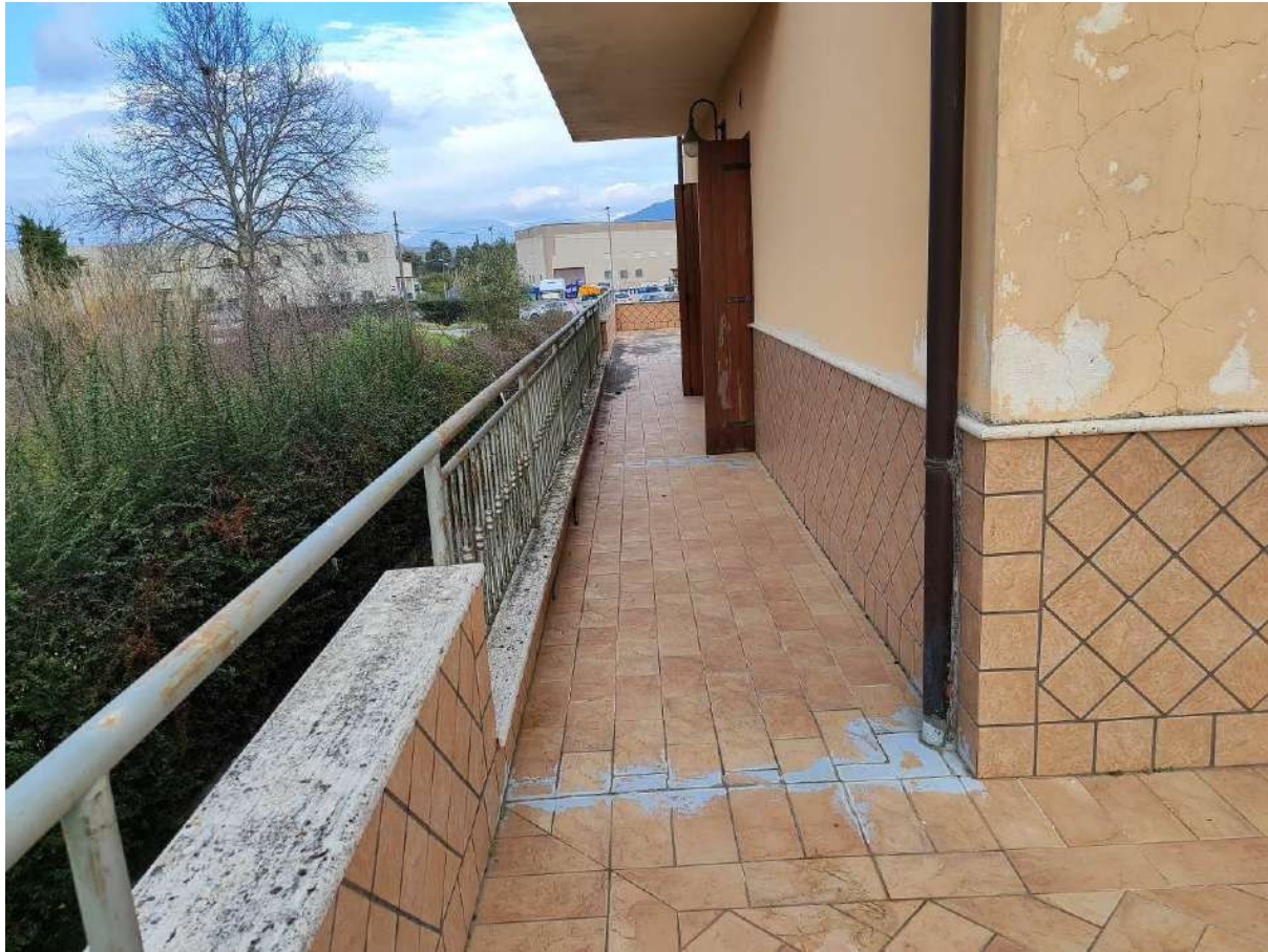
Foto 55 - Esterni piano primo
