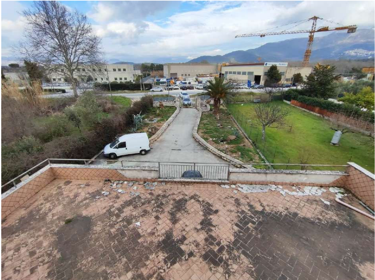
Foto 59 - Esterni piano primo
