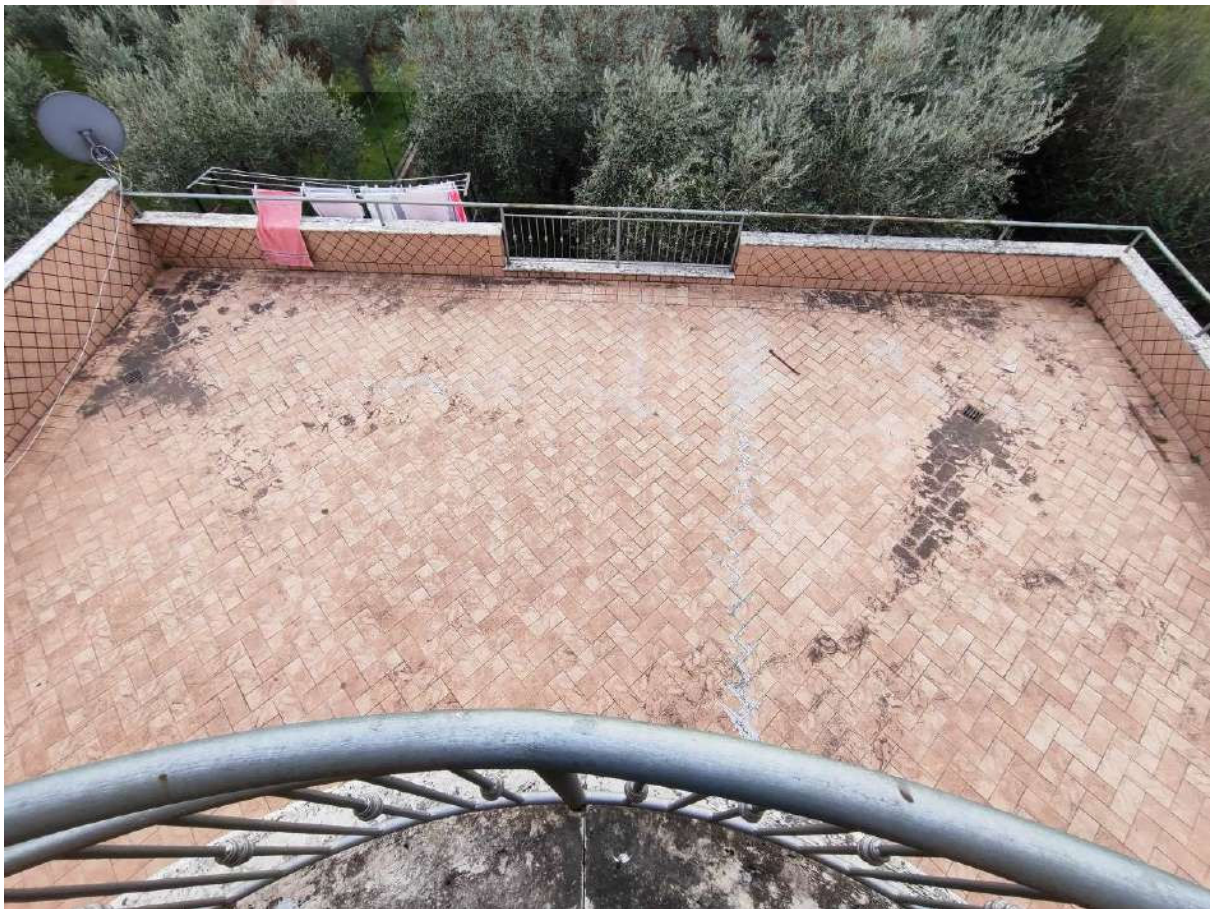
Foto 58 - Esterni piano primo
