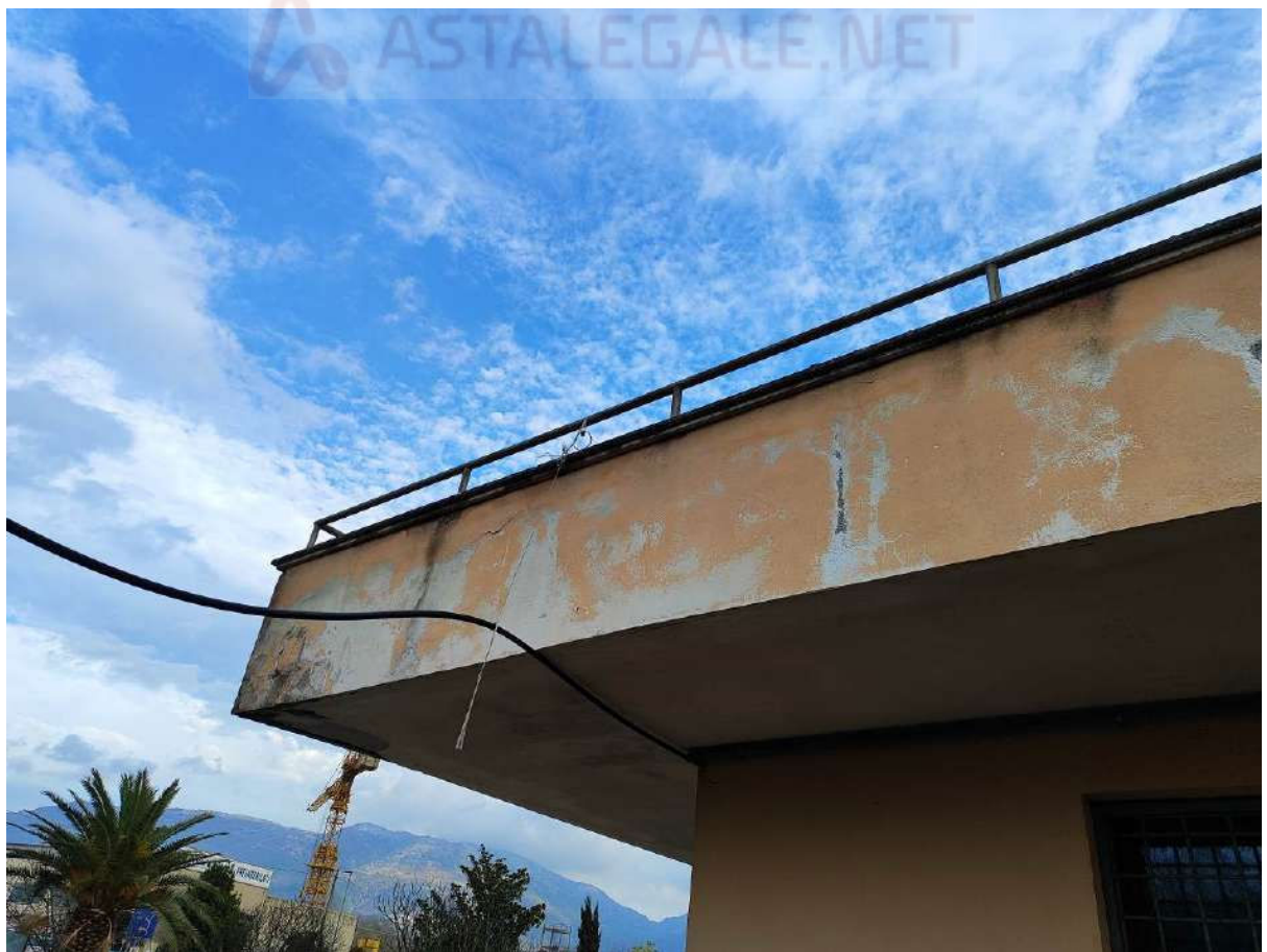
Foto 6 - Dettaglio prospetto laterale
