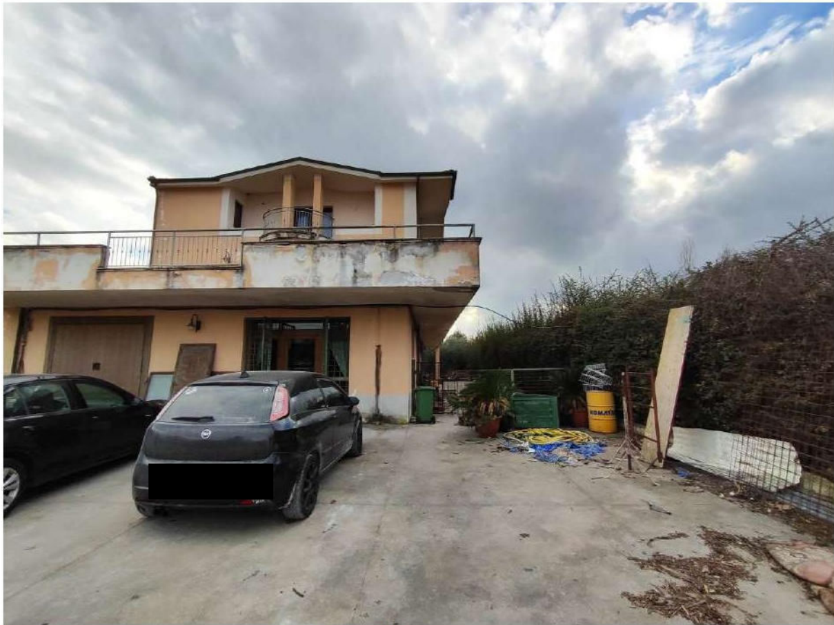
Foto 3 - Veduta fabbricato da area esterna
