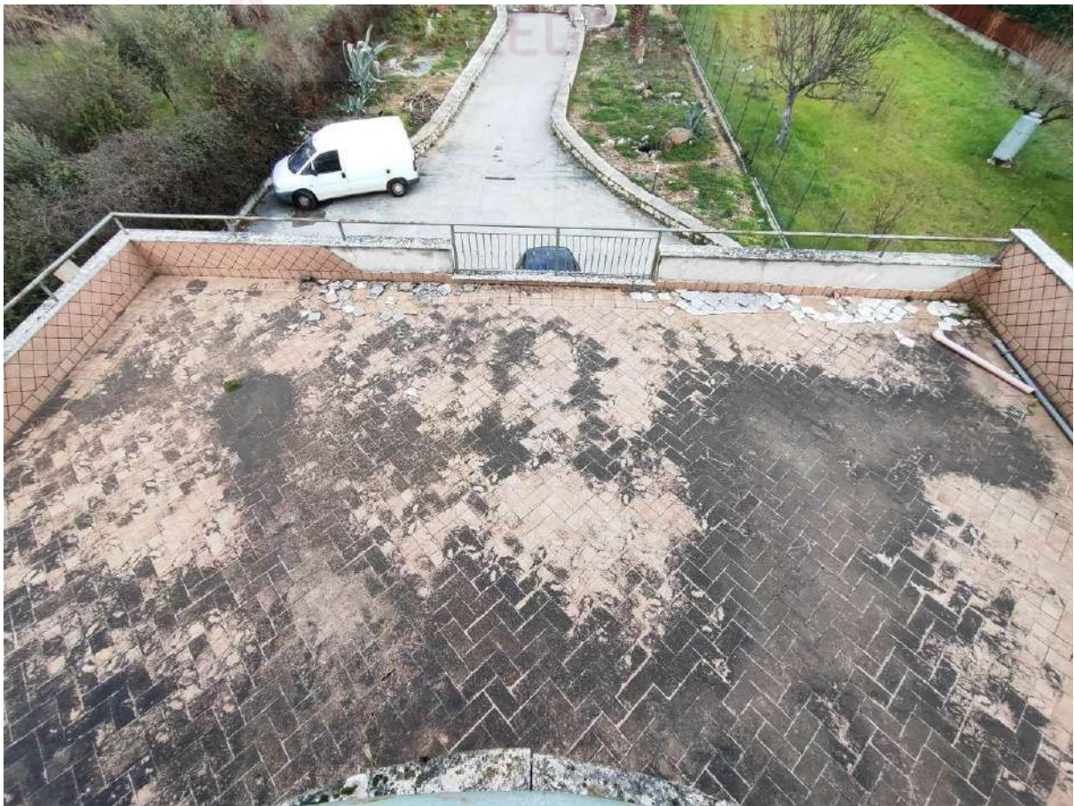
Foto 60 - Esterni piano primo
