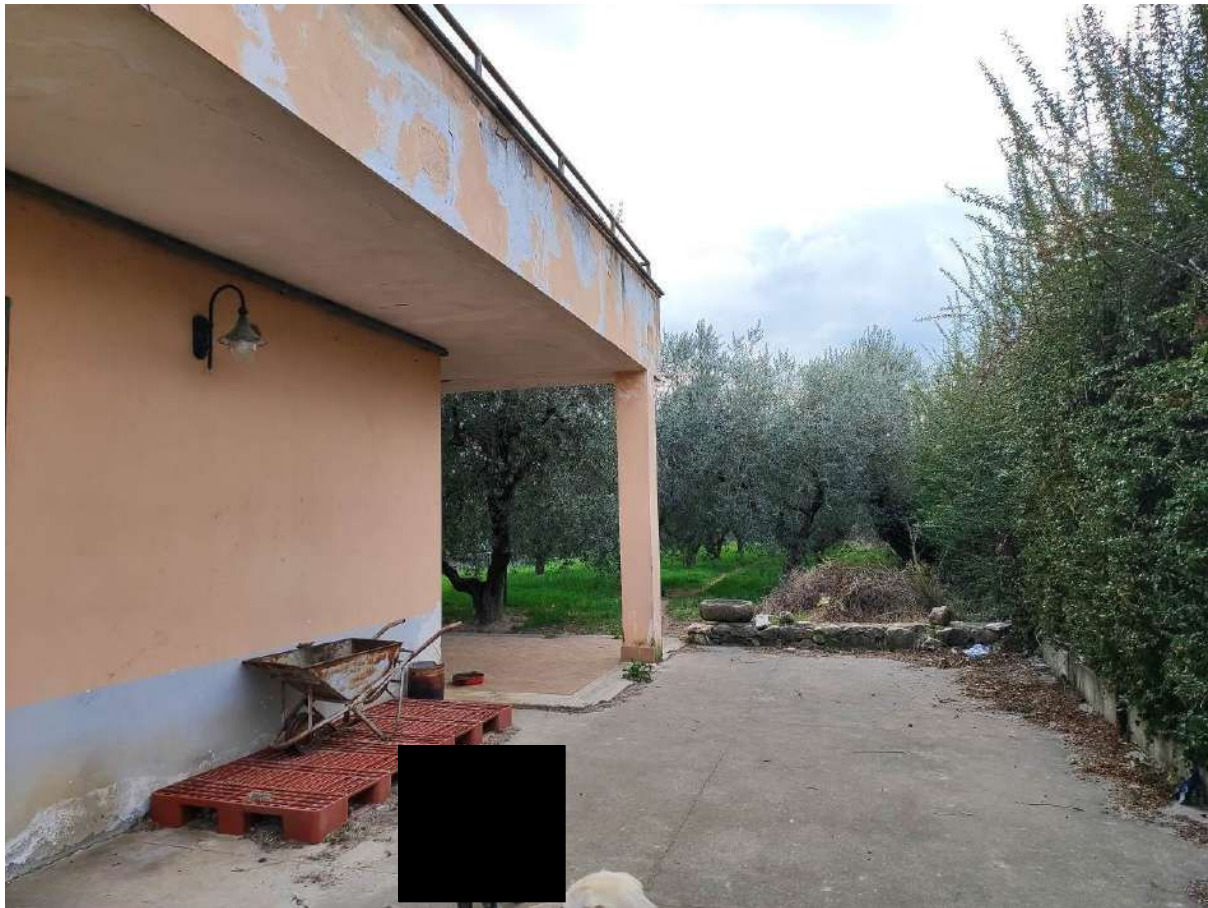
Foto 7 - Dettaglio prospetto laterale
