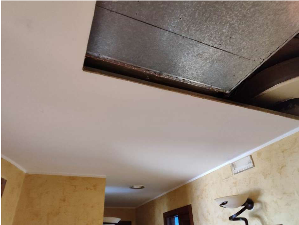
Foto 41 - Interni piano primo, disimpegno
