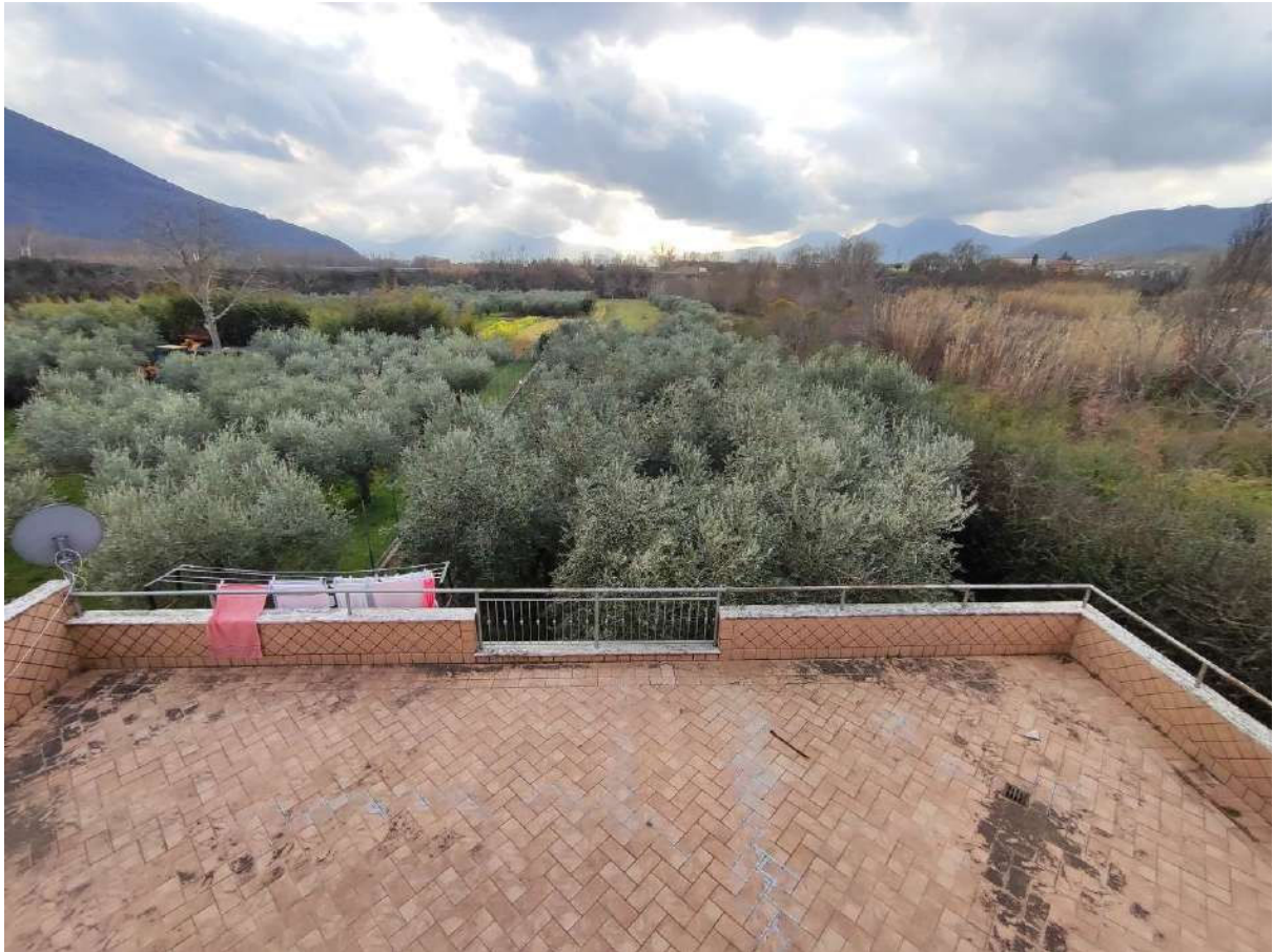
Foto 57 - Esterni piano primo
