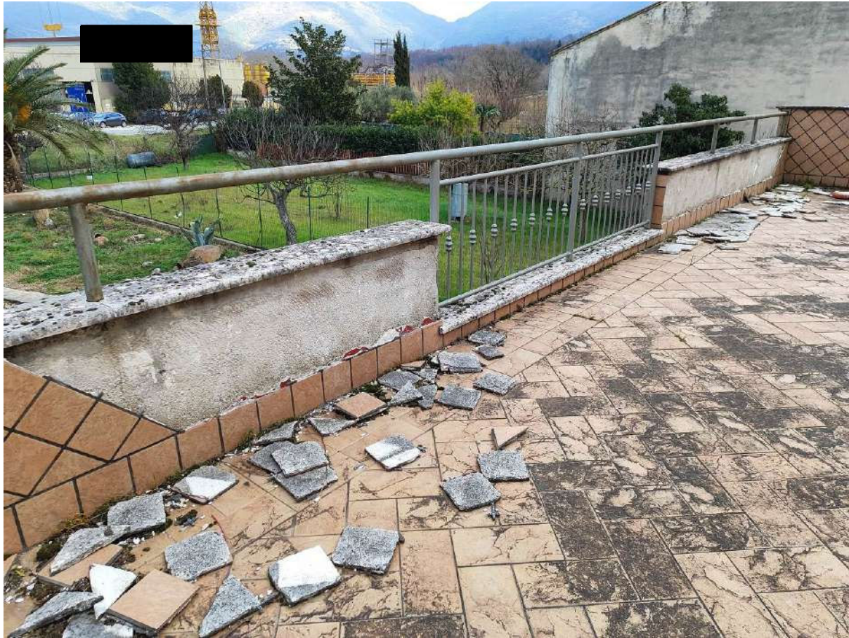
Foto 61 - Esterni piano primo
