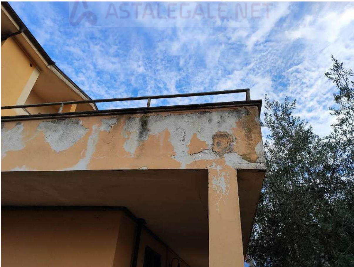
Foto 10 - Dettaglio prospetto laterale
