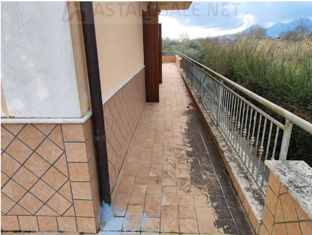
Foto 56 - Esterni piano primo
