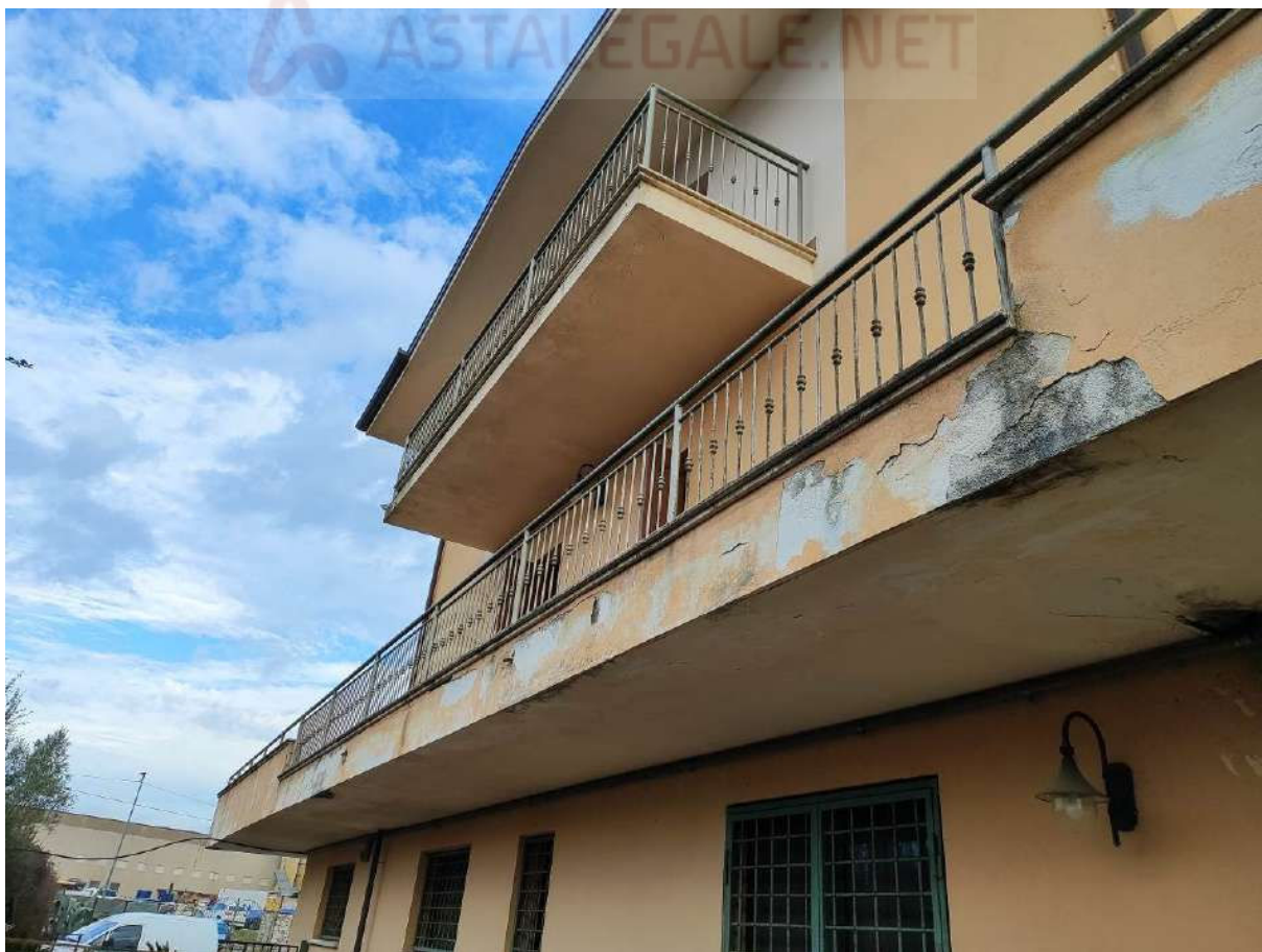
Foto 8 - Dettaglio prospetto laterale
