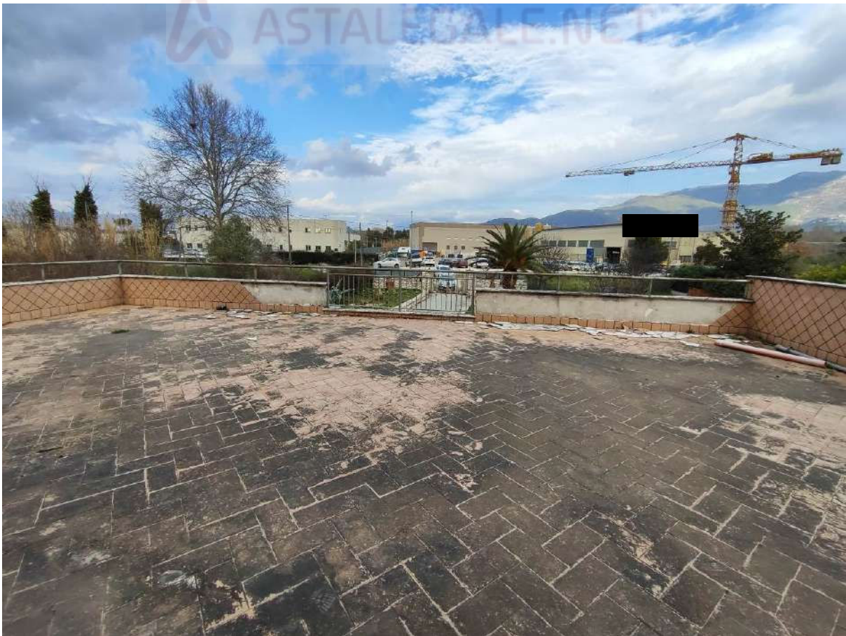
Foto 62 - Esterni piano primo
