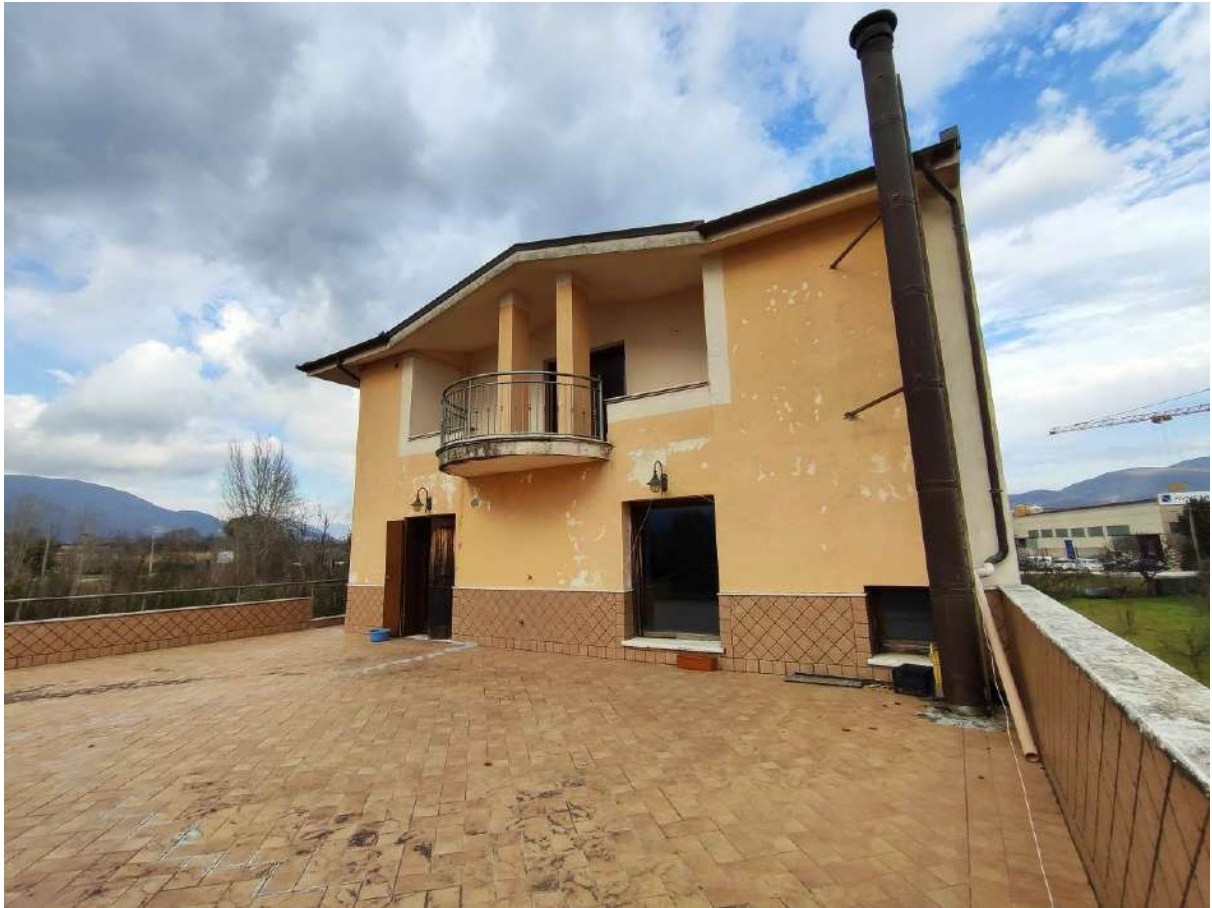
Foto 53 - Esterni piano primo
