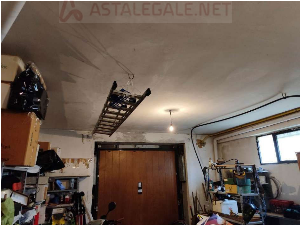
Foto 34 - Interni piano terra. garage
