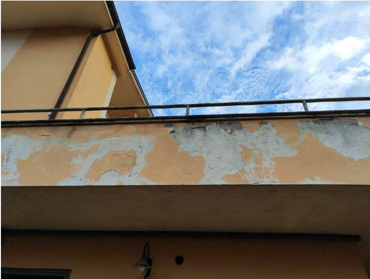
Foto 9 - Dettaglio prospetto laterale
