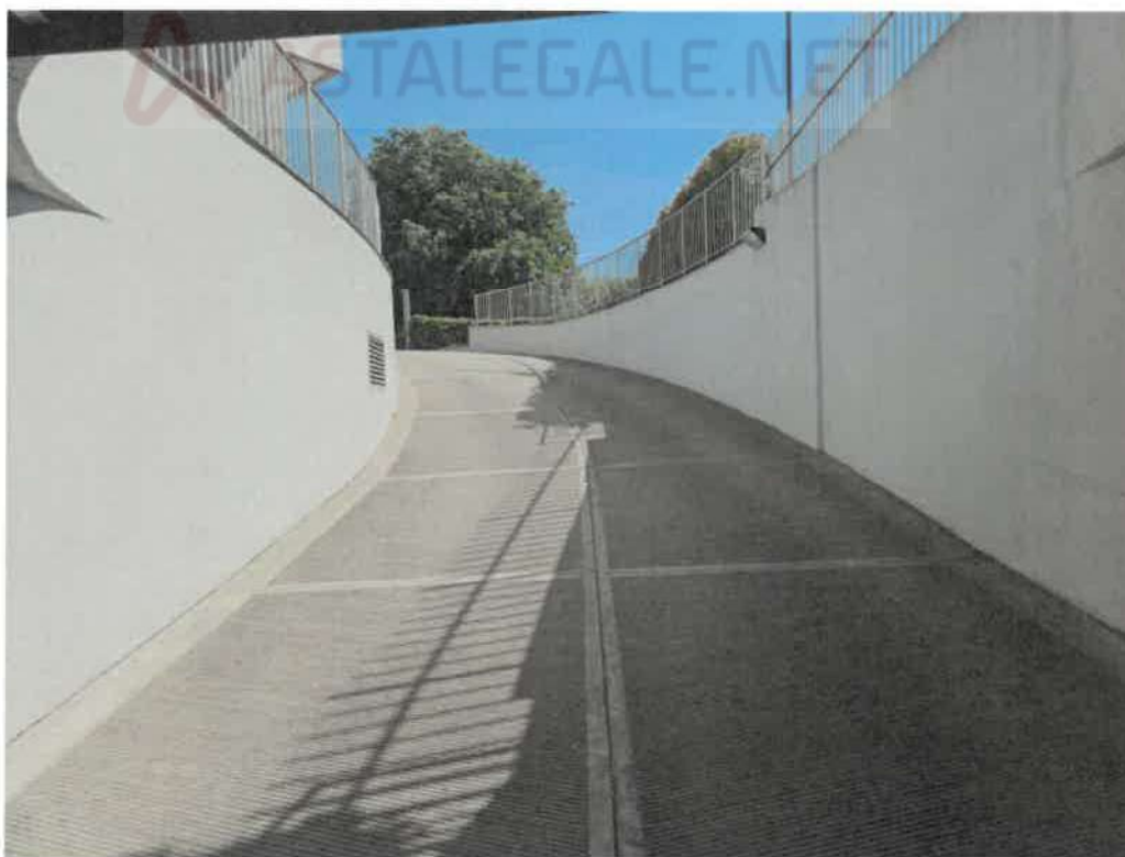
Rampa di accesso box
