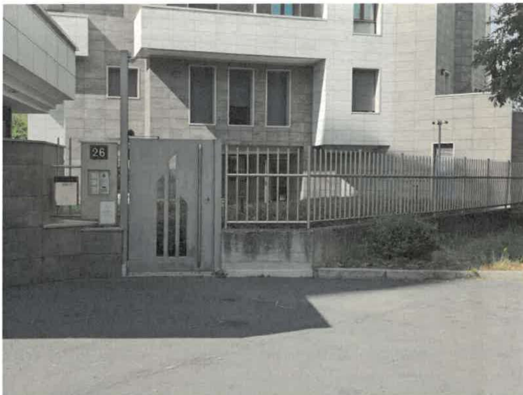
Portoncino di ingresso pedonale al complesso immobiliare
