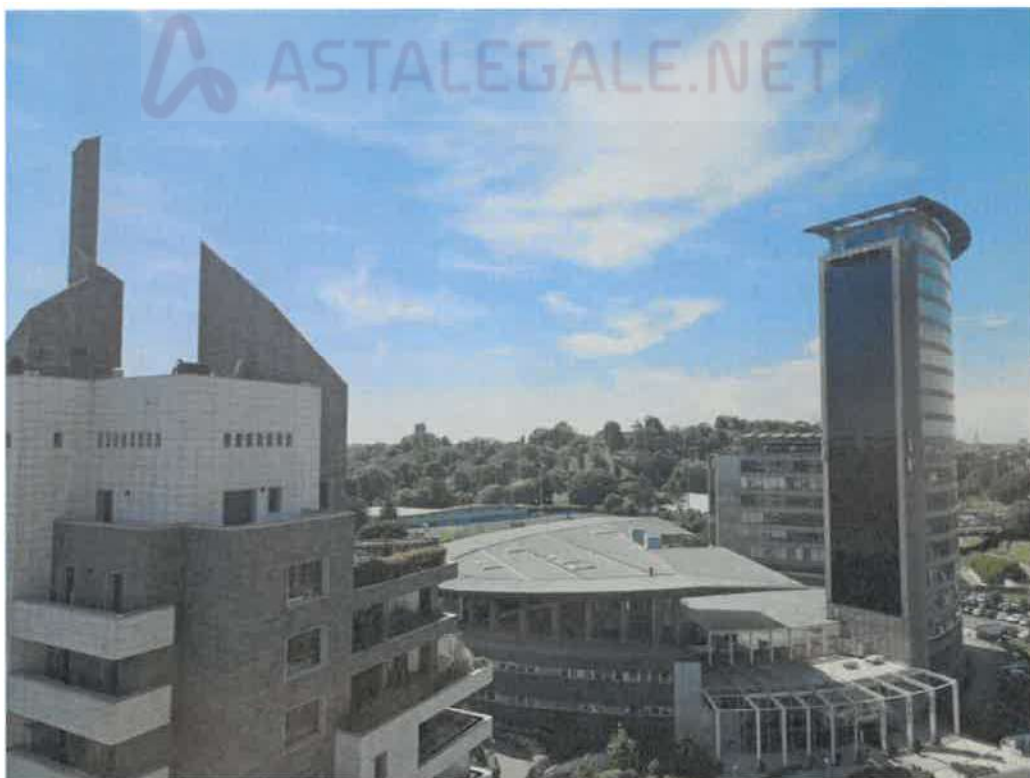
Vista verso l'esterno
