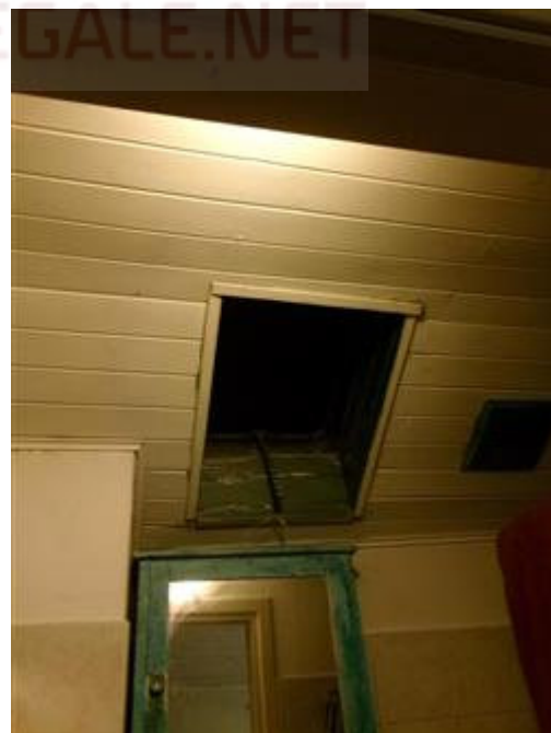
finestra tipo "velux" locale bagno
