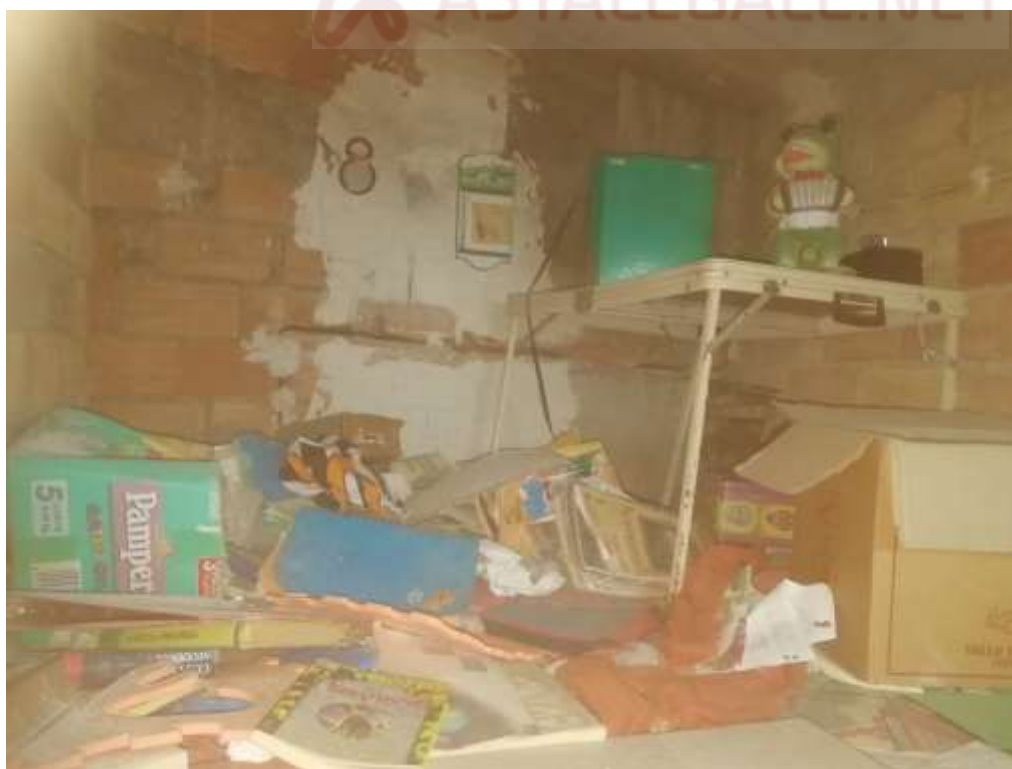
15. Foto interno sottotetto/soffitta
