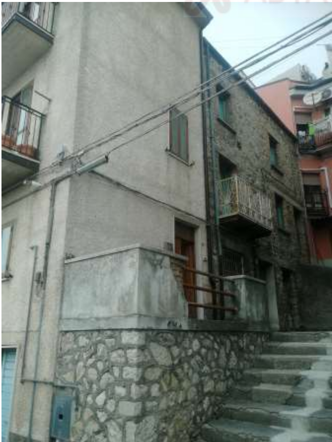
2. Foto esterna accesso dal prospetto est (scalinata/ strada pubblica)
