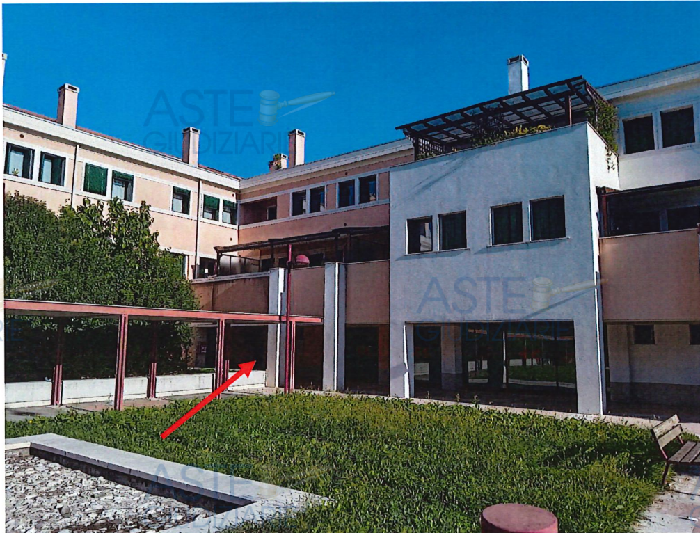
Foto 1: ingresso condominiale da P.zza del Sindacato
