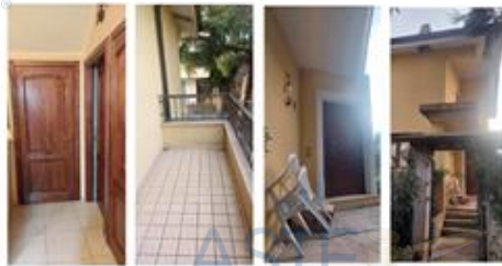
corridoio e balcone piano primo, cancello e porta di ingresso
