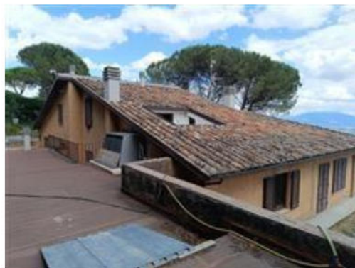
RETRO PROSPETTO E TETTO
