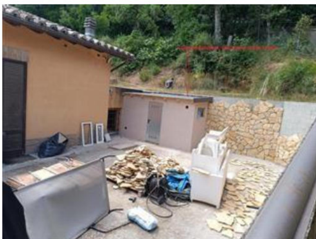
LOCALE REALIZZATO SENZA TITOLO EDILIZIO - PROSPETTO
