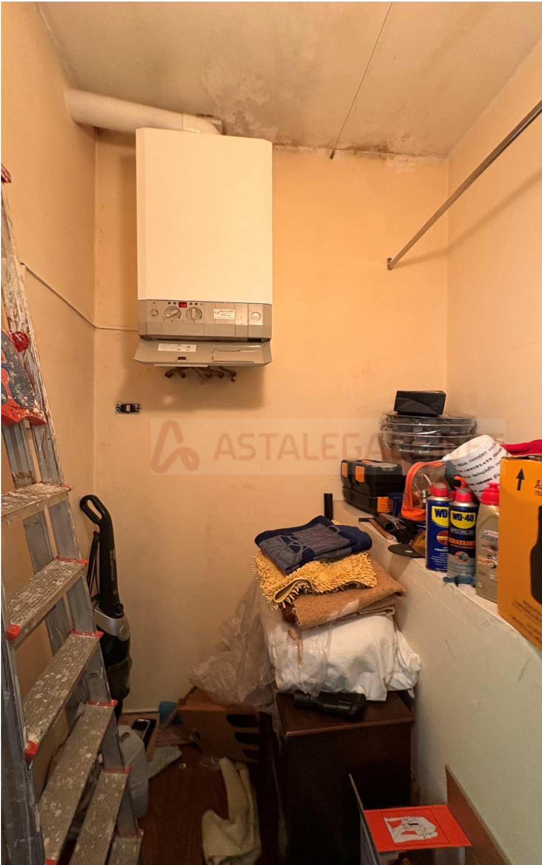
FOTO N.5 – PARTICOLARE RIPOSTIGLIO AL PIANO PRIMO
