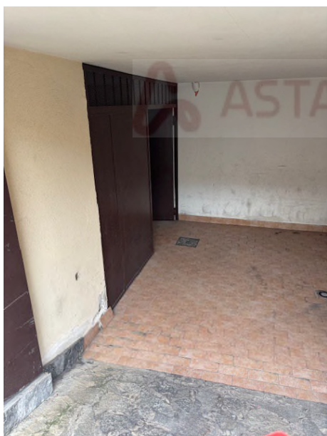
ACCESSO TRAMITE LA RAMPA CARRABILE DAL CORTILE
