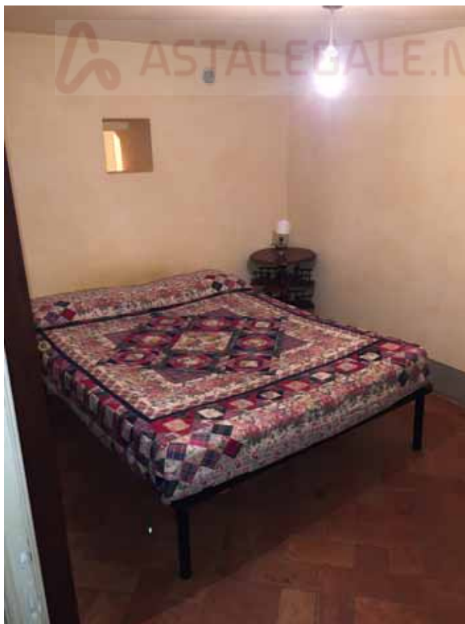
Foto 70 (zona abusiva da ripristinare)
