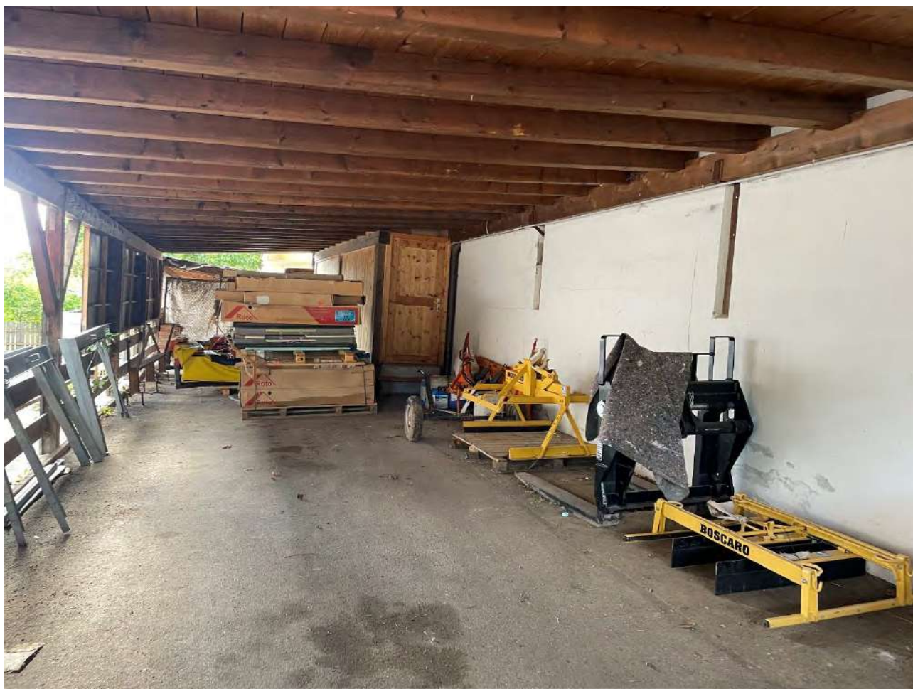
tettoia non autorizzata
