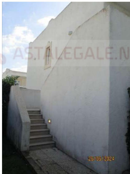
Foto n.3 – scala di accesso
