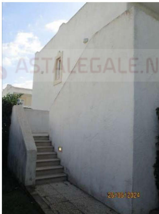
Foto n.3 – scala di accesso
