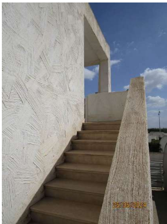
Scala di accesso all'appartamento
