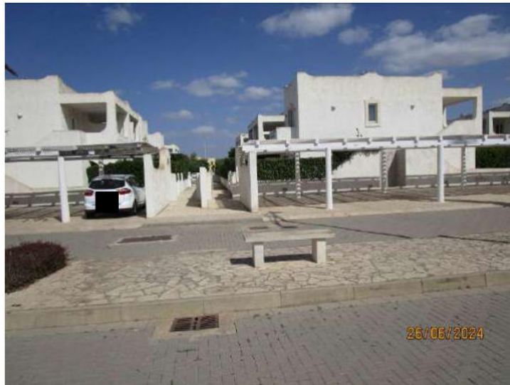
Foto n.2 – vista dei fabbricati dalla via delle Dune
