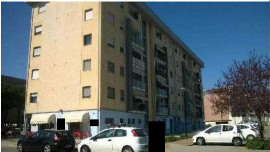
Immagine 2 – Inquadramento generale del fabbricato – prospetto Sud / Est
