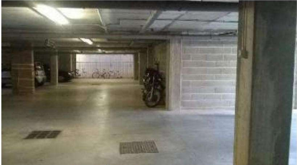
Immagine 9 – Sub. 604 area di manovra garage
