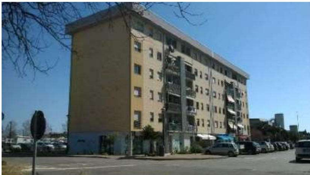
Immagine 3 – Inquadramento generale del fabbricato – Prospetto Nord / Ovest
