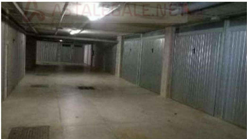
Immagine 10 – Sub. 604 area di manovra garage
