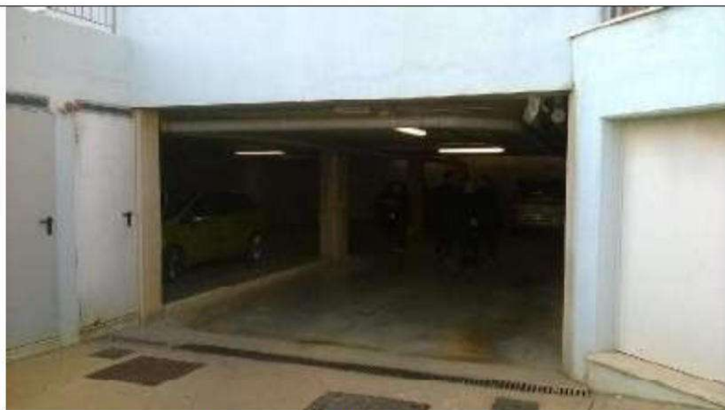
Immagine 7 – Sub. 692 Rampa esterna
