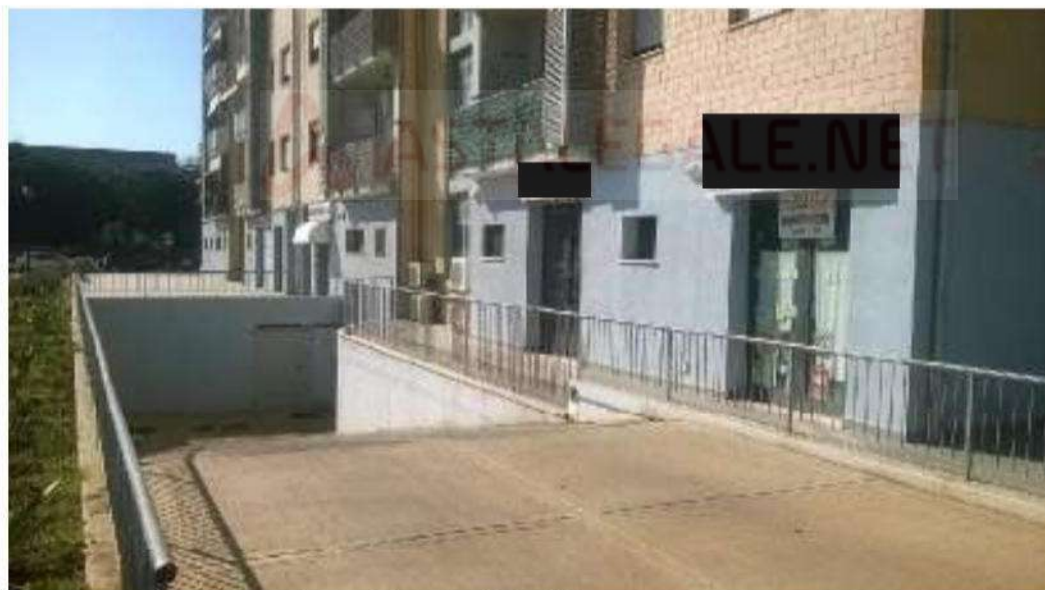
Immagine 8 – Sub. 692 rampa esterna
