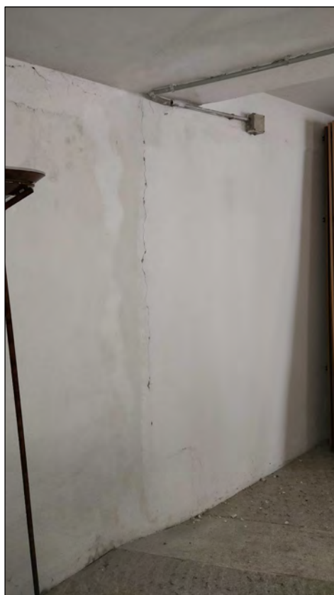
Particolare fessurazioni/umidità
