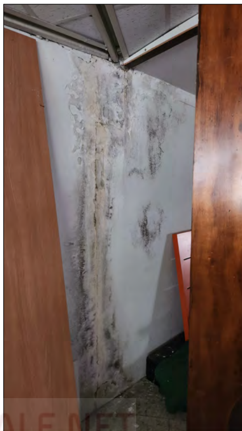
Particolare fessurazioni/umidità
