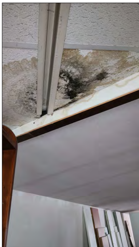
Particolare infiltrazioni/umidità
