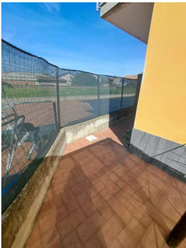
Figura 8- recinzione e pavimentazione esterna
