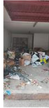
vista interna deposito con blocco servizio
