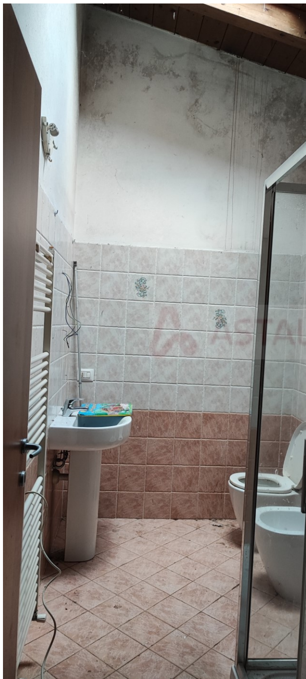
Vista interna bagno piccolo P2
