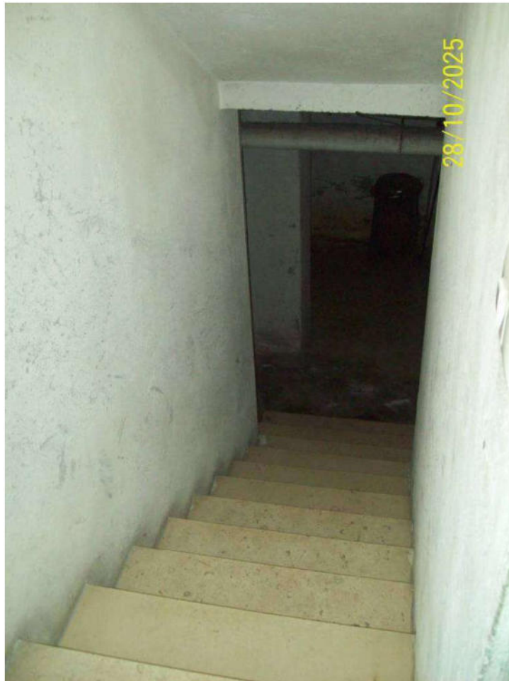
FOTO 11 – scala di accesso piano interrato - cantina “lotto 1 corpo A”
