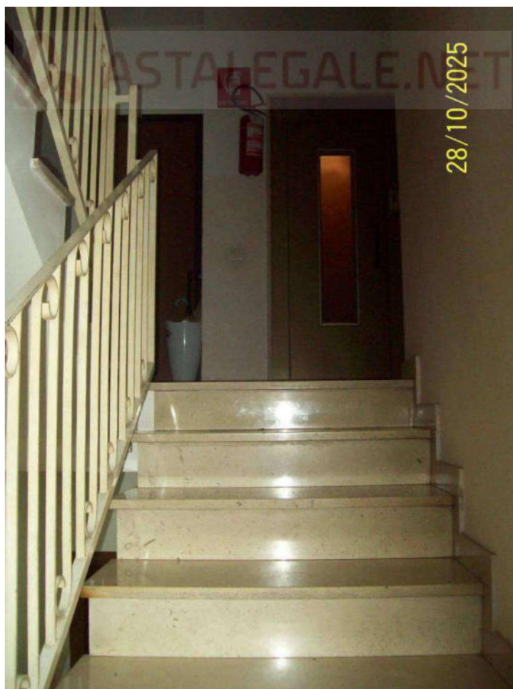
FOTO 2 – vano scala accesso abitazione “lotto 1 corpo A”
