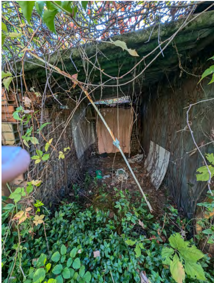
07 - Manufatto in lamiera e laterizzi
