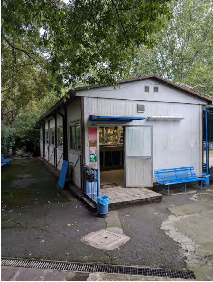
01 - Manufatto prefabbricato (lato ingresso)
