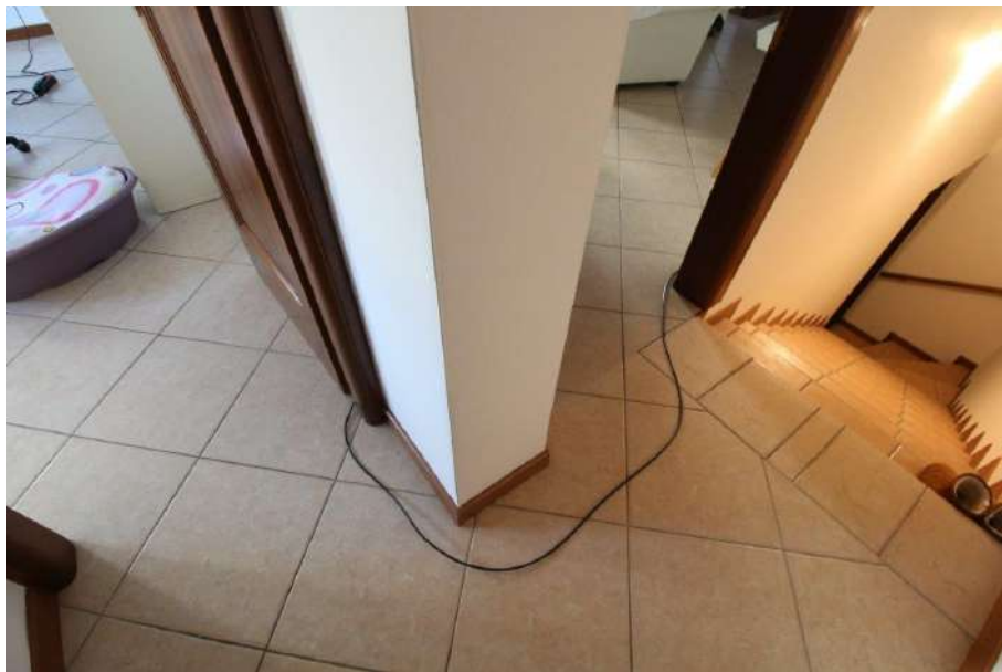
VISTA DISIMPEGNO PIANO TERRA E SCALE VERSO PIANO INTERRATO
