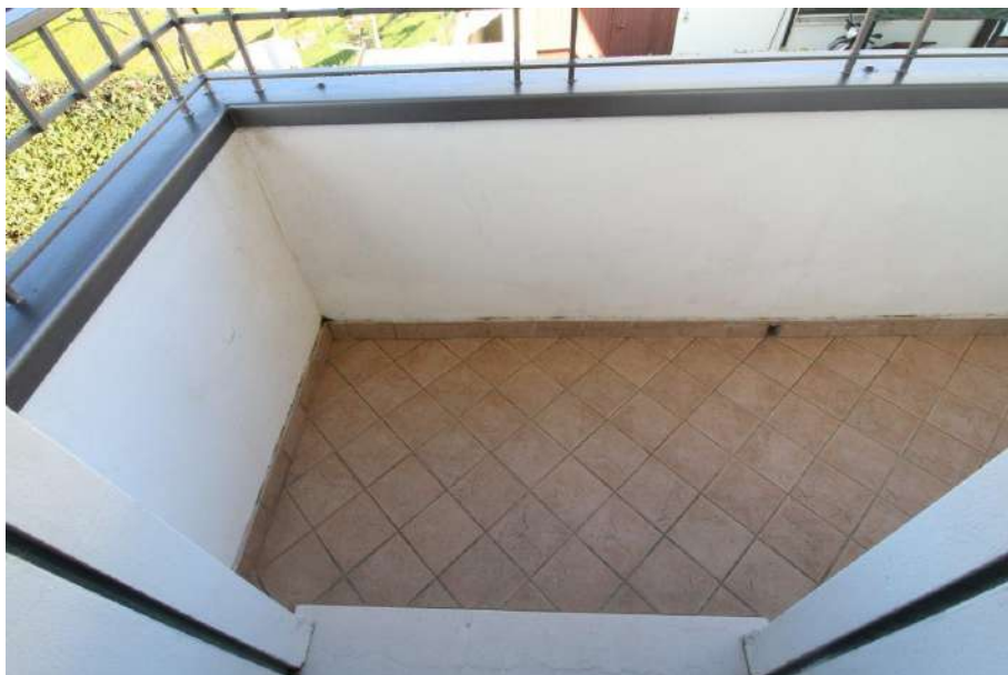
VISTA TERRAZZINO PICCOLO DA CAMERA NORD-EST
