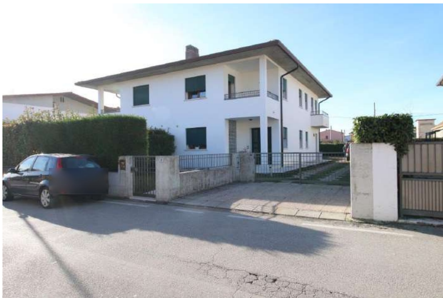
VISTA NORD-EST DA VIA G. VERDI
