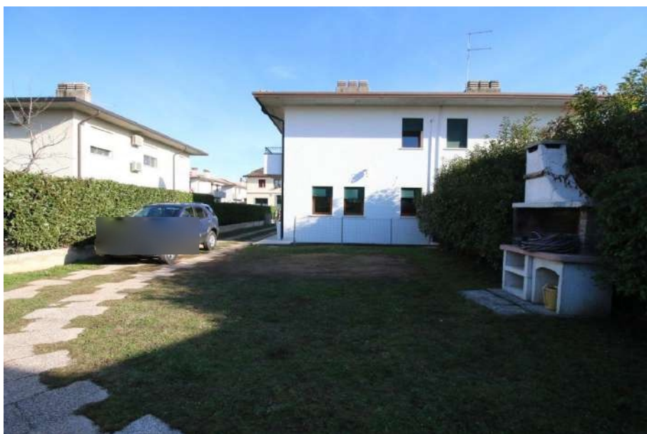
VISTA OVEST DA GIARDINO RETRO
