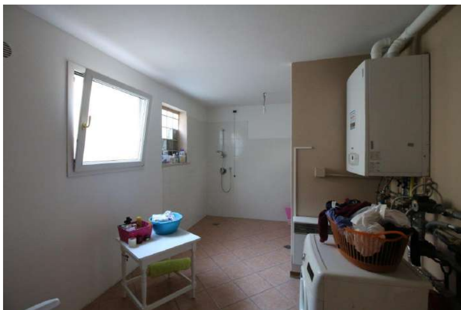
VISTA LAVANDERIA E CENTRALE TERMICA PIANO INTERRATO
