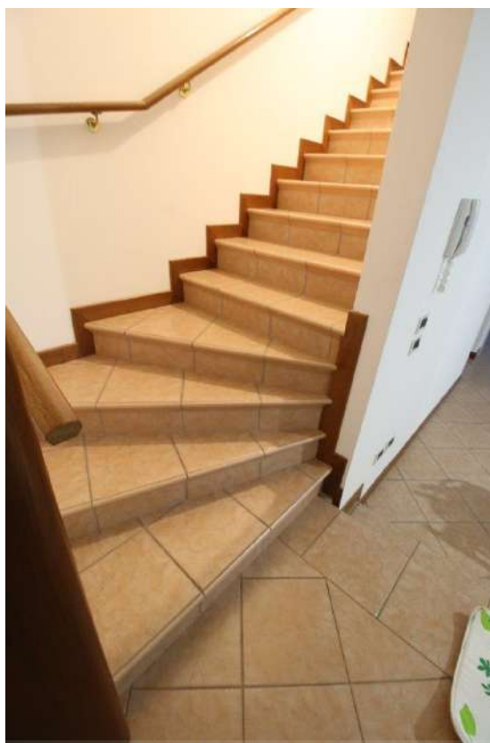
VISTA INIZIO SCALE TRA PIANO INTERRATO E PIANO TERRA
