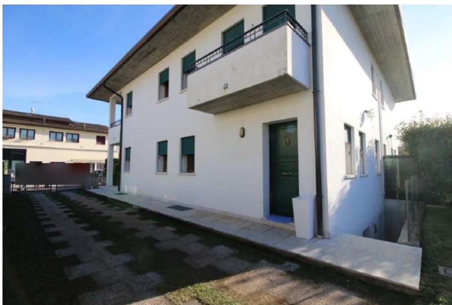
VISTA NORD-OVEST DA VIALETTO
