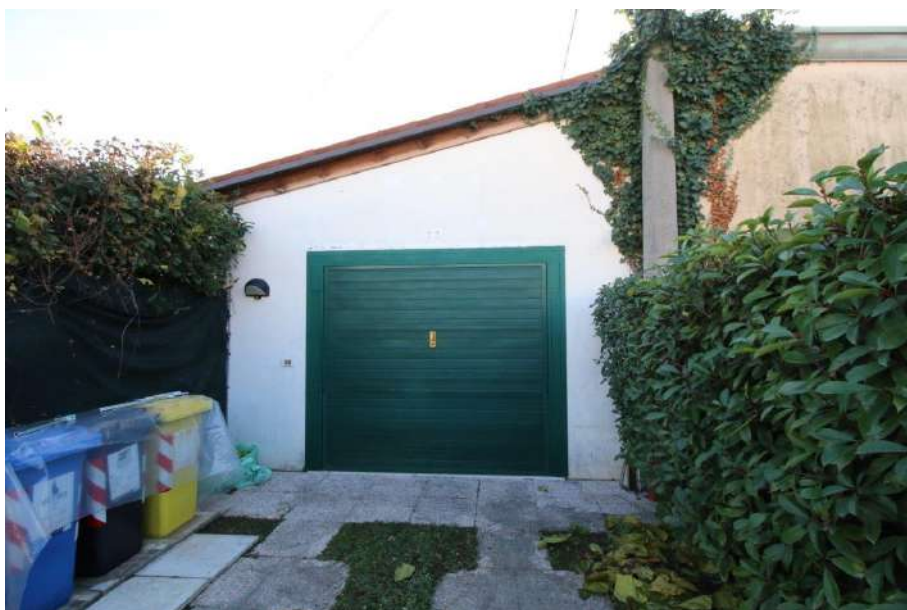
VISTA ESTERNA AUTORIMESSA
