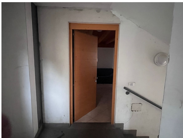
Fig.3 – l'ingresso all'unità, dal ballatoio comune del secondo piano
