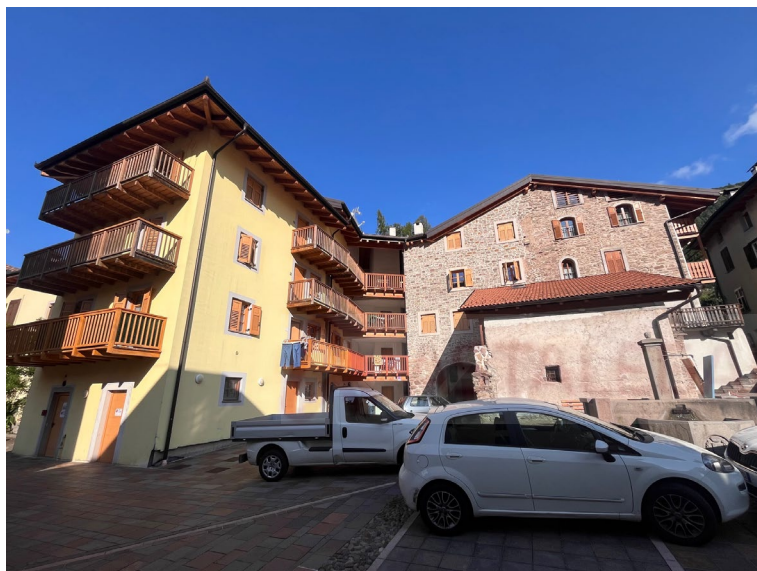
Fig.2 – i fronti sud e ovest dell'edificio
