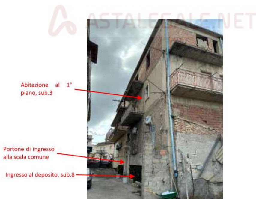
Foto 2: Vista fabbricato dalla corte interna.
