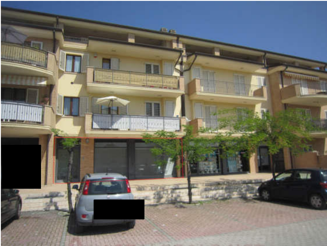
Lotto n.02 Foto n.07 (vista da via Trentino sud) sub.83
