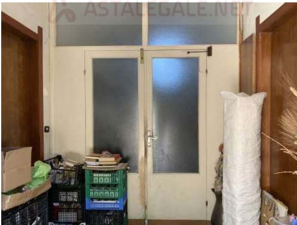
FOTO 4 – INGRESSO PIANO TERRA
