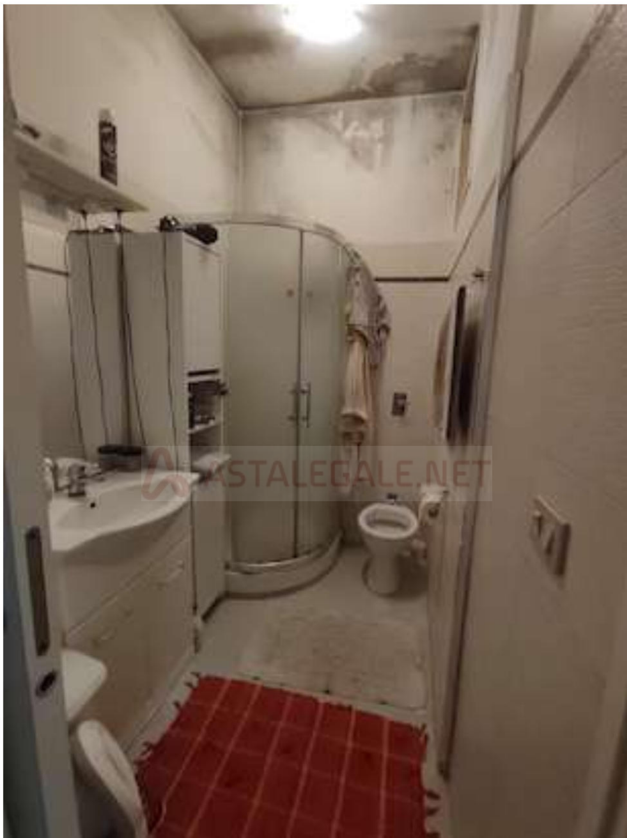
Foto 13 Lotto 1 – Bagno appartamento a piano primo
