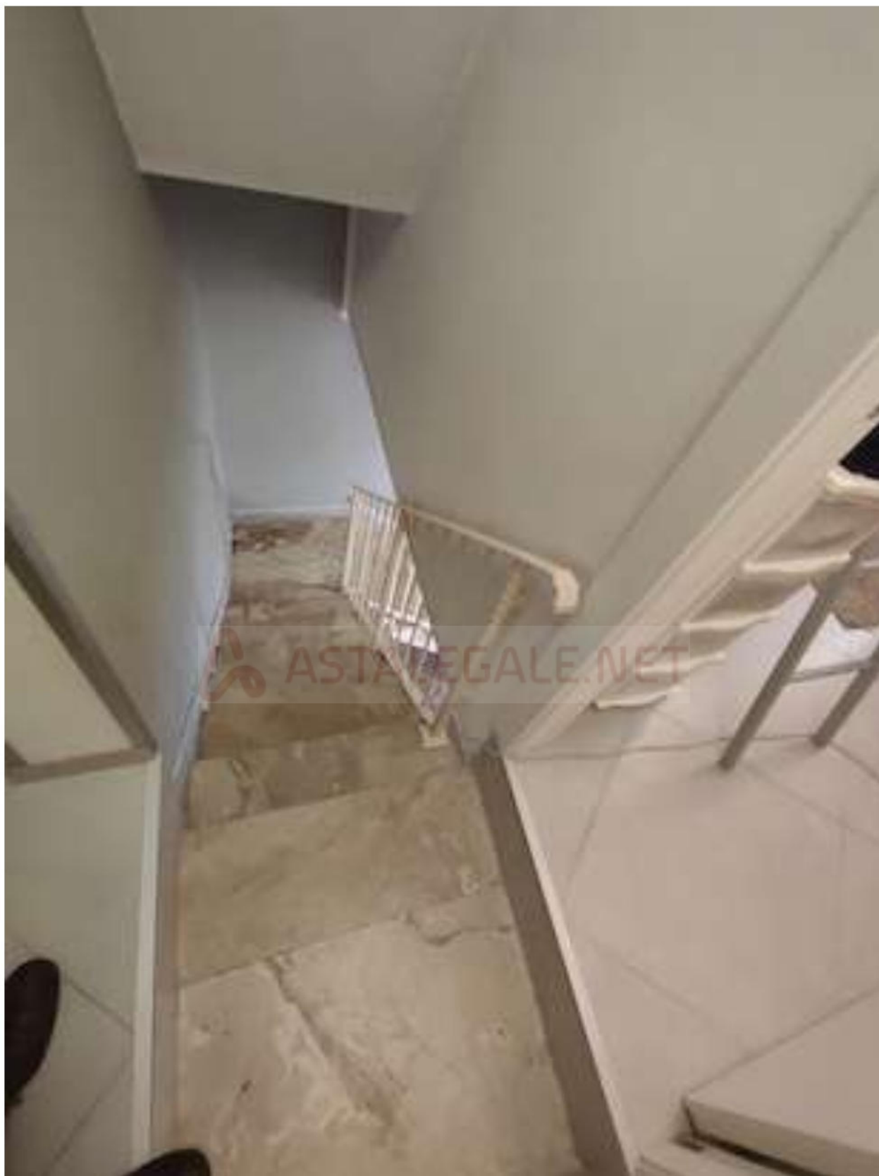
Foto 9 Lotto 1 – Vano scala appartamento dal piano terra al piano primo
