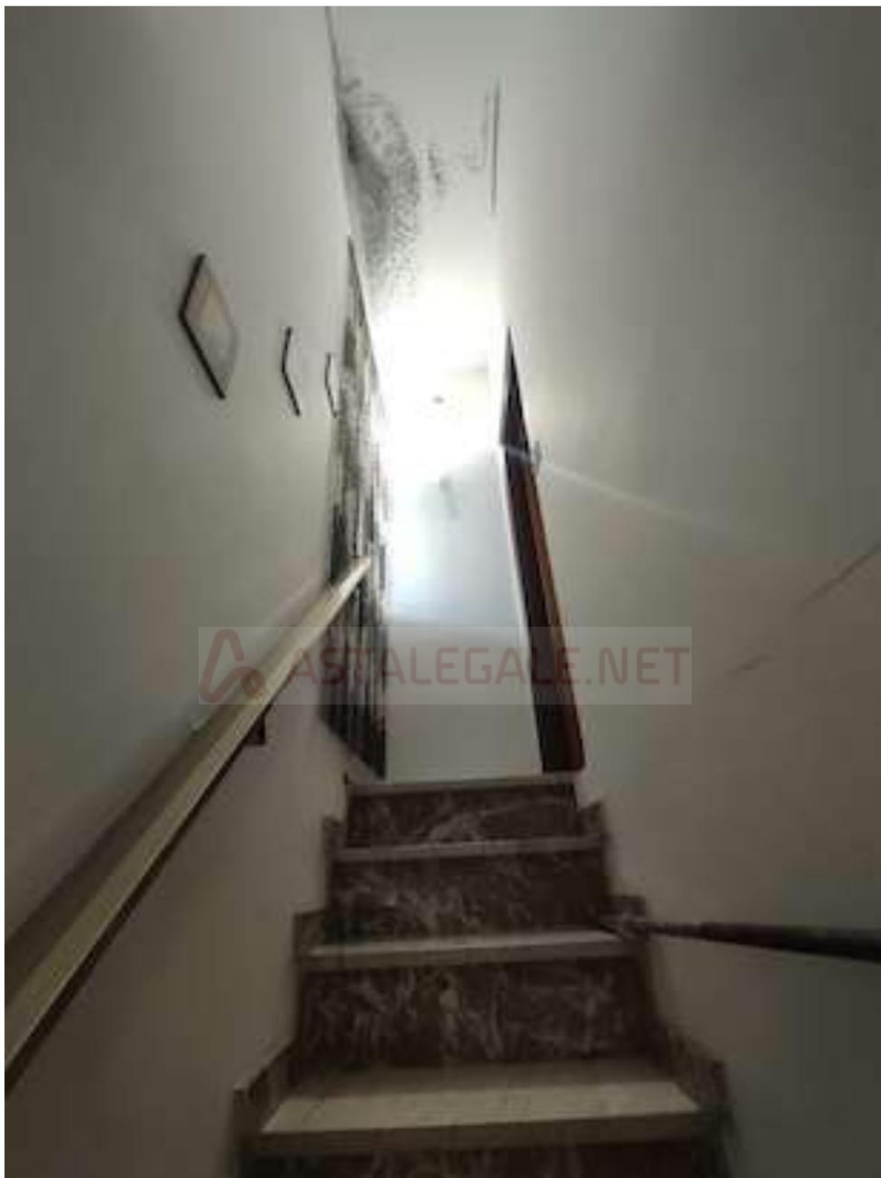
Foto 17 Lotto 1 – Vano scala appartamento dal piano primo al piano secondo
