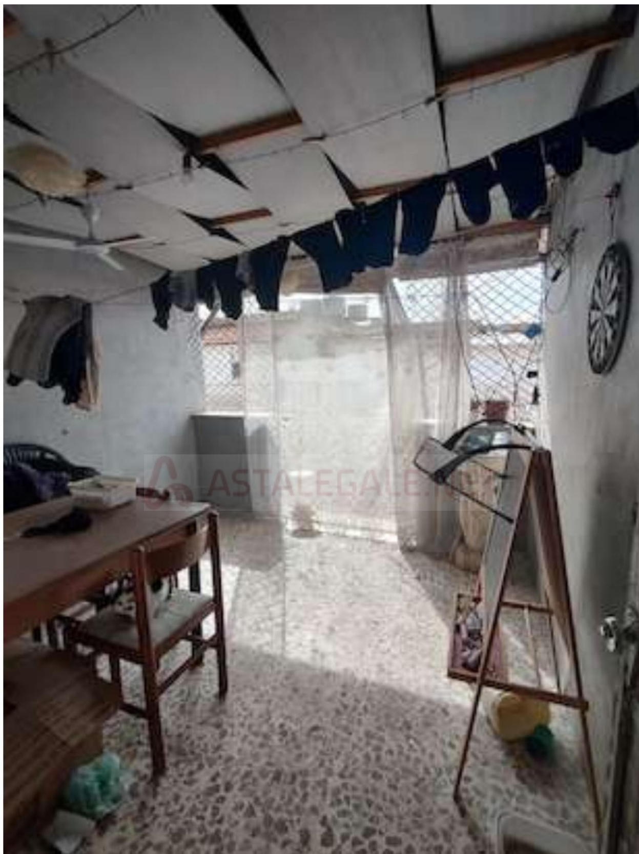
Foto 21 Lotto 1 – Terrazzo appartamento a piano secondo
