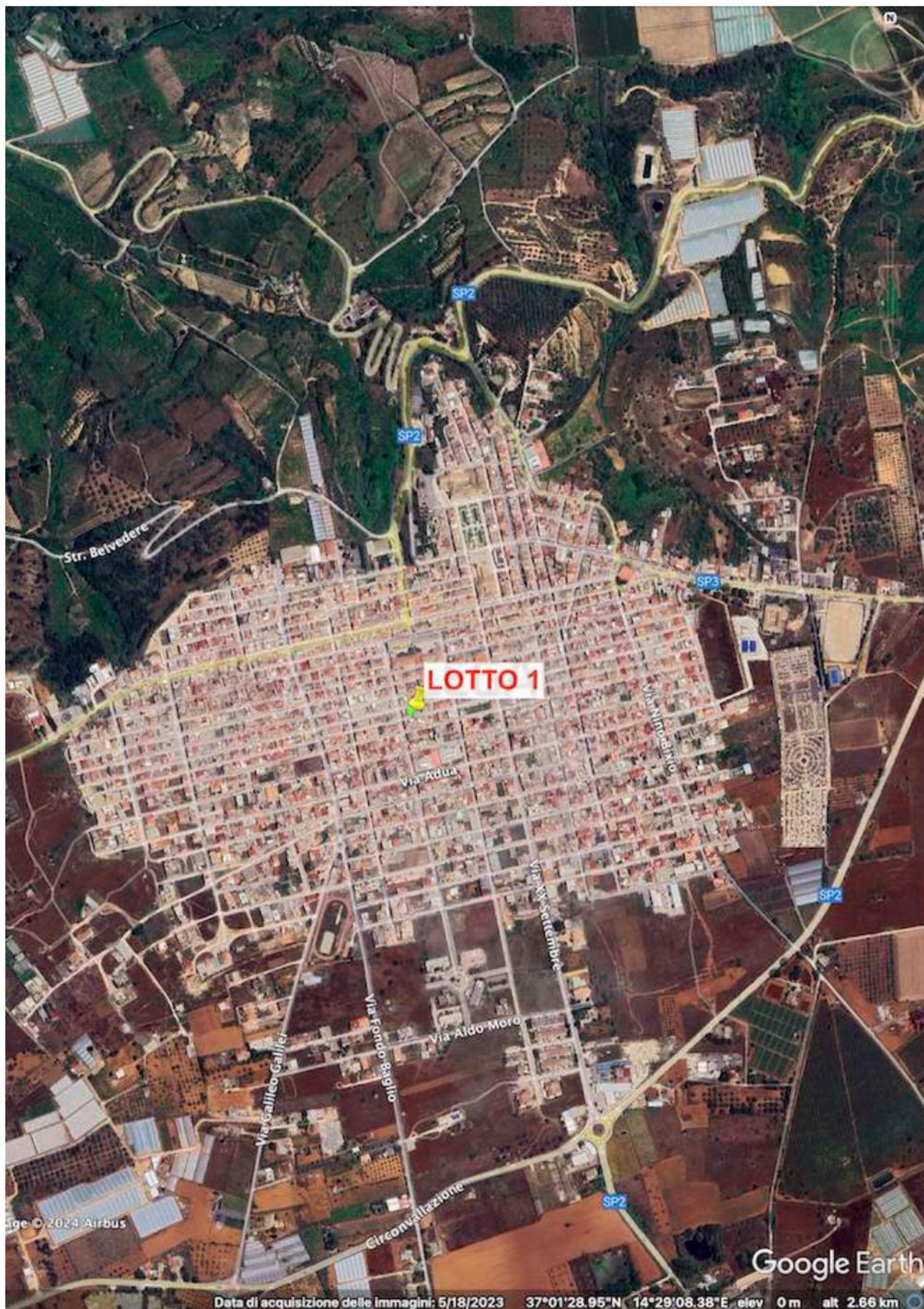
Figura 2 Lotto 1 – Foto aerea Google Foglio 68 Acate estesa con ubicazione immobili
