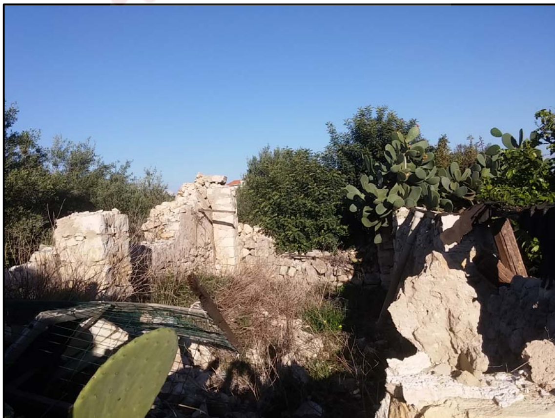
FOTO 17 – SUB.6 – CORPO "L"
