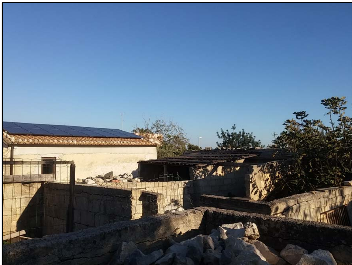
FOTO 14 – SUB.6 – CORPO "G"
