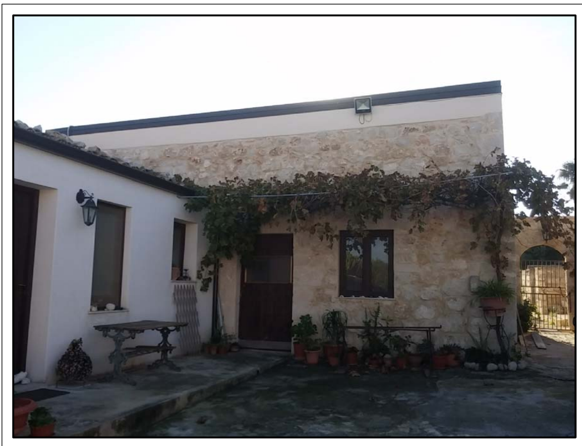
FOTO 18 – SUB.8 – UNITA' ABITATIVA "E" – Prospetto Nord-Est
