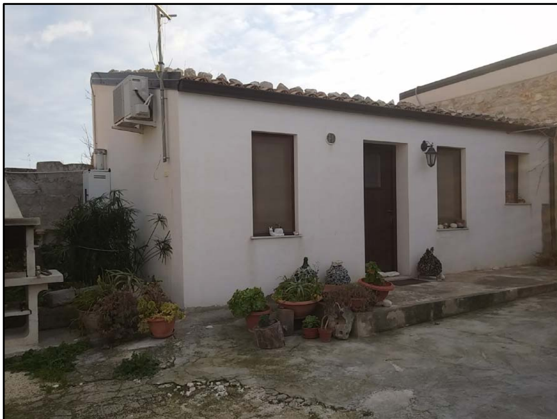
FOTO 11 – SUB.4 – UNITA' ABITATIVA "F" – Prospetto Nord–Ovest
