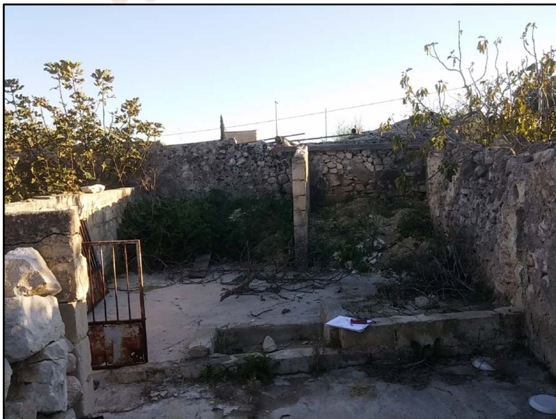
FOTO 15 – SUB.6 – CORPO "H"
