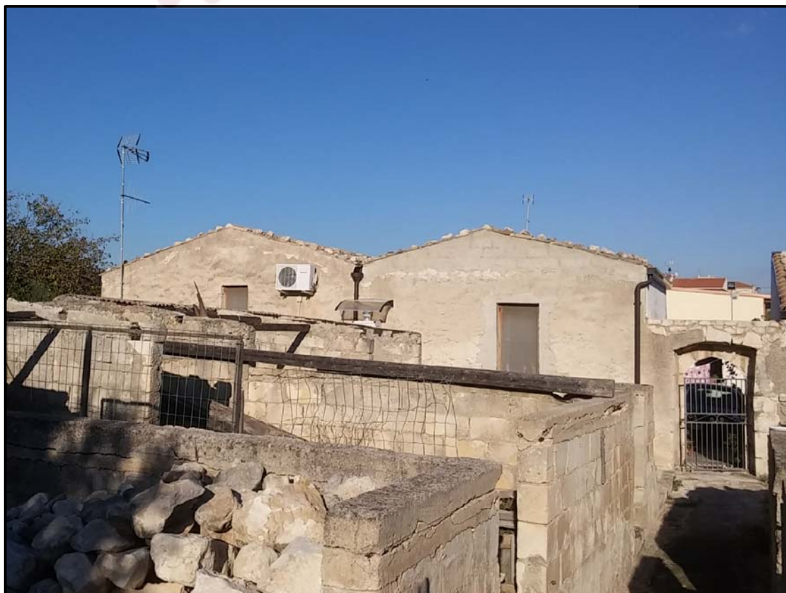
FOTO 23 – SUB.9 – UNITA' ABITATIVA "D" – Prospetto Sud.–Ovest
