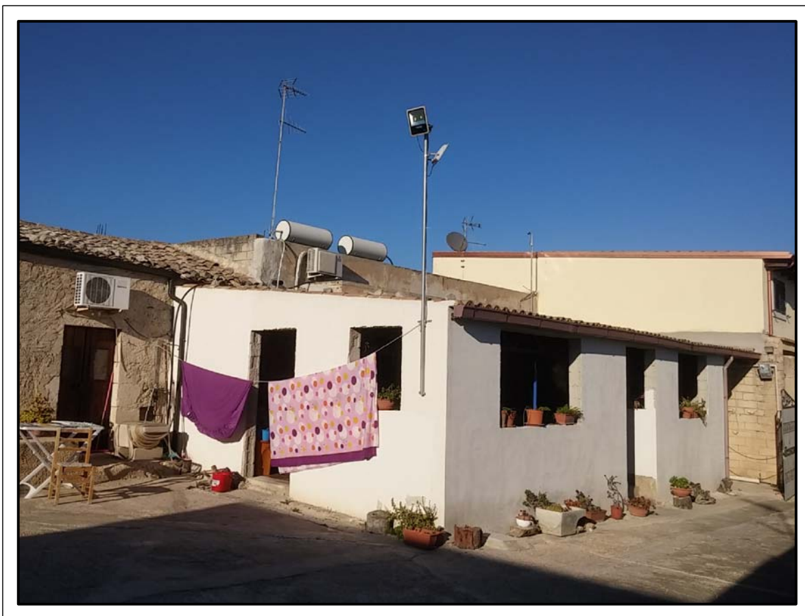
FOTO 3 – SUB.4 – UNITA' ABITATIVA "A" – Prospetto Sud–Est
