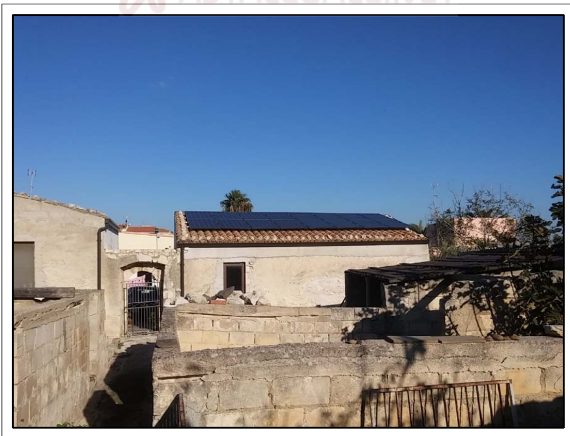
FOTO 19 – SUB.8 – UNITA' ABITATIVA "E" – Prospetto Sud-Ovest
