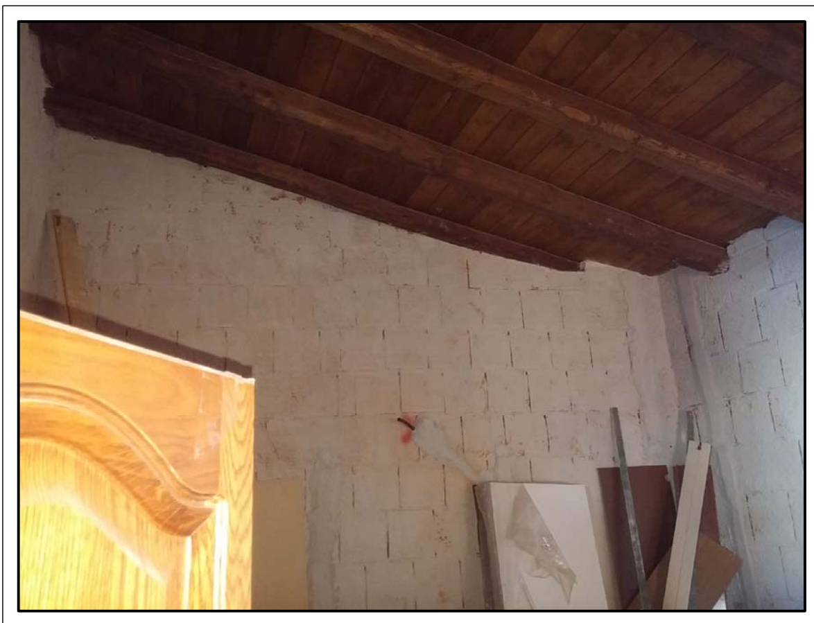
FOTO 20 – SUB.8 – UNITA' ABITATIVA "E" – Vano 1
