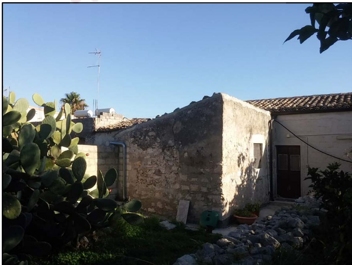
FOTO 8 – SUB.4 – UNITA' ABITATIVA "B" – Prospetto Nord–Ovest
