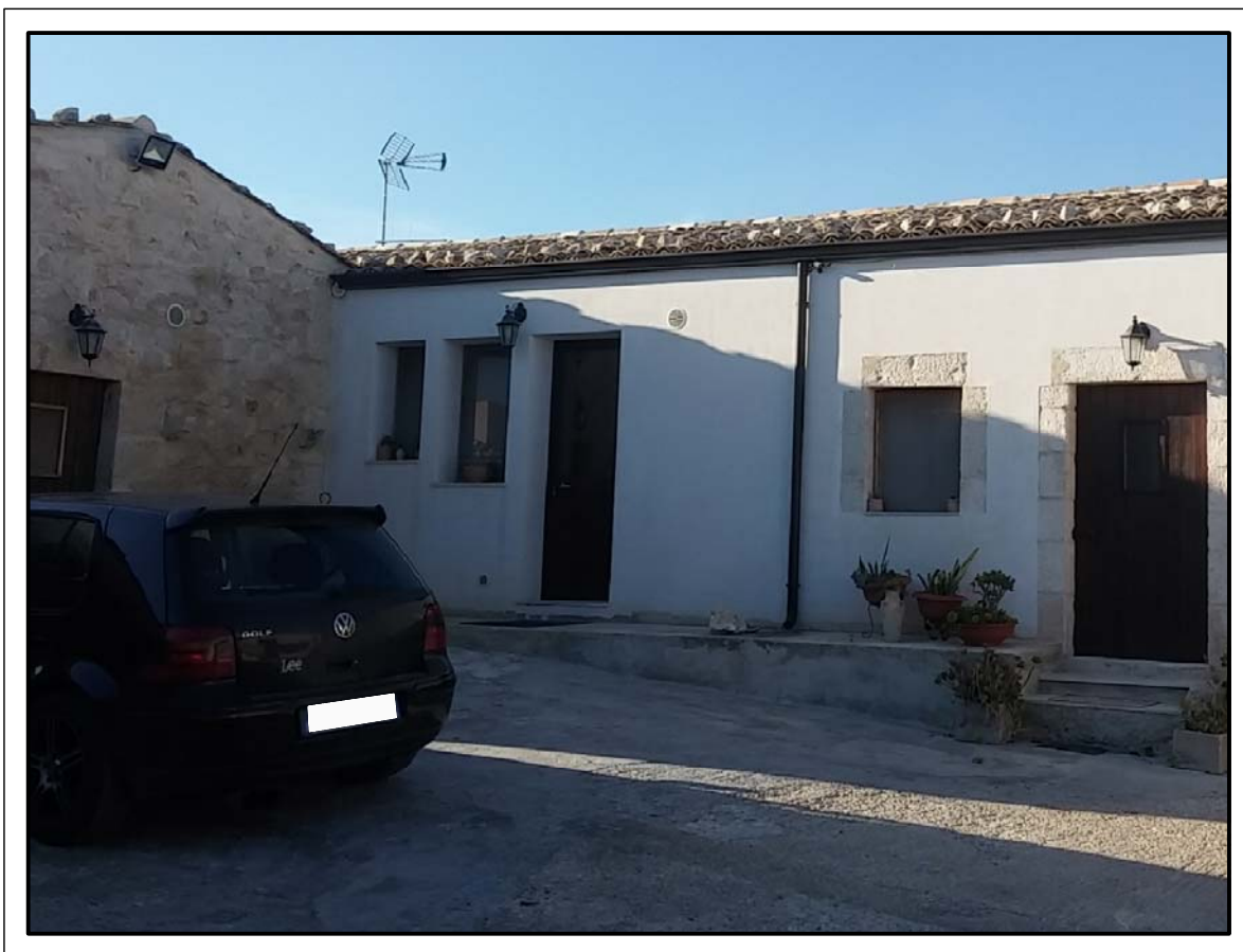
FOTO 26 – SUB.10 – UNITA' ABITATIVA "C" – Prospetto Sud-Est
