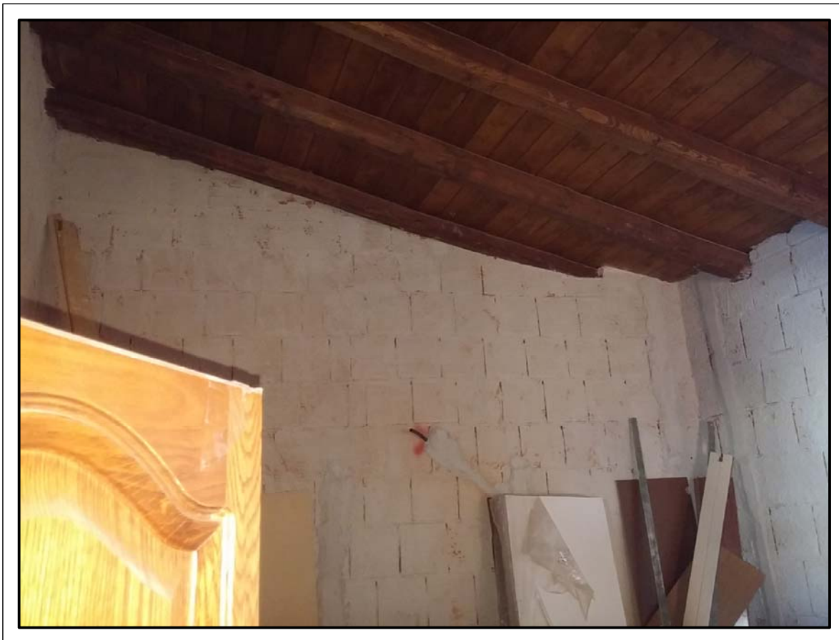
FOTO 20 – SUB.8 – UNITA' ABITATIVA "E" – Vano 1
